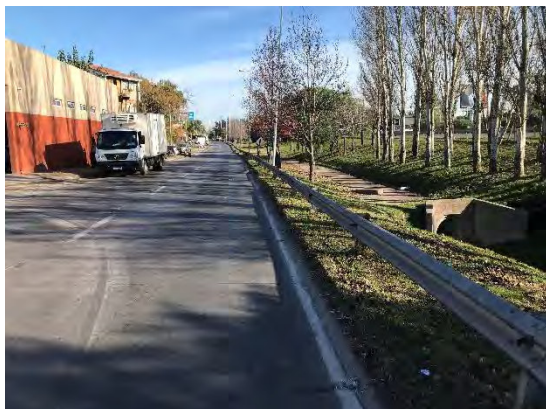
Foto 47: Colectora Sur Avda. J. D. Perón desde Los Paraísos hacia Paso de los Libres
