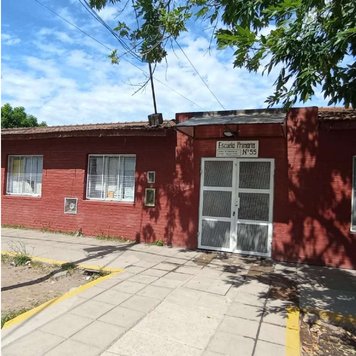
Figura 39. Escuela n°55. Fuente: Relevamiento propio DEAS, Departamento de Proyectos – DPH. Enero 2023.
