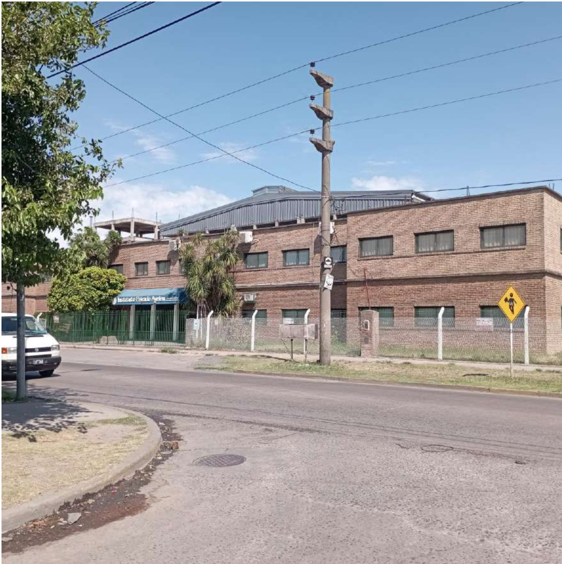
Figura 60. Instituto Ayelén. Fuente:Relevamiento propio DEAS, Departamento de Proyectos – DPH. Enero 2023.
