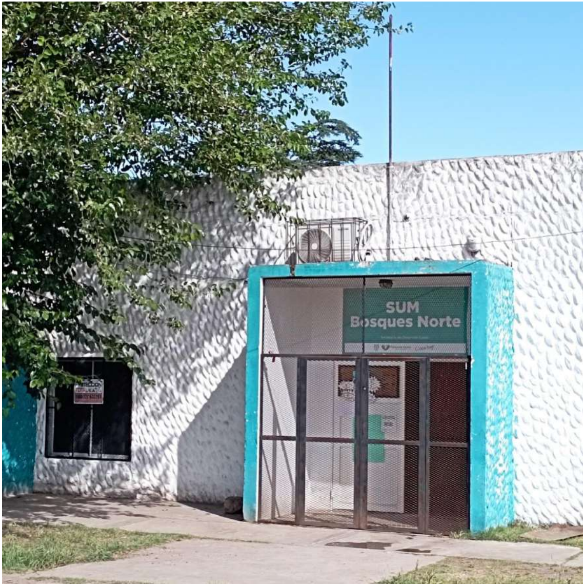
Figura 71. Salón Usos Múltiples Bosques Norte. Fuente Relevamiento propio DEAS, Departamento de Proyectos – DPH. Enero 2023.
