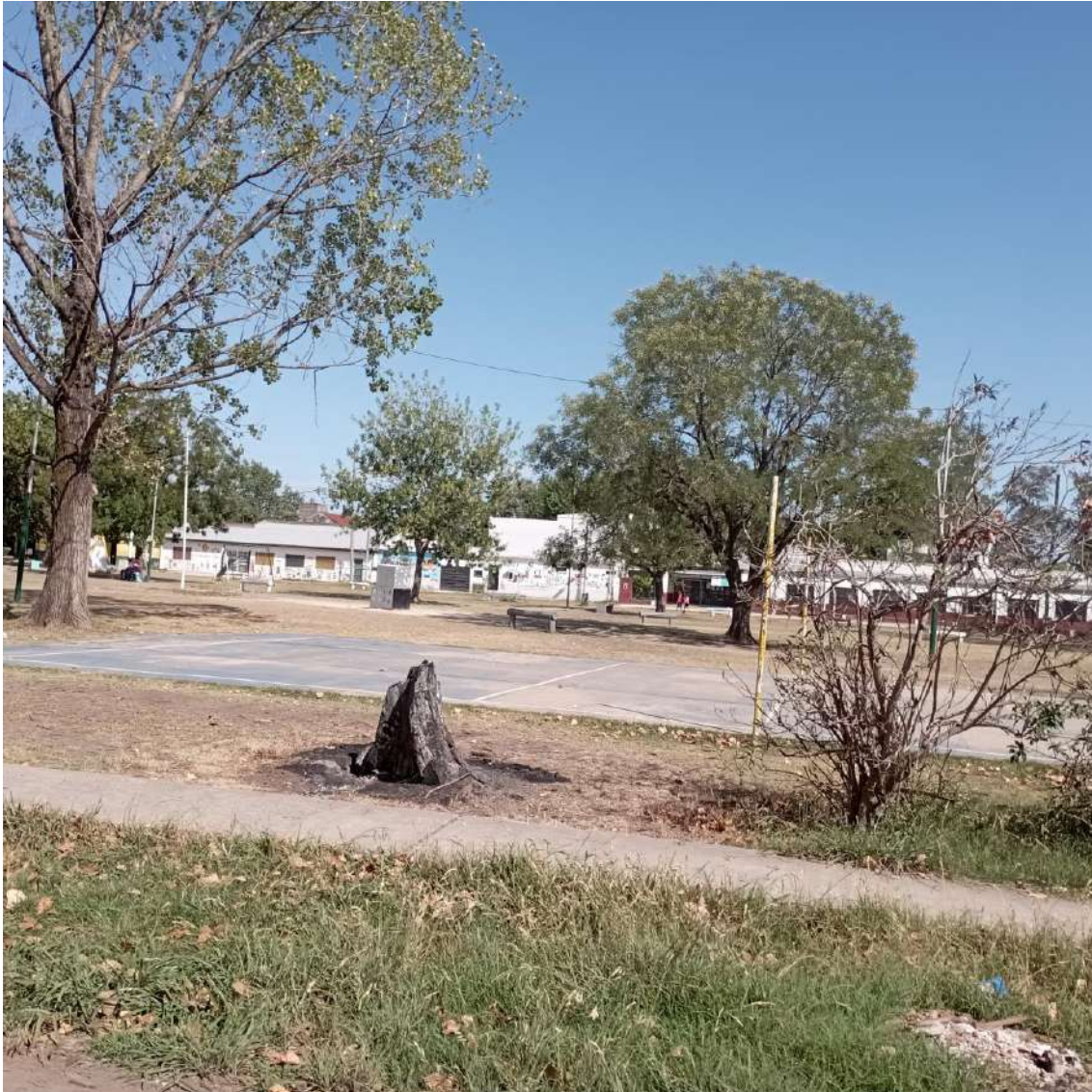
Figura 59. Escuela primaria n°58. Fuente:Relevamiento propio DEAS, Departamento de Proyectos – DPH. Enero 2023.
