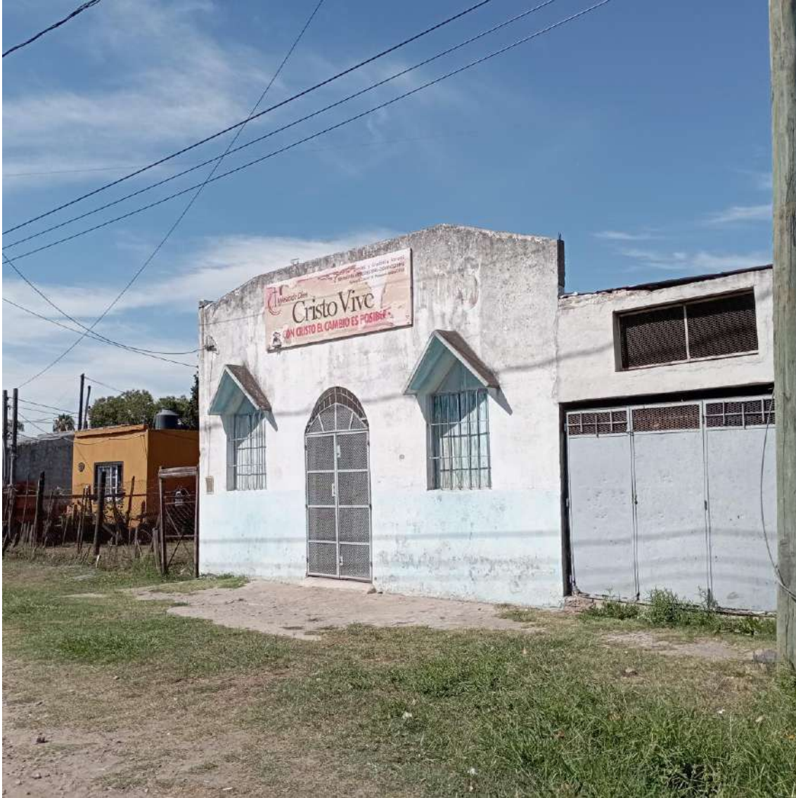
Figura 74. Iglesia de dios Cristo vive. Fuente:Relevamiento propio DEAS, Departamento de Proyectos – DPH. Enero 2023.
