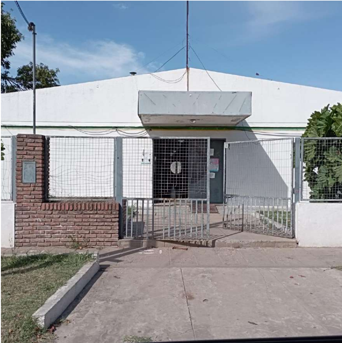
Figura 62. Centro de Salud – Bosques. Fuente: Relevamiento propio DEAS, Departamento de Proyectos – DPH. Enero 2023.
