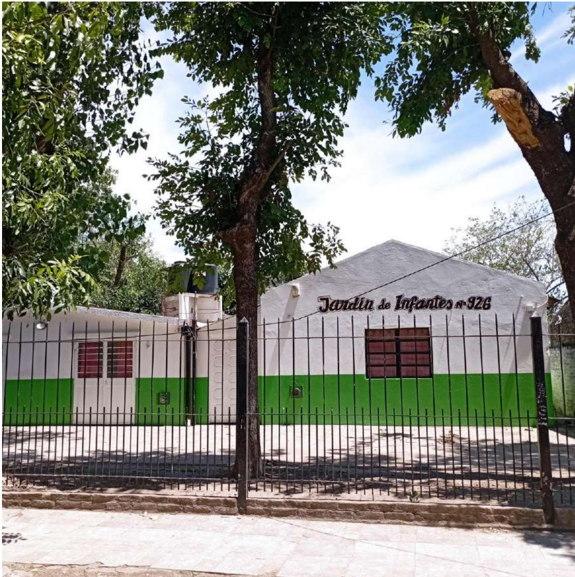
Figura 41. Jardín de infantes n°926. Fuente: Relevamiento propio DEAS, Departamento de Proyectos – DPH. Enero 2023.
