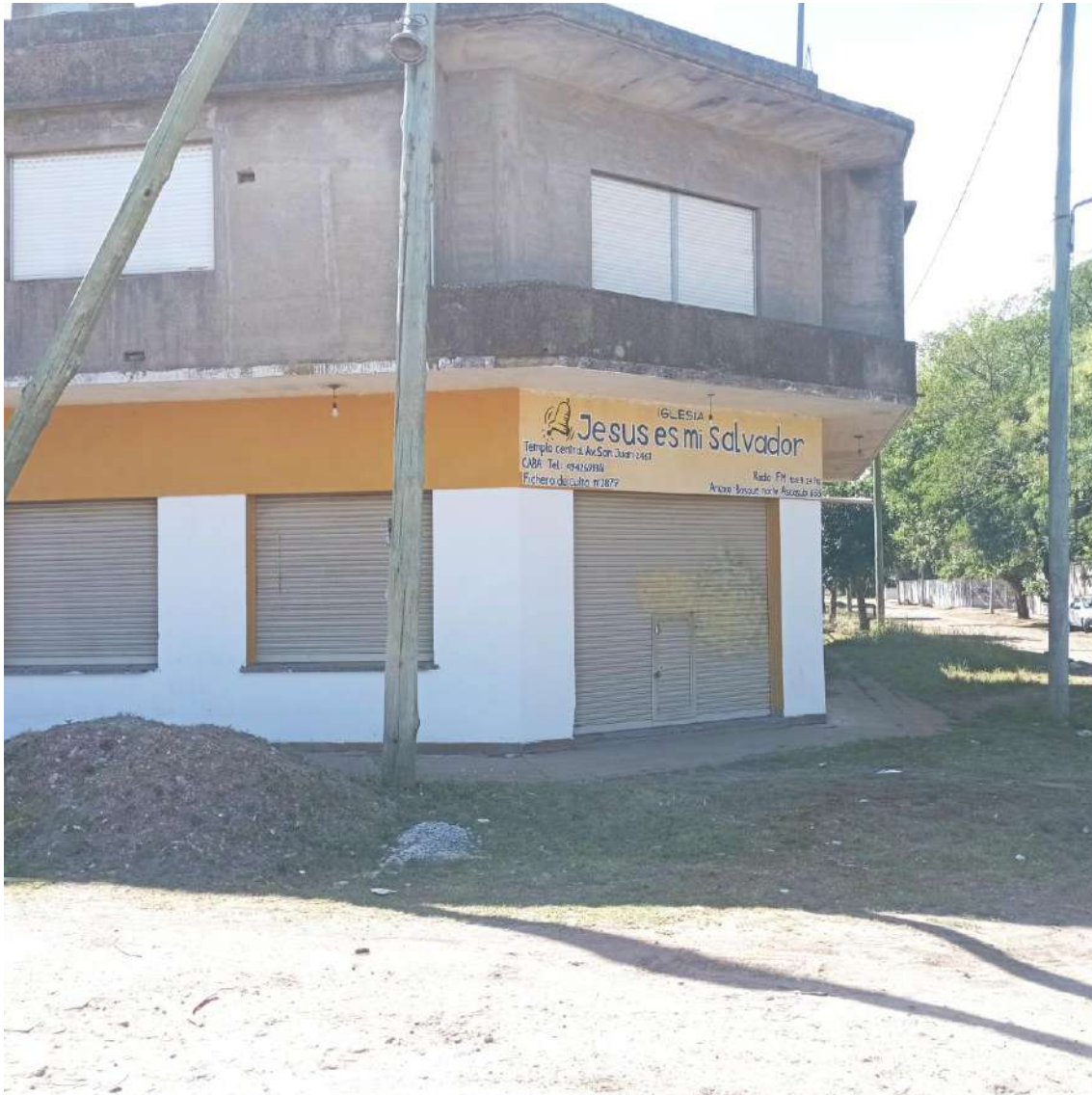
Figura 72. Iglesia Jesus es mi salvador. Fuente: Relevamiento propio DEAS, Departamento de Proyectos – DPH. Enero 2023.
