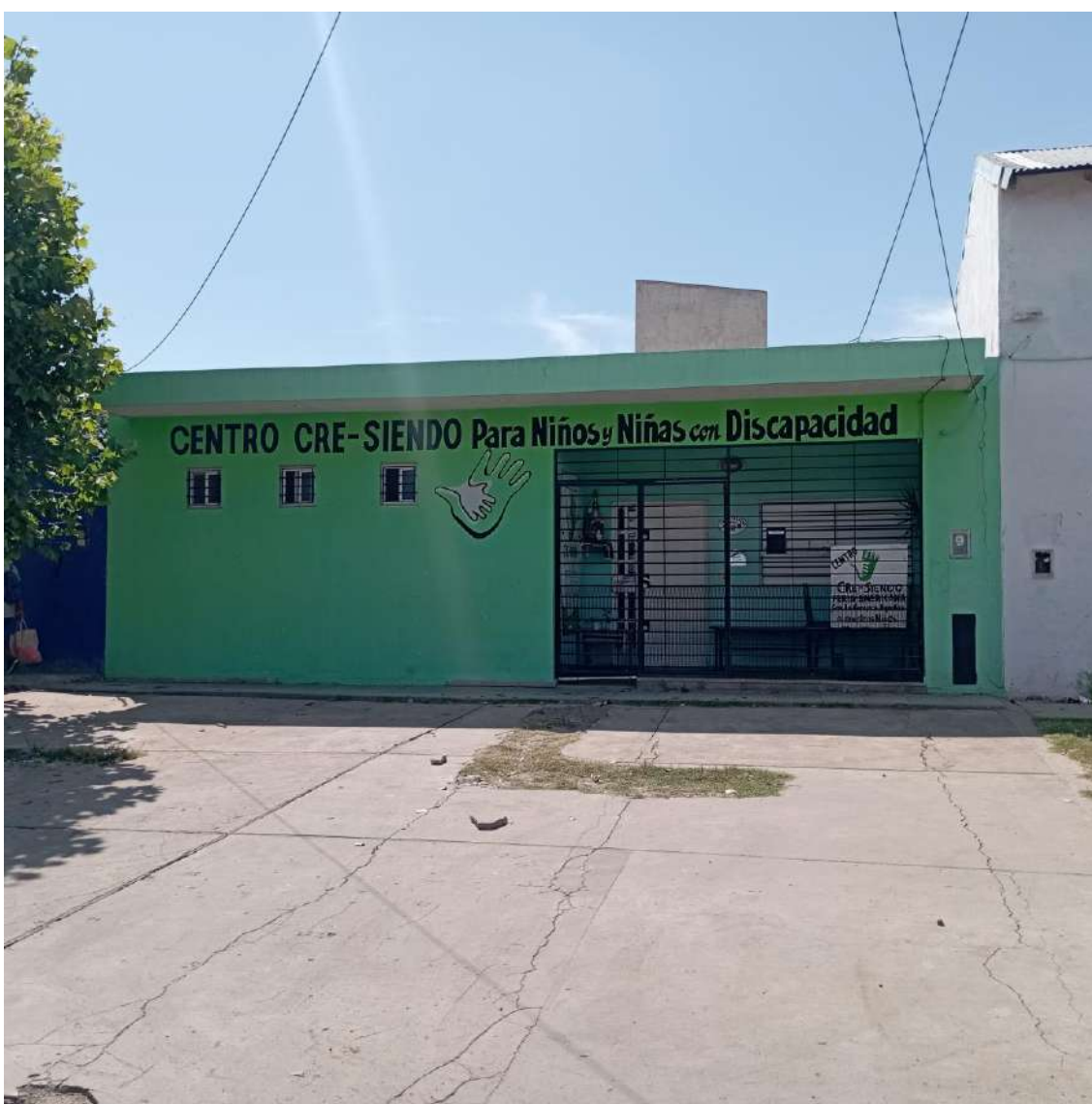
Figura 43. Cre-siendo centro de rehabilitación. Fuente: Relevamiento propio DEAS, Departamento de Proyectos – DPH. Enero 2023.
