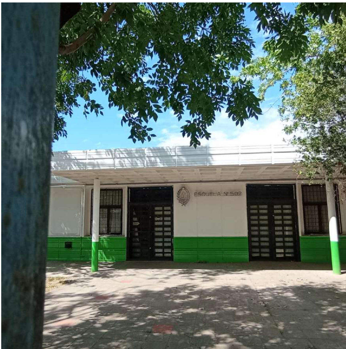
Figura 38. Escuela n°502. Fuente: Relevamiento propio DEAS, Departamento de Proyectos – DPH. Enero 2023.
