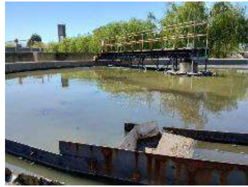
Figura12: Sedimentador secundario
