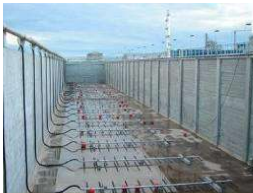
Figura 18. Cámara de aireación similar a la proyectada
