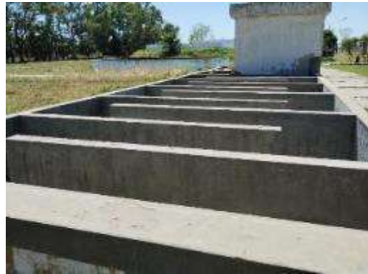
Figura 13:..Cámara de contacto y cloración.
