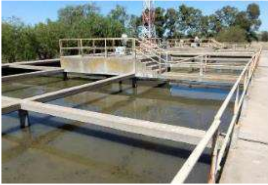
Figura11.:Tanque de aireación.
