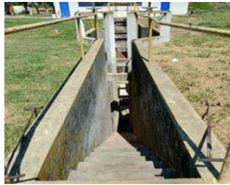
Figura 8: Canal de ingreso a la planta.
