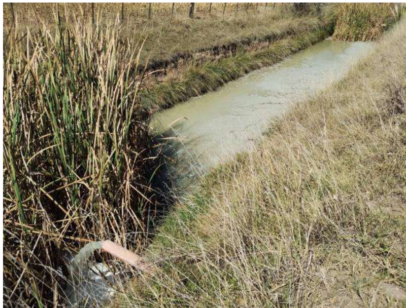
Figura 21. Descarga de efluentes de industria láctea sobre tributario del Canal A (aguas abajo del futuro vuelco).
