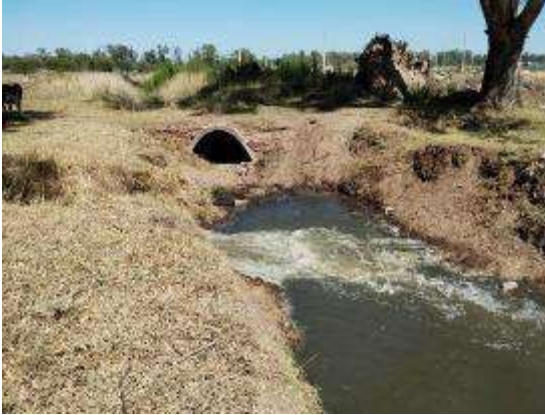
Figura 14 Actual punto de vuelco del efluente proveniente de la PTAR en el canal pluvial el canal pluvial proveniente del Parque Las Acollaradas
