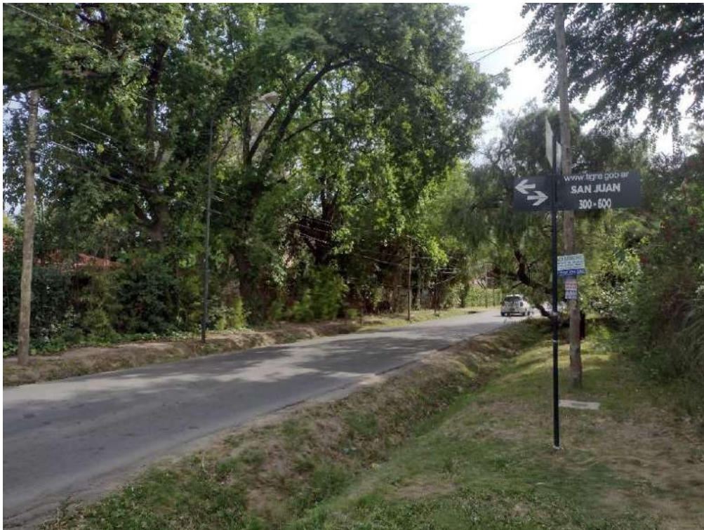
Calle donde se realizara la obra donde se aprecian los zanjones, que en días de lluvia se desbordan y terminan convirtiendo la calle en un gran canal.
