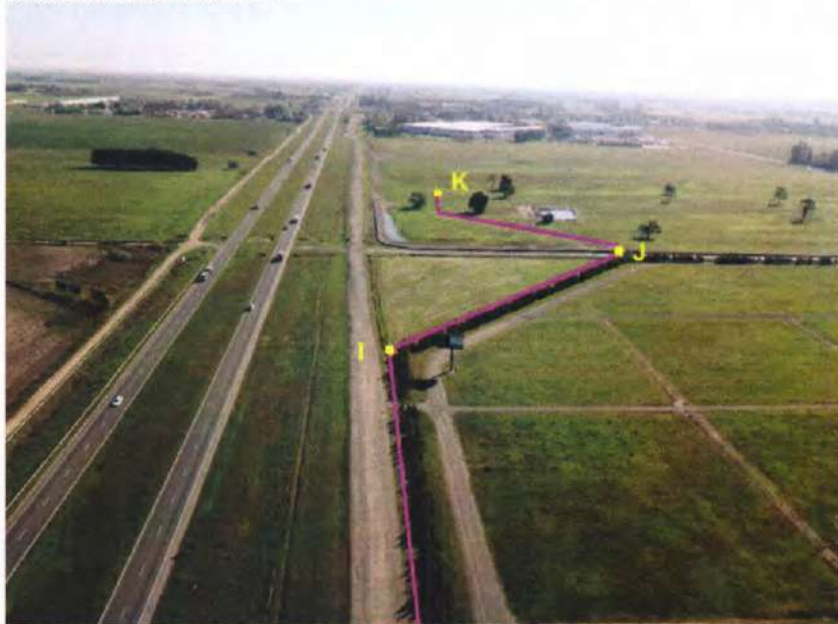
Foto 28: Tomada desde la posición de la foto previa, observando en sentido contrario. Se visualiza la traza Alternativa 1, que, siguiendo el perímetro de los predios aledaños, hace los quiebres que se advierten, para llegar al predio donde se ubicará la ET, y donde, en el futuro, se construirá el Nuevo Complejo Siderúrgico Siderar San Nicolás.
