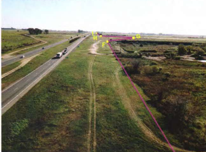
Foto 26: Tomada desde el dron, desde la posición de la foto anterior, pero en observando en sentido contrario, se visualiza la posición de la traza de la LAT, que sigue siempre por el préstamo de la RN 9, cerca del alambrado, hasta llegar al punto de ingreso al predio de la ET SIDERSA.
