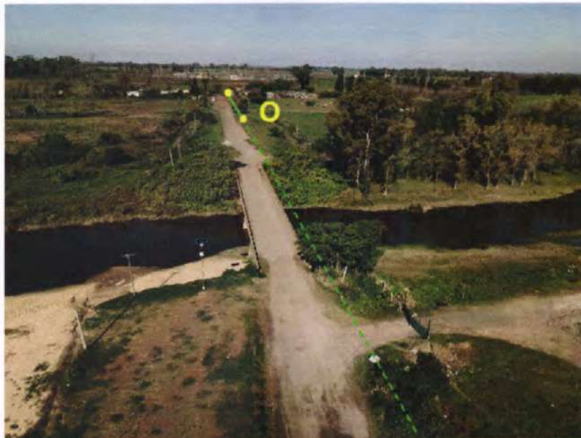
Foto 9: Tomada desde dron, se visualiza – marcada en línea verde - la posición de la traza de la nueva LAT 132 kV Subterránea, de vinculación entre la ET RAMALLO y la Nueva ET SIDERSA; el tramo punteado, marca la distancia entre los puntos O y P, de 250 metros de longitud, donde la LAT se desarrolla entre las cámaras de ataque, desde las que se inicia, y finaliza, el cruce de la terna bajo el lecho del río.
