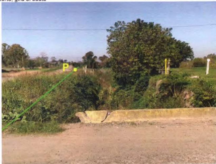
Foto 14: La traza de la LAT subterránea que viene alineada con la calle Tierra del Fuego (y a la zanja de pluviales que se visualiza), llega a la calle Malvinas Argentinas que se observa al pie de la foto, cruzando esta, alineada con la alcantarilla observada. Sobre la derecha la marcación de un gasoducto y el esquinero del predio del Club ATV San Nicolás Extremo, que se visualizan parcialmente en la foto de dron previa.
