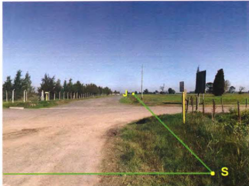
Foto 19: luego de cruzar la calle Estanislao del Campo, desde el Punto S, la LAT se dispone paralela y por margen derecha, buscando el Punto J, distante 500 metros. La traza se desarrolla sobre un predio despejado y nivelado, observándose la presencia de cañería enterrada, de acuerdo a los carteles de aviso que se advierten en la imagen.
