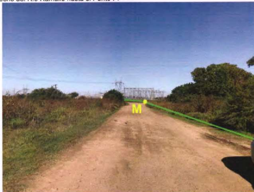
Foto 6: Previo a llegar al Punto M, la traza cruza una calle de tierra que corre desde este punto hasta la Ruta 9, de norte a sur, en forma paralela al límite oeste de la ET RAMALLO. Llegada el punto M, la traza de la LAT gira – con la calle Tierra del Fuego, unos 30°, disponiéndose en un tramo de unos 100 metros, sobre una banquina nivelada.
