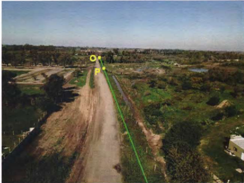
Foto 13: Tomada desde dron, se visualiza la calle Tierra del Fuego y la traza de la LAT sobre el oeste de la calle. La traza, que corre por el préstamo de la calle, se encuentra despejada y alineada con una zanja de desagüe de efluentes pluviales. Abajo, a la derecha de la foto, se encuentran las instalaciones edilicias ubicadas en el predio de la esquina de Tierra del Fuego y Malvinas Argentinas, donde la traza que viene de sur a norte, gira el oeste
