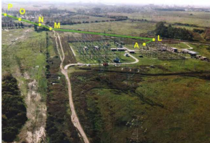
Foto 5: Tomada desde dron, se observa la ET RAMALLO, visualizada desde el sur de la misma. La traza subterránea de la nueva LAT 132 kV de Vinculación se inicia en el Punto A, en la playa de 132 kV de la ET, donde se ejecutará la ampliación de un campo de salida. Se visualiza – señalado con línea verde - el tramo de 1000 metros aproximadamente, hasta el área del Punto O, donde la nueva LAT inicia la pasa bajo el lecho del Río Ramallo hasta el Punto P.
