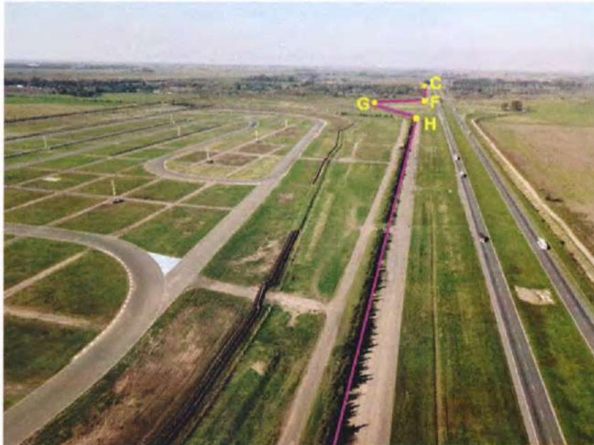
Foto 27: Tomada desde dron, a la altura de Autódromo de San Nicolás. Se observa claramente que la traza Alternativa 1 viene desarrollándose por la colectora de la autovía Ruta Nacional N° 9.
