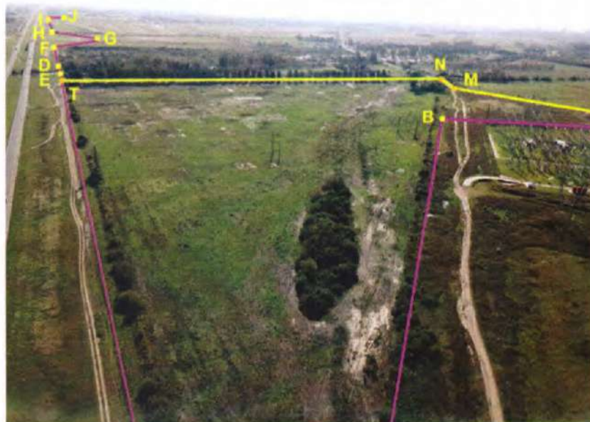
Foto 24: tomada desde el dron, desde la posición del Punto C de la traza Alternativa 1 (Magenta), observando hacia el noroeste (hacia el Autódromo y la localización del predio de la nueva ET SIDERSA).
