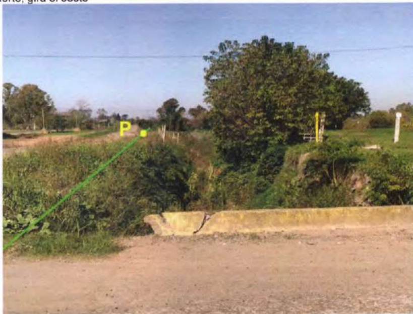
Foto 14: La traza de la LAT subterránea que viene alineada con la calle Tierra del Fuego (y a la zanja de pluviales que se visualiza), llega a la calle Malvinas Argentinas que se observa al pie de la foto, cruzando esta, alineada con la alcantarilla observada. Sobre la derecha la marcación de un gasoducto y el esquinero del predio del Club ATV San Nicolas Extremo, que se visualizan parcialmente en la foto de dron previa.
