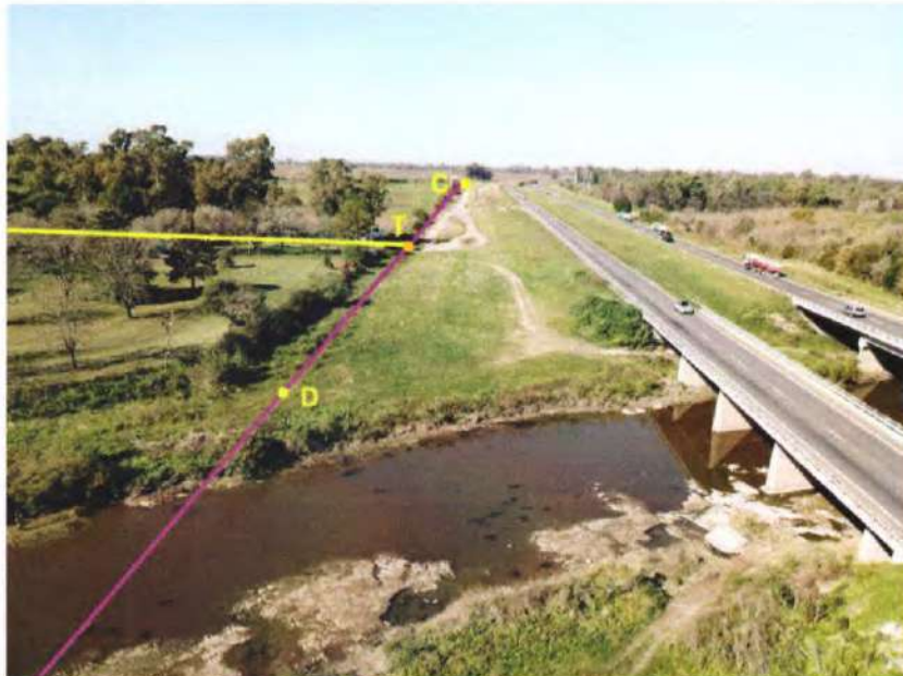
Foto 25: Tomada desde el dron, desde la posición aproximada del Punto E (los puntos D y E señalan el cruce del Río Ramallo). Se observa la RN 9, y la traza Alternativa 1, que viene desde el Punto C al D, pasando por el Punto T, donde se encuentra con la traza Alternativa 3 (en el acceso, por RN 9, al predio del Camping). En este punto la traza Alternativa 3 comparte su desarrollo con la Alternativa 1 hasta la ET SIDERSA.
