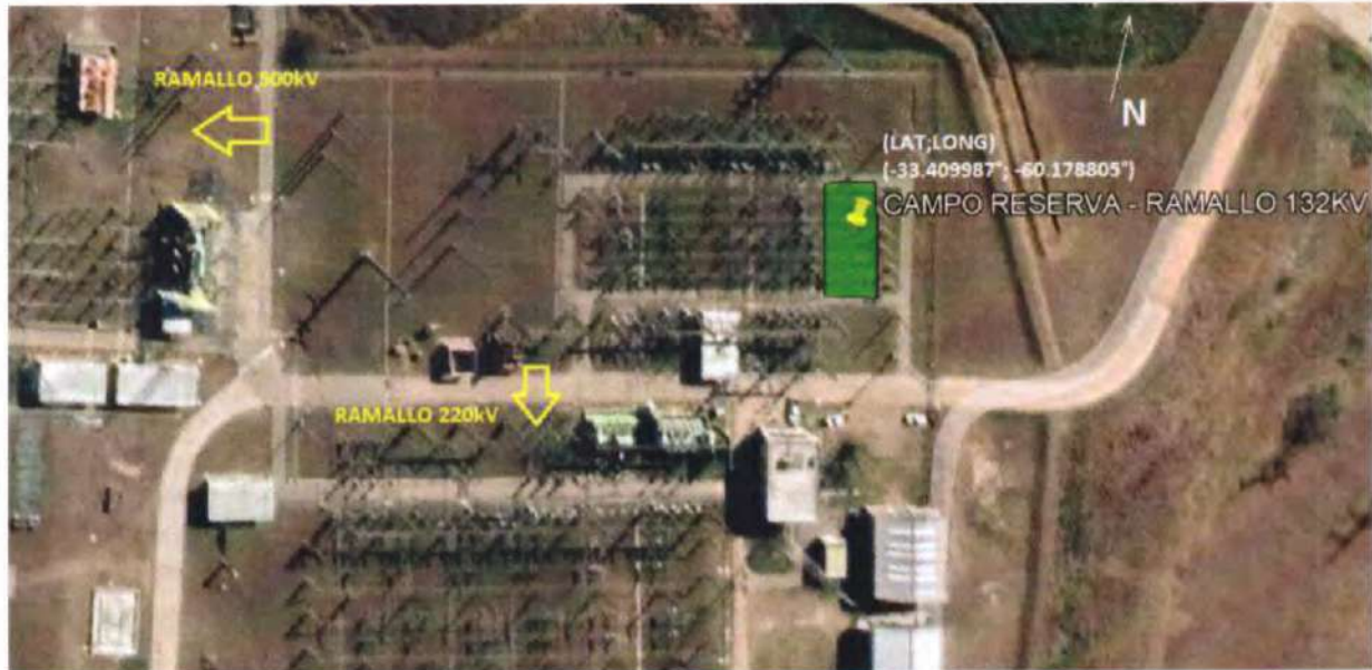
Figura 2.9. Posición del campo de reserva en la ET RAMALLO 132 kV
