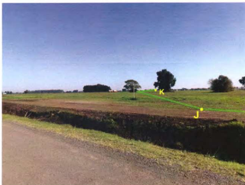
Foto 21: Tomada en el sitio de la foto anterior, a la altura del Punto J, puede observarse, desde la calle Estanislao del Campo, el inicio del tramo donde la traza gira 45° para buscar el punto donde la LAT ingresa al predio de SIDERAR para llegar al predio de la nueva ET, en el Punto K. Al fondo, se advierten vehículos que circulan por la RN 9.
