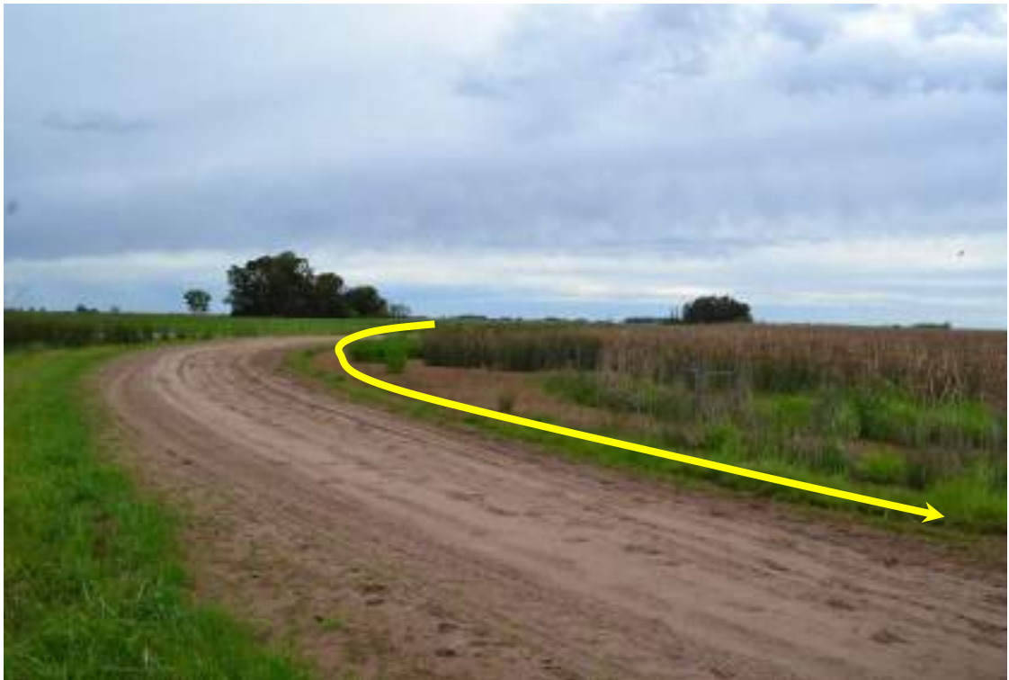
Foto 3.54. Vista al norte, a 30,6 km de la futura EMyRP Henderson. Se observa curva en camino rural. Y sobre ambas márgenes se identifica vegetación característica de suelos anegados.
