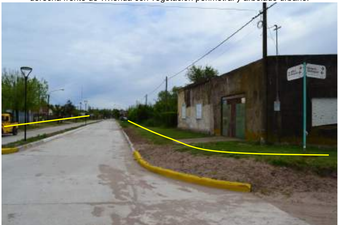
Foto 3.66. Vista desde intersección de Avenida MRLA de Pirovano y calle Modesto Domínguez. Se observa avenida pavimentada, bulevar con alumbrado urbano y cordón cuneta. También se identifica postes de tendido eléctrico y viviendas.
