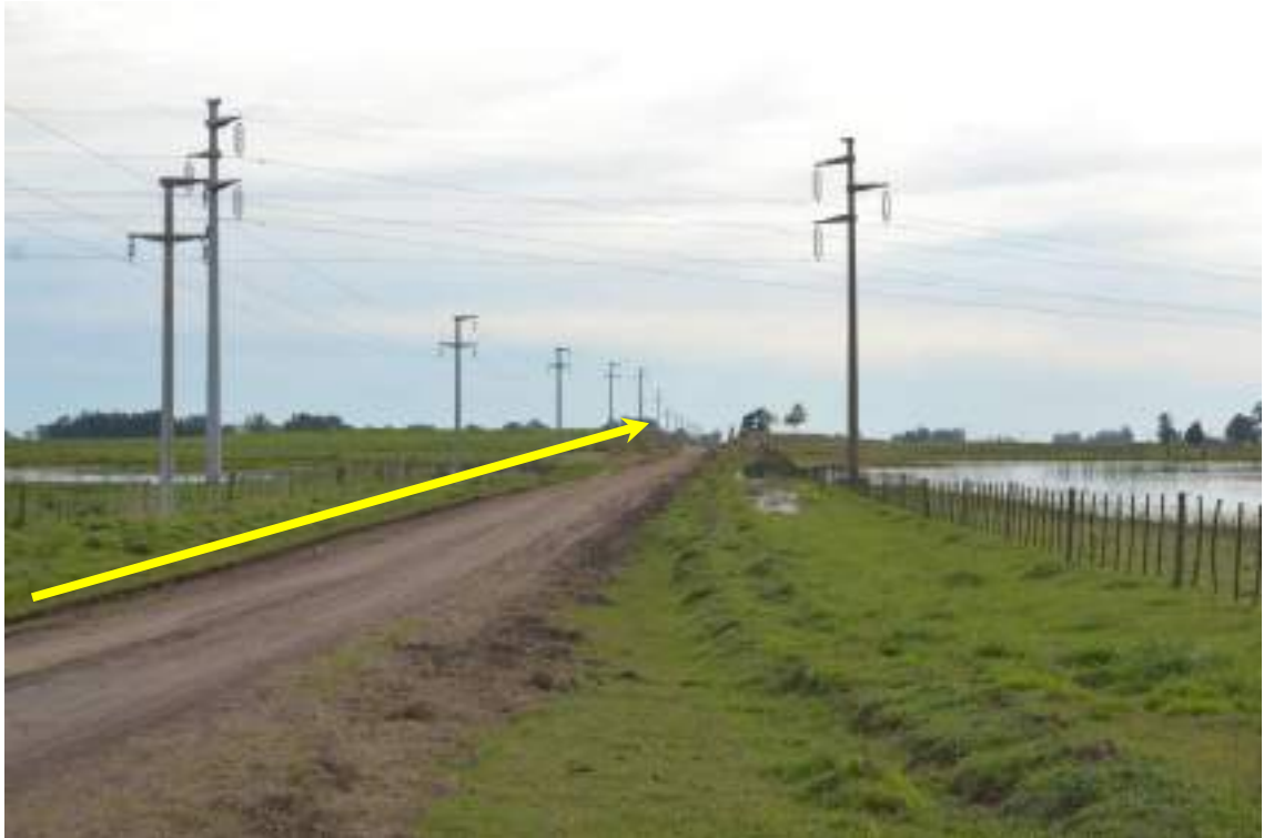
Foto 3.32. Vista al nor-noreste desde el ingreso a camino rural en intersección con ruta provincial N°86, a 6 km de la futura EMyRP Henderson. Se observa postes de tendido eléctrico de alta tensión paralelos al camino, y otro tendido perpendicular que sale de la Estación Transformadora Henderson de 500 kV ubicada a 2,3 km al este. También se observan áreas de terreno bajo con presencia de agua a ambos lados del camino.
