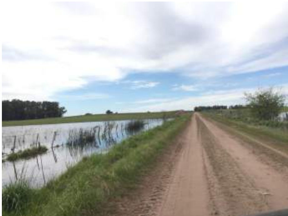
Foto 3. 1. Sector de la traza sin drenaje. Vista hacia el sudeste, a 16 km de la futura EMyRP Henderson. Foto tomada durante el relevamiento ambiental de la traza.
