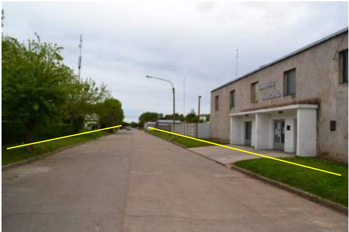
Foto 3.75. Vista del Gimnasio Municipal de la localidad de Pirovano.
