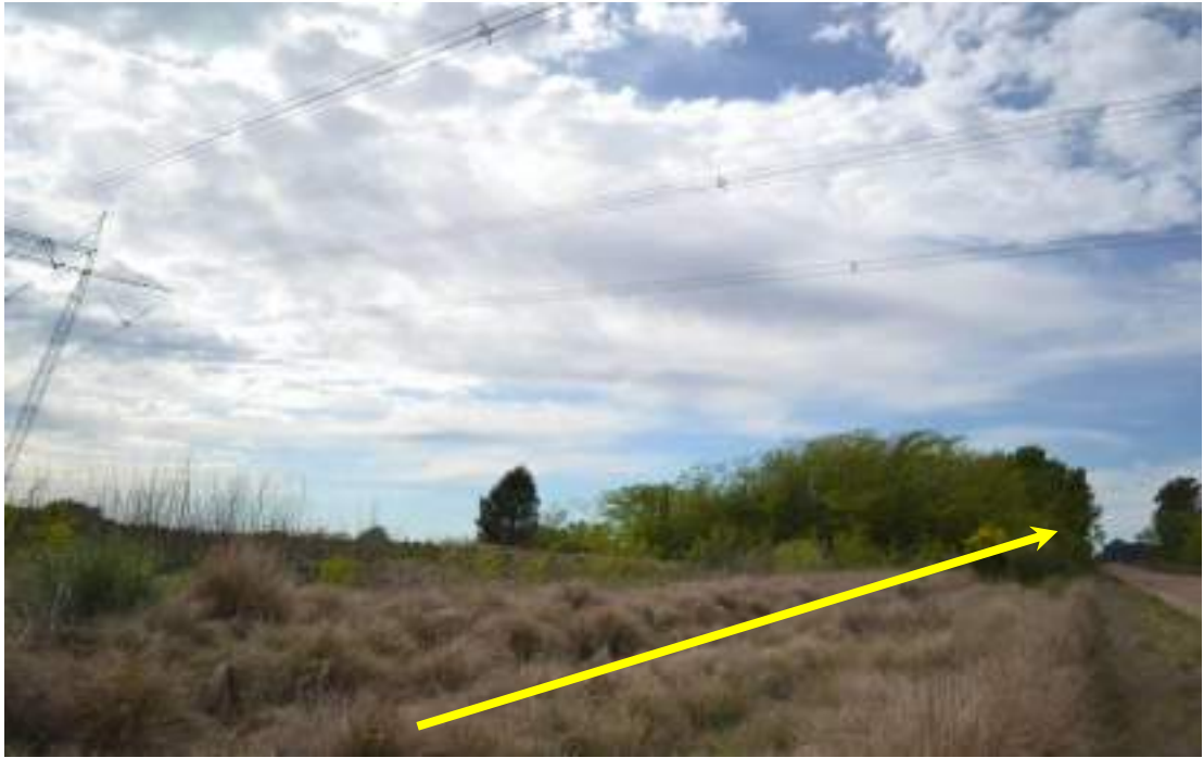
Foto 3.37. Vista al sureste, a 10,6 km de la futura EMyRP Henderson. Se observa cruce de tendido eléctrico de 500 kV en el ingreso a la Estación Transformadora Henderson.
