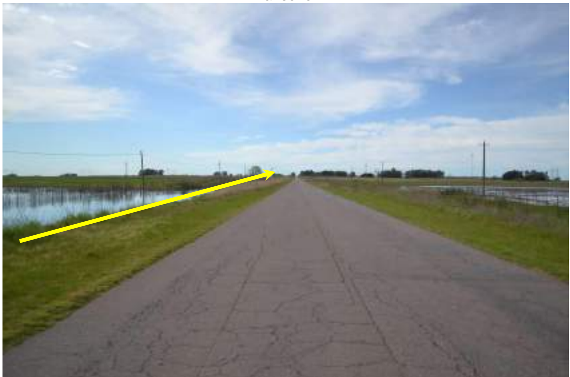
Foto 3.34. Vista al sureste, a 8,84 km de la futura EMyRP Henderson. Se observa áreas de terreno bajo con presencia de agua a ambos lados del camino y postes de tendido eléctrico.
