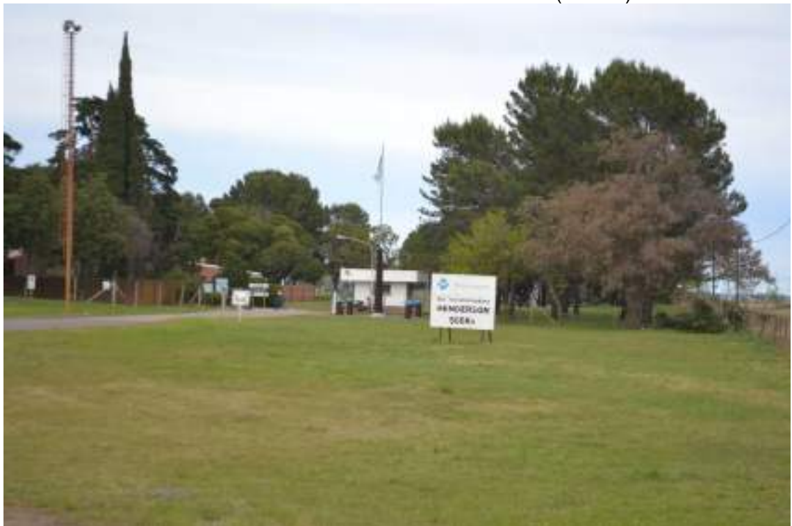
Foto 3.36. Vista del acceso a la Estación Transformadora Henderson de 500 kV, a 10,3 km de la futura EMyRP Henderson.
