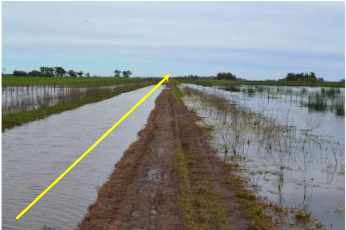
Foto 3.51. Vista al suroeste, a 26,95 km de la futura EMyRP Henderson. Se observa área rural y camino inundado sobre ambas márgenes.
