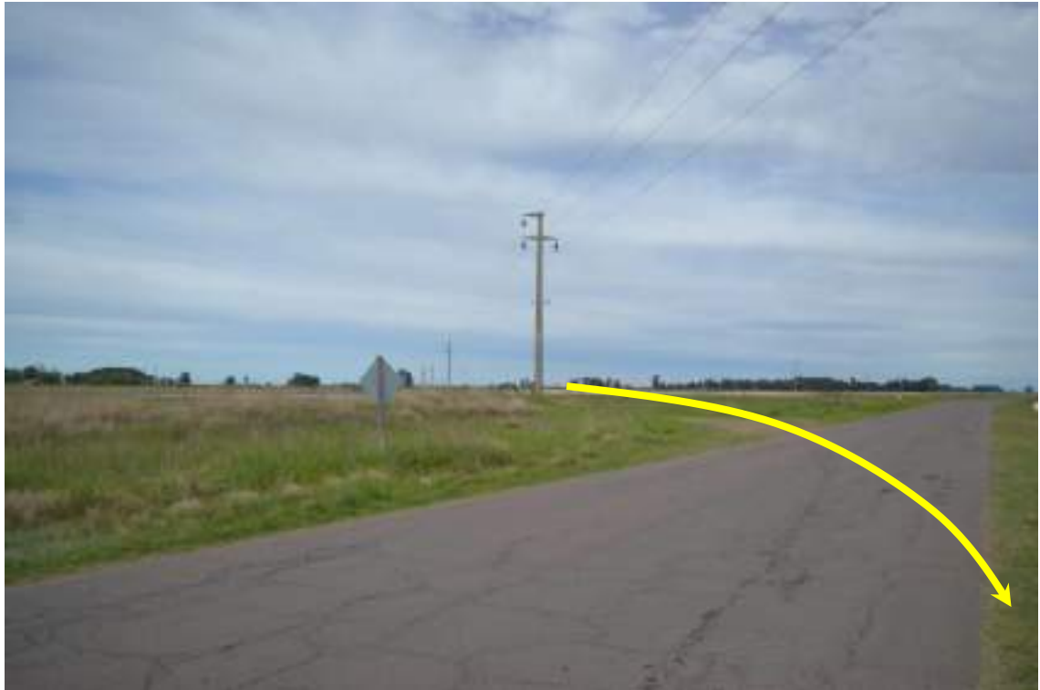
Foto 5. 2. Vista al oeste a 8,3 km de la futura EMyRP Henderson. Se observa camino pavimentado de acceso a la Estación Transformadora de Henderson, operada por Transener.
