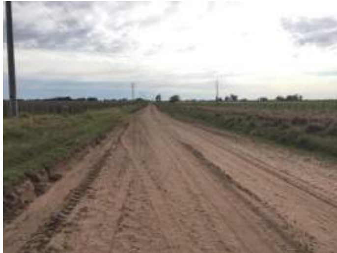
Foto 3. 2. Presencia de suelos arenosos en camino interno durante el trayecto de la traza.
