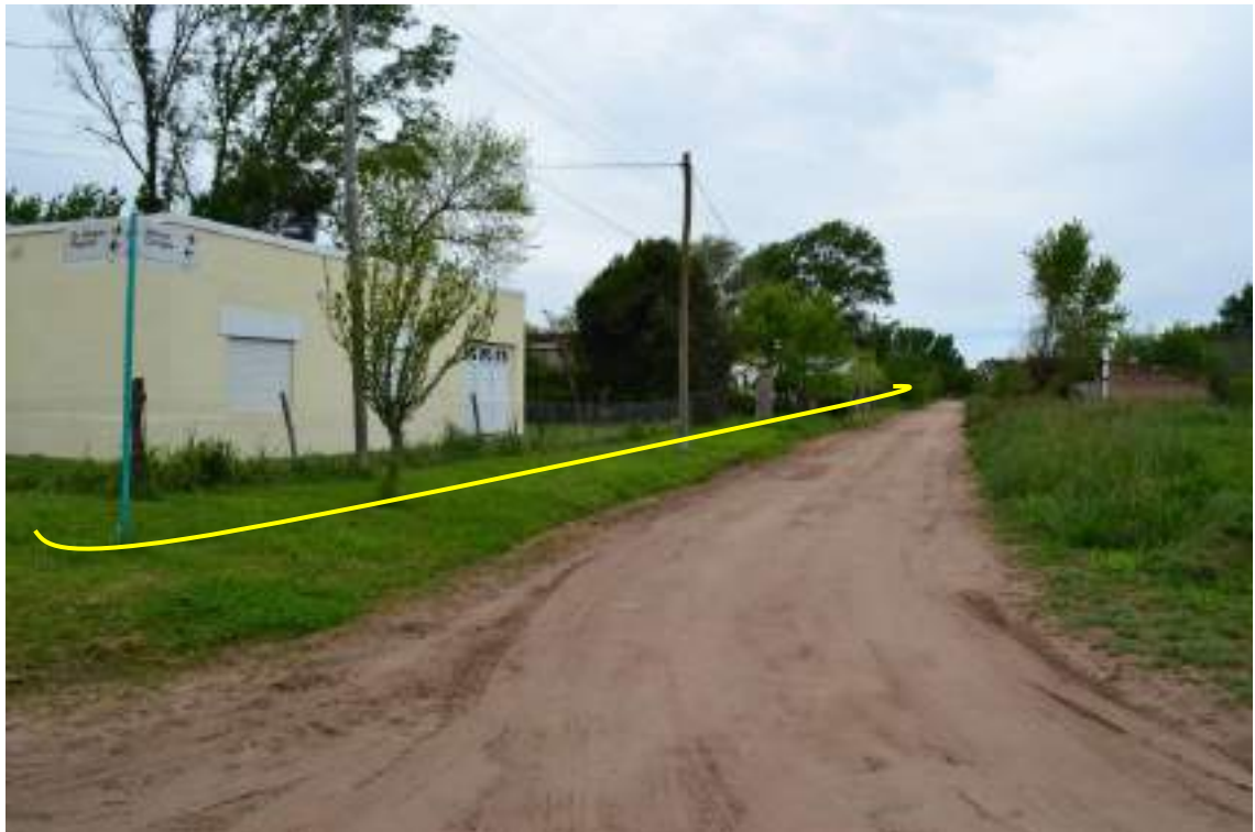
Foto 3.63. Vista al nor-noroeste desde intersección de Avenida Roque Repetto y calle Antonio Córdoba. Se observa calle sin pavimentar, veredas parqueizadas, viviendas y postes de tendido eléctrico.
