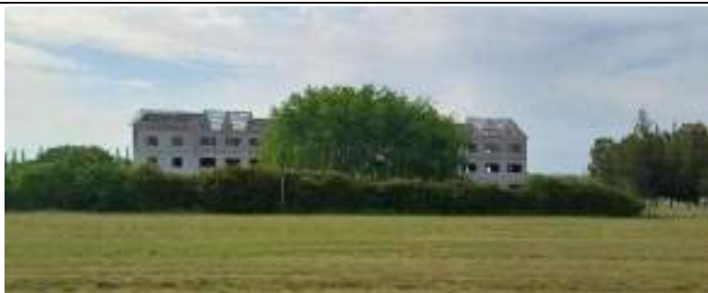
Hotel HJ en construcción
