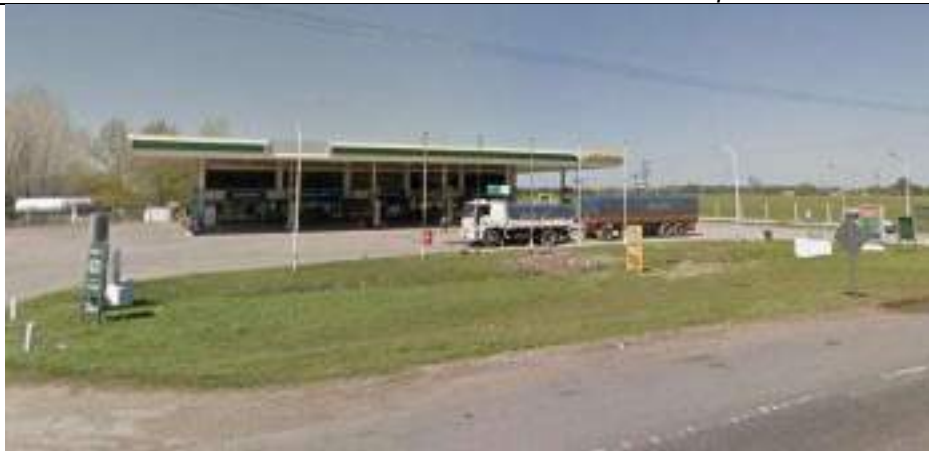
Servicio de Ruta, estación de servicios
