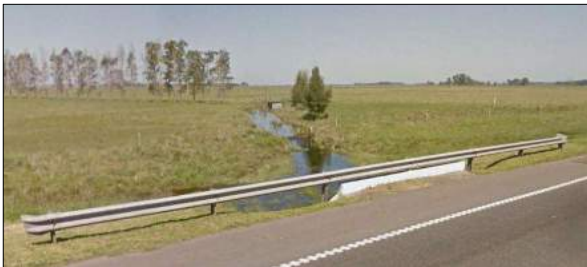
Foto N° 8: Vista hacia LI de la RN 205 del curso de agua
