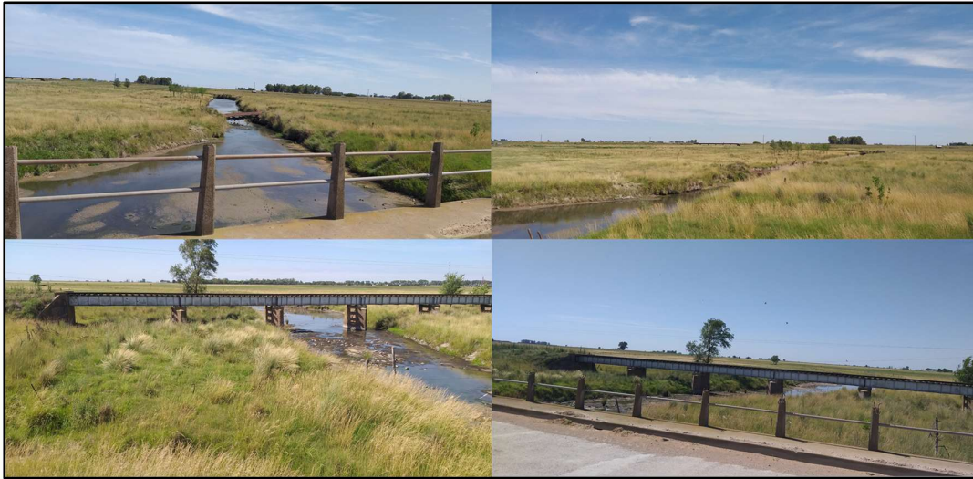
Figura 7: Cruce pluvial con el Río Salado.
