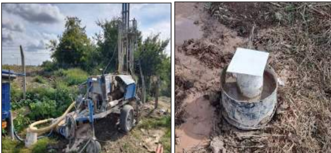
Construcción freático F1
