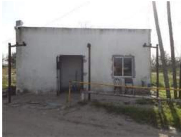
Foto 1. Edificio de acceso al actual BCA.
