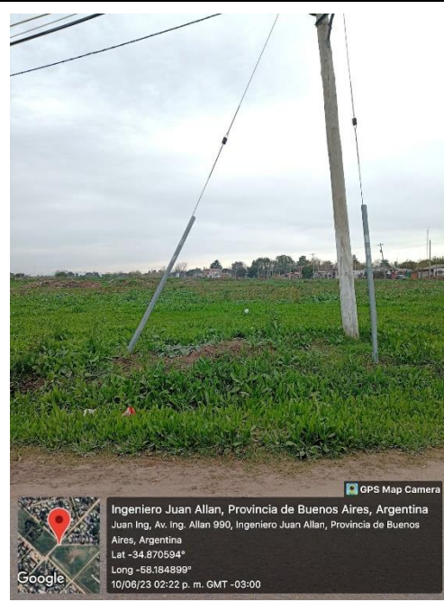
Figura N° 54 Vista del predio sobre la Av. Ing. Allan
