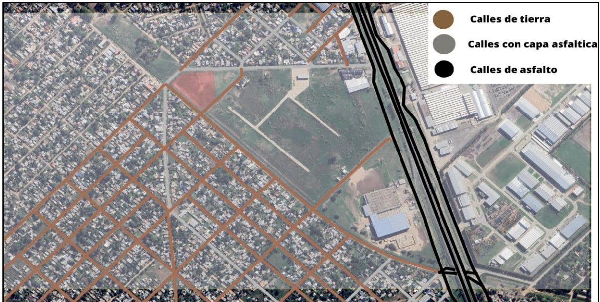
Figura N° 73:: Estado de las calles que rodean la ubicación de la planta de tratamiento. Elaboración propia.
