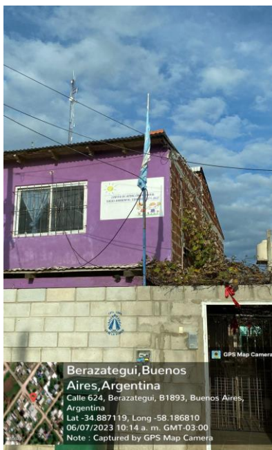
Figura N° 75 'Centro de Atención Primaria Socio-ambiental Comedor San José' sobre la calle 624.
