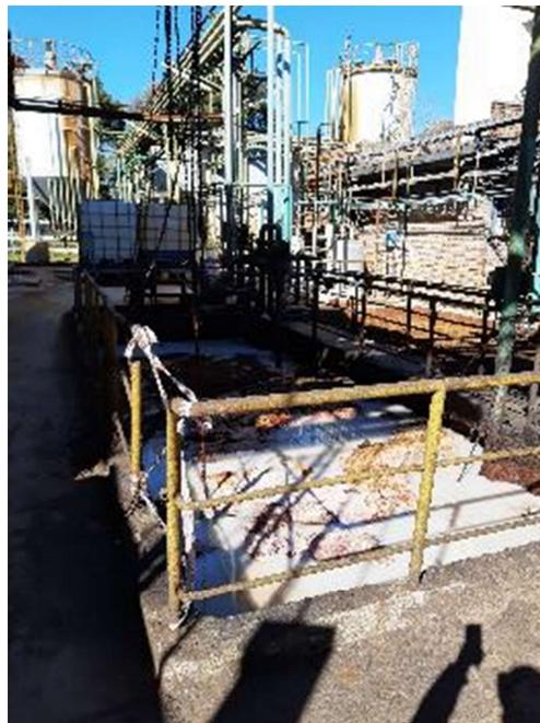
**Figura:** Vista del separador de barros primario.
