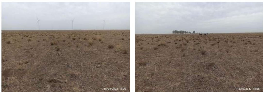
Fotografías 57 y 58. Punto de control Aerogenerador 09. LA09.
