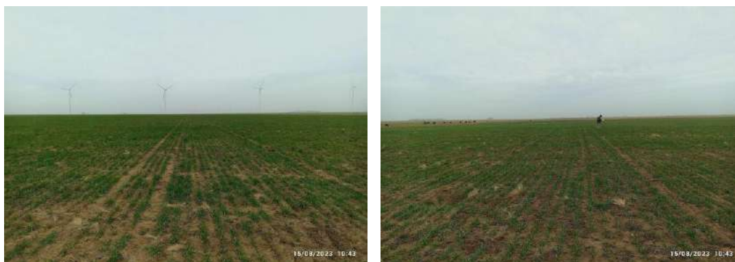
Fotografías 53 y 54. Punto de control Aerogenerador LA08.
