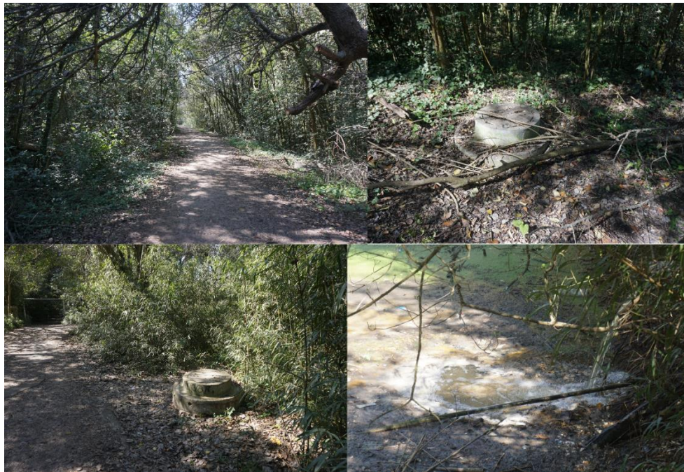
Figura 36 Camino donde se encuentran las cámaras de inspección del conducto que lleva el efluente líquido tratado al Arroyo Pereyra.
