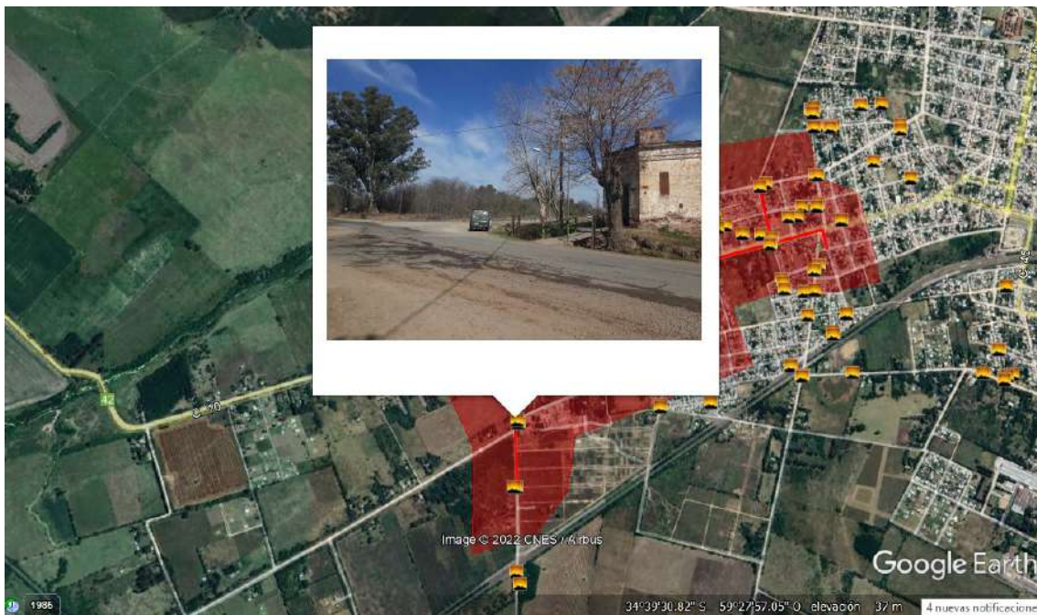
Figura 9 – Esquina de 91 y 4 donde se aprecia una antigua casa en precario estado
