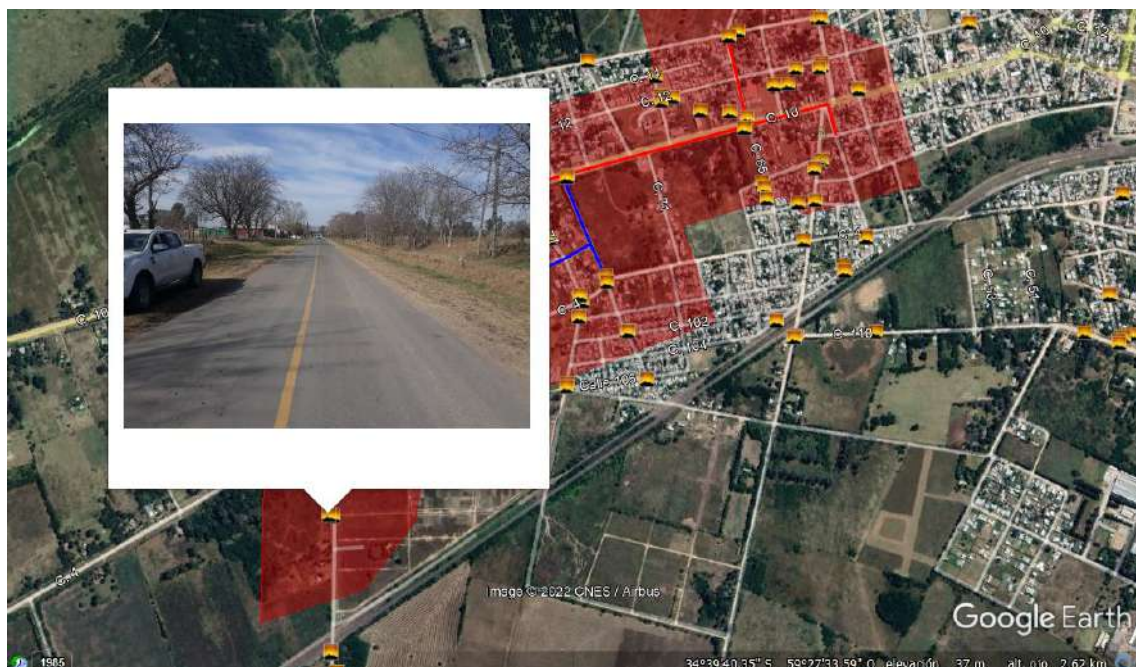
Figura 8 - - Vista general de calle 91 pavimentada de asfalto sin frentistas
