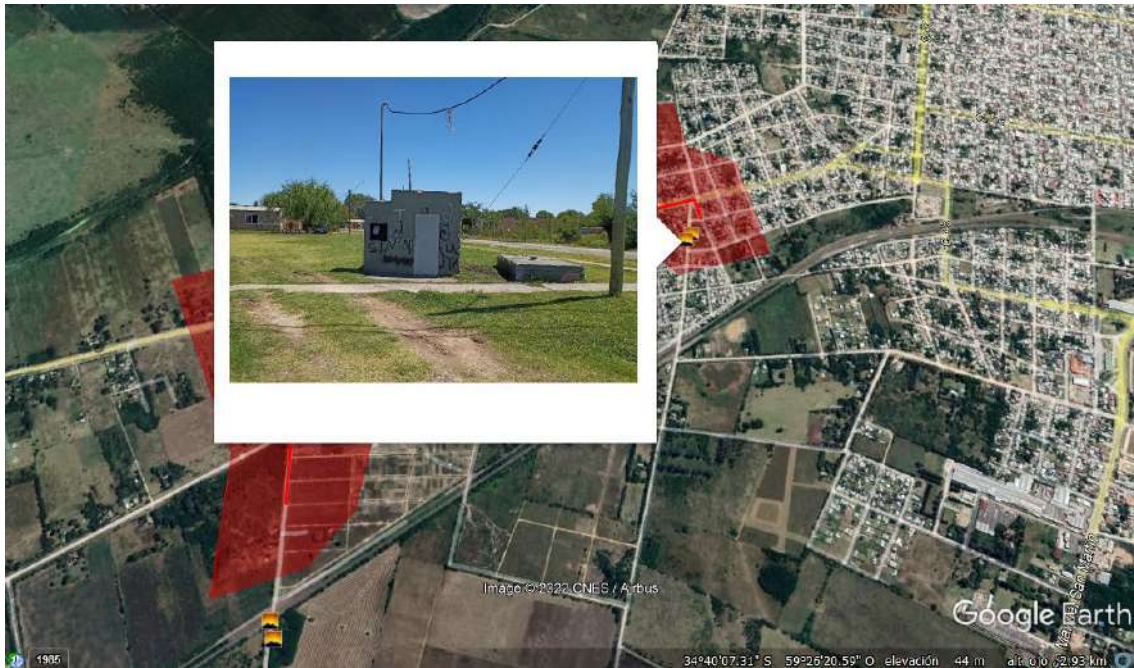
Figura 17 - Pozo de calle 6 y 61bis
