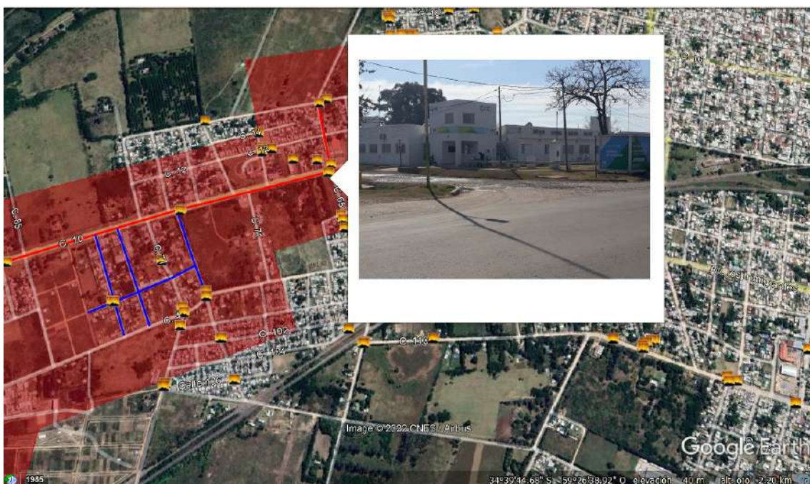
Figura 14 - Inicio de red principal calle 10 y 65, edificio CIC
