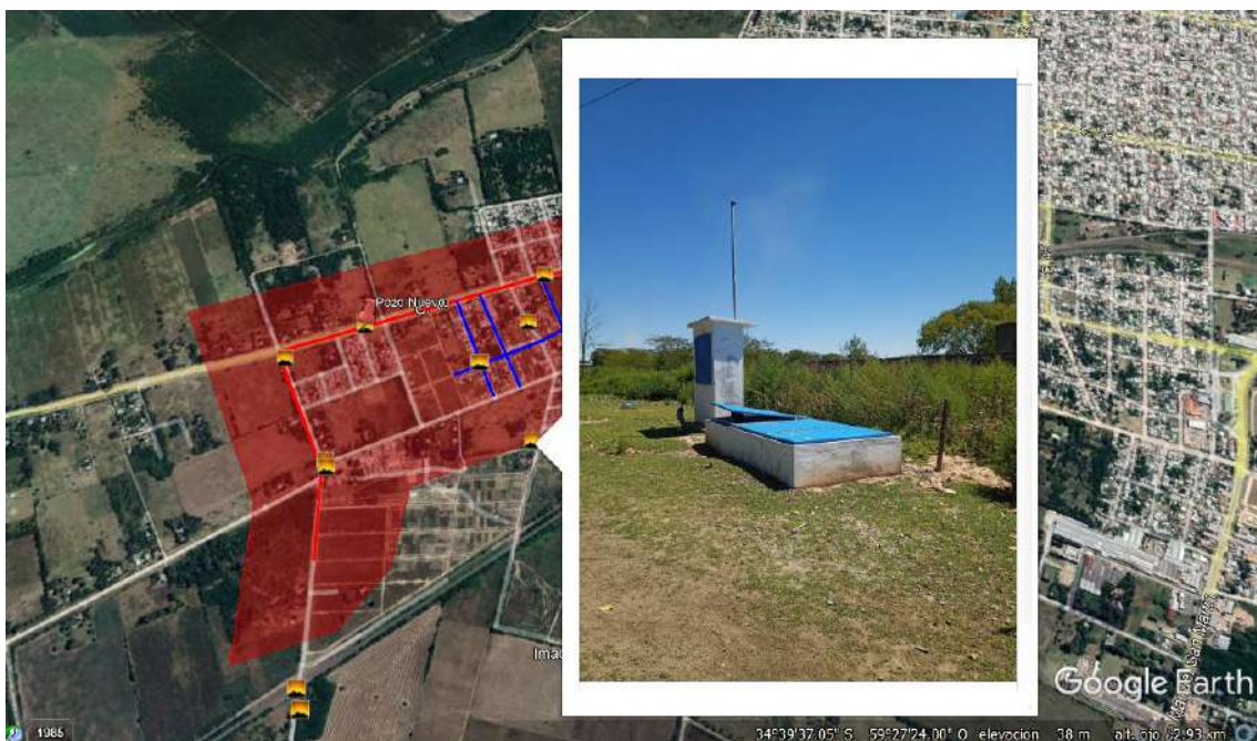
Figura 16 - Pozo de calle 77 y 110
