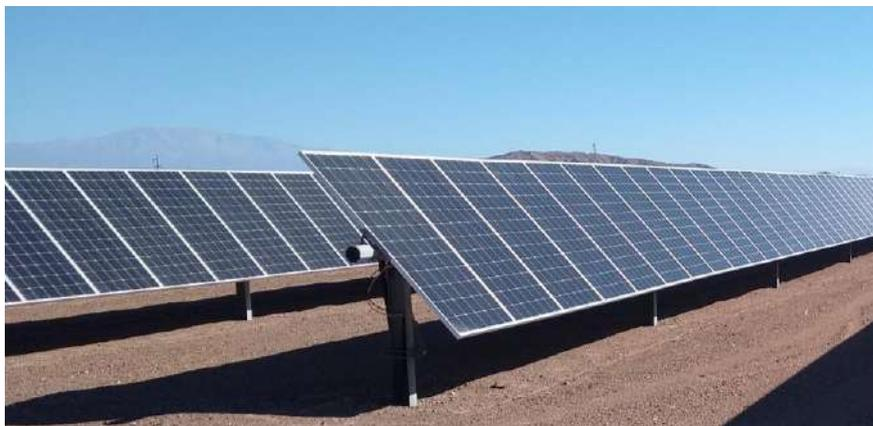
*Figura 2.3 Ejemplo de seguidores de un eje (PS de 360 Energy).*
