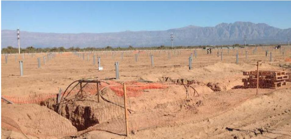
*Figura 2.10 Ejemplo de canalizaciones para tendido subterráneo en un parque solar en construcción de 360 Energy. Fuente: CCyA Ingeniería.*
