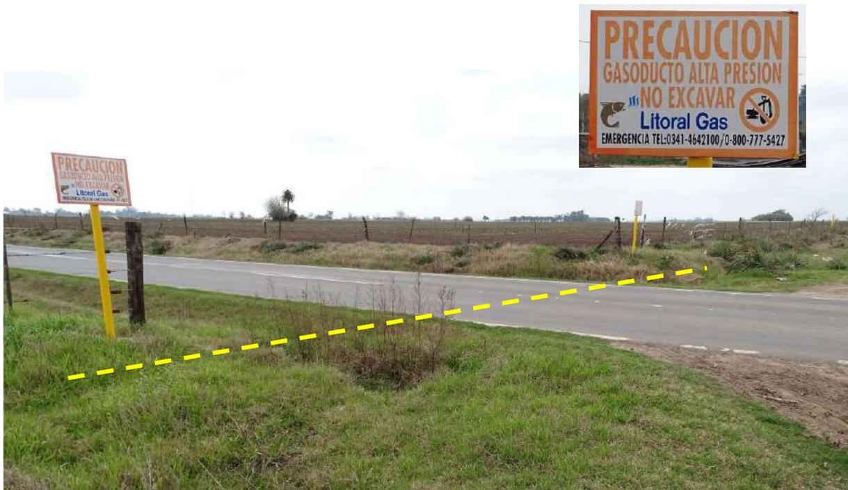
Figura 3.56 Cruce subterráneo de la calle 133 por el gasoducto de alta presión (esquemático en línea amarilla de trazos) que va paralelo a la calle 66.
