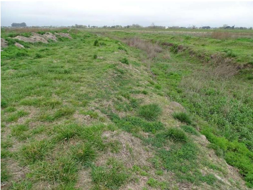
*Figura 3.66 Canal principal de drenaje. Arriba a la izquierda, montículos de la ultima limpieza.*
