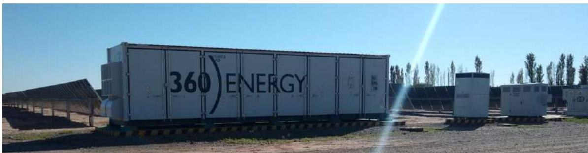
Figura 2.5 Ejemplo de BESS (PS de 360 Energy).
