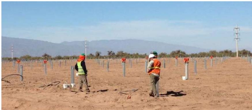
*Figura 2.11 Ejemplo de montaje de soportes de estructuras en un parque solar en construcción de 360 Energy. Fuente: CCyA Ingeniería.*
