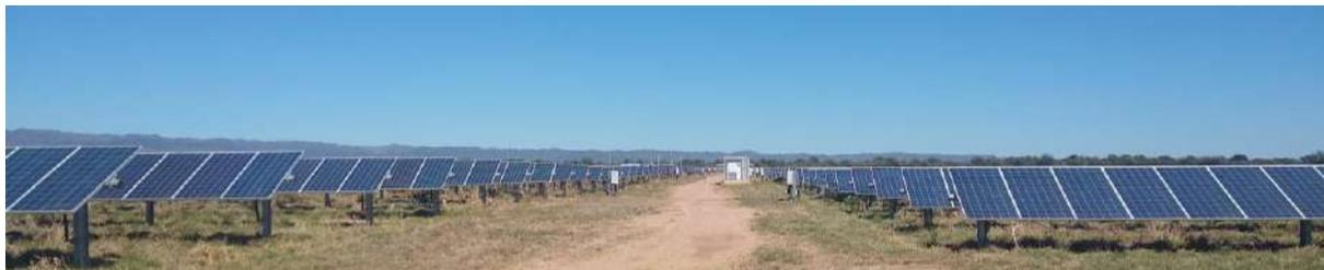
*Figura 2.15 Ejemplo de PS en zona no desértica, con cobertura vegetal del suelo y minimización de resuspensión de polvo (y de limpieza de paneles). Fuente: CCyA Ingeniería.*
