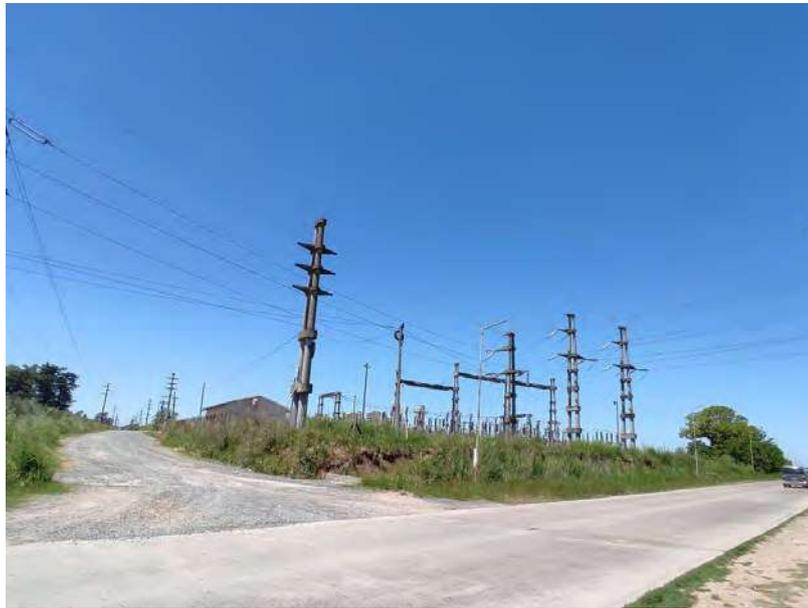
Foto 2-33. Vista SE del Camino Provincial 038-01/ acceso a Zárate intersección camino Sta. Ana. Se observa la estructura terminal RA3N, reemplazará el terminal de la LAT 132 kV LAS PALMAS-Protisa (tercera contando de la derecha). Las tres alternativas de trazado cruzan perpendicularmente vías de FFCC (izquierda) y camino provincial.
