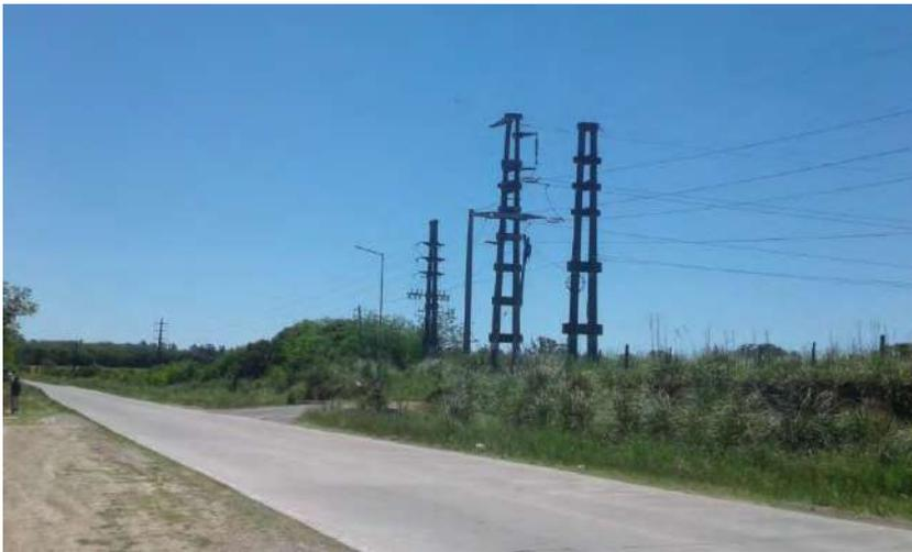
Foto 2-38. Vista NO del Camino Provincial 038-01/ acceso a Zárate intersección camino Sta. Ana. Se observa LMT 33 kV DT paralela al camino y estructura de transición aéreo-subterránea (izquierda). Estructura retención angular de la LAT 132 kV LAS PALMAS-Protisa a reubicar (Centro). Estructura en desuso a remover (derecha).
