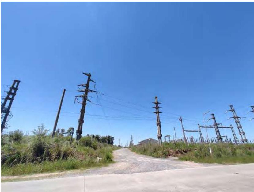
Foto 2-39. Vista NE del camino Sta. Ana. Se observa estructura retención angular de la LAT 132 kV LAS PALMAS-Protisa a reubicar (esquina izquierda). Estructura en desuso a remover (esquina derecha). A la derecha tres estructuras terminales de acometida y pórticos de la ET LAS PALMAS 132 kV. La estructura terminal RB3N, reemplazará el terminal de la LAT 132 kV LAS PALMAS-Protisa (tercera contando de la derecha).
