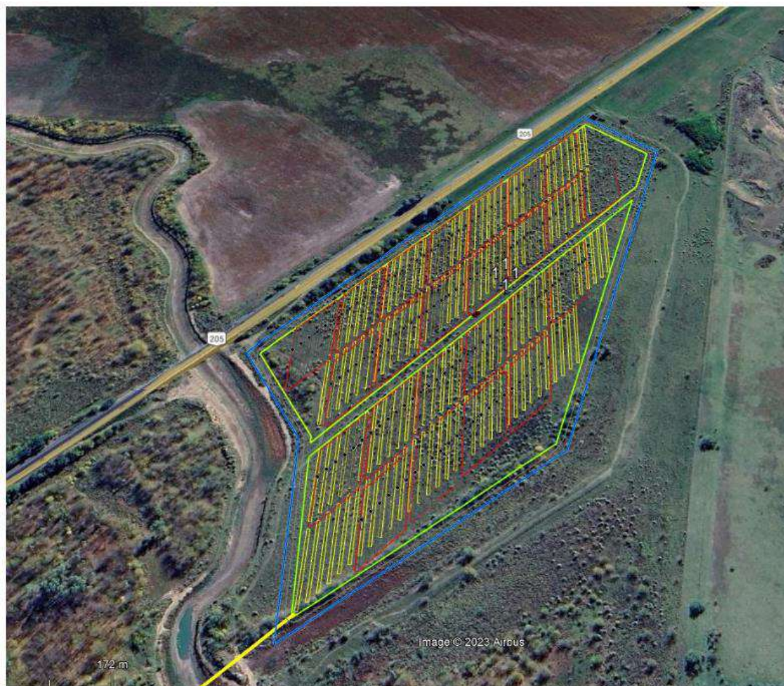
Figura 2. Distribución de paneles solares
