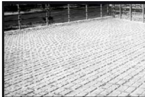
Foto 1 (Izq.): Contenedor de PEAD color rojo para contención de Residuos Patogénicos. Foto 2 (Der.): Piso de homigón armado para los corrales de engorde.
