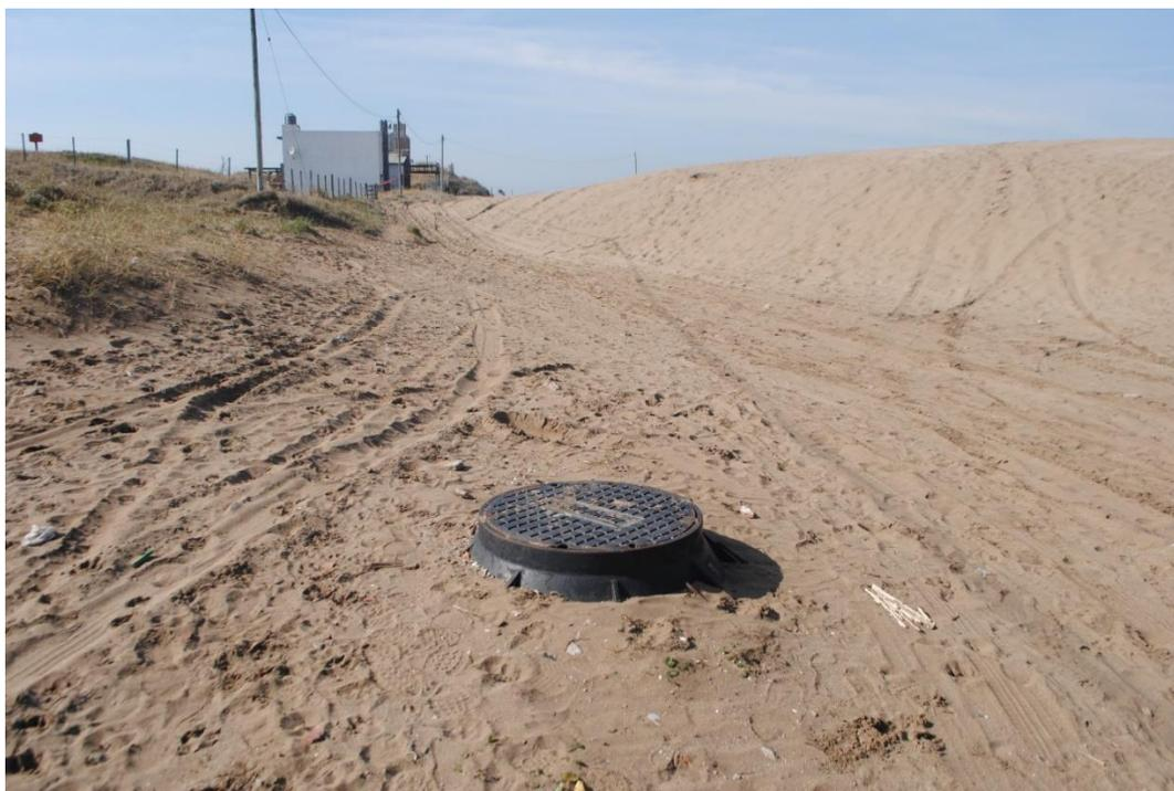
*Figura 4346: Exposición de estructuras por deflación eólica*
