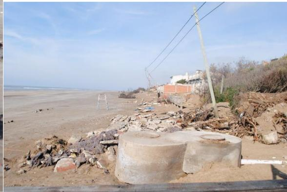
*Figura 4245: Pozos de registro cloacal expuestos luego de una sudestada ocurrida en invierno de 2021 y vuelco de postes de luz. Se registró un descenso del nivel de playa distal de más de 1 m al norte de Las Toninas.*
