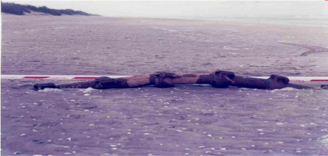
Figura 50 55:Detalle de la aparición superficial de un cable, con posterioridad a una tormenta (año 2001). Calle 58 Costa Chica.
