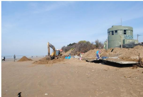
Figura 4144: Socavamiento de la base de la estructura de la planta impulsora cloacal de la calle 38 y costanera en 2021. Evidencia de retroceso costero
