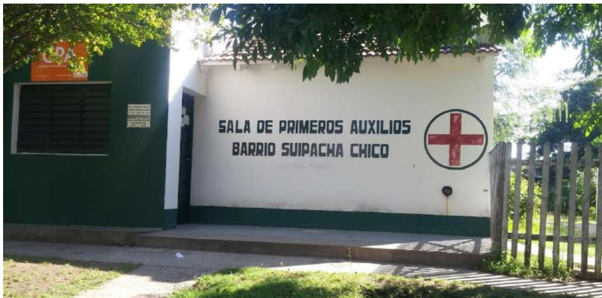
Figura 24. Sala de primeros Auxilios Suipacha Chico Fuente: Google Street View
