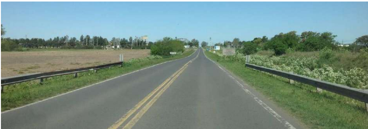
Figura 3.64 Sector del cruce de la RN 8 (vieja) por la LMT de evacuación.
