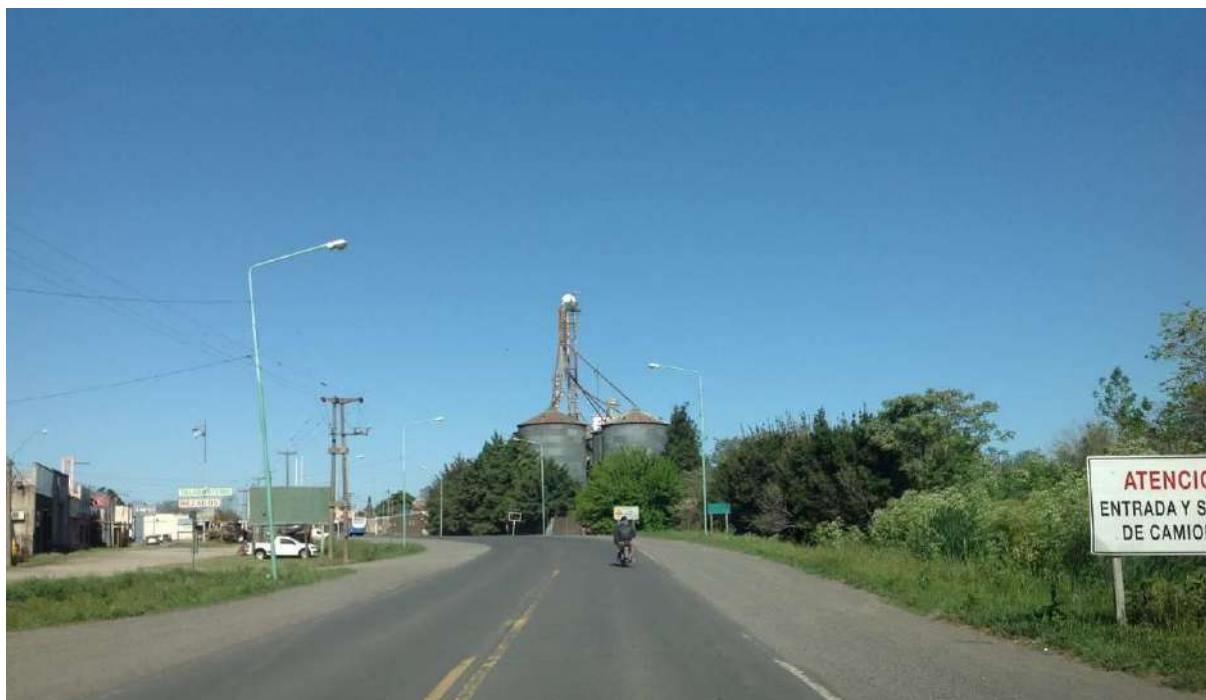
Figura 3.31 Salida de Arrecifes hacia el PSA por RN 8 (vieja). Vista hacia el este.
