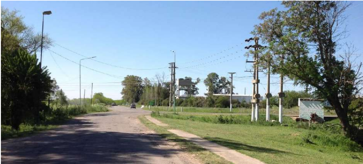
Figura 3.65 Sector del cruce del camino vecinal por la LMT de evacuación en la acometida hacia la ET Todd.
