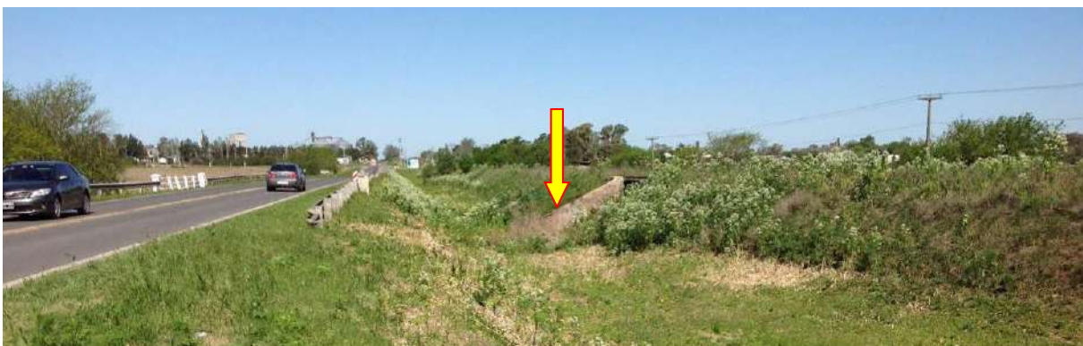
Figura 3.66 Sector del cruce del arroyo del Pueblo por la LMT de evacuación.
