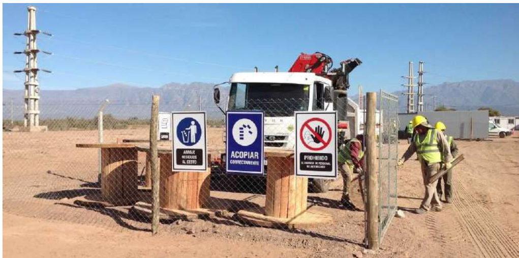
Figura 2.13 Ejemplo de sector de acopio transitorio de reciclables en un parque solar en construcción de 360 Energy. Fuente: CCyA Ingeniería.
