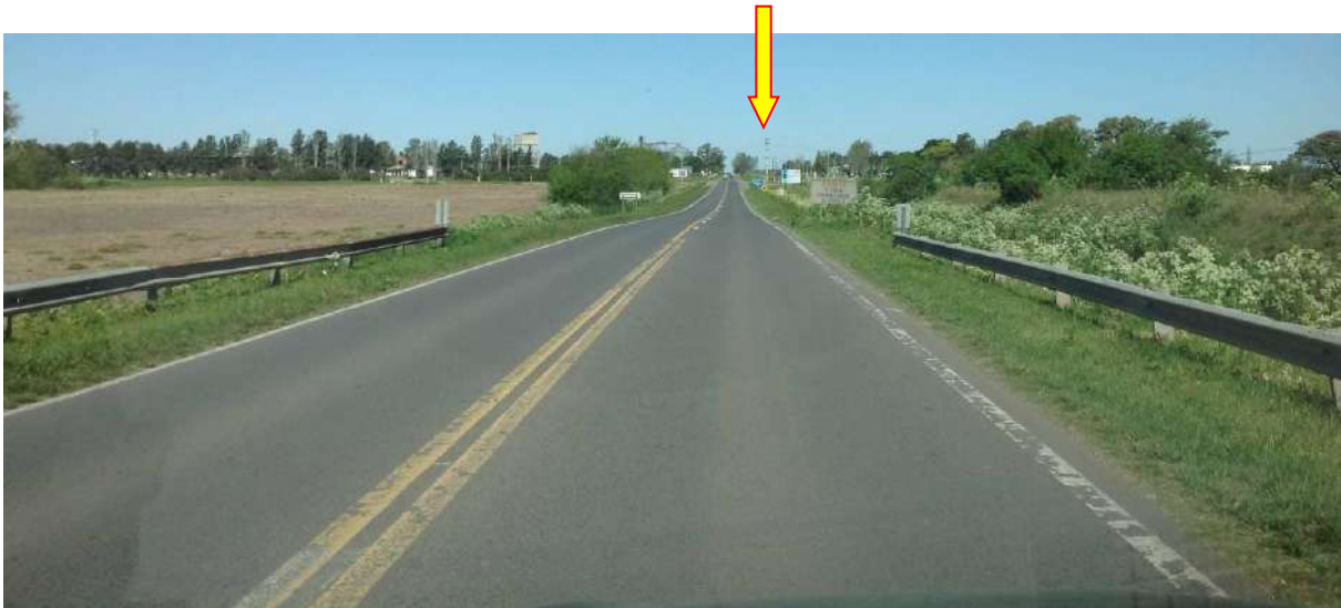
Figura 3.55 En el tramo de la RN 8 (vieja) entre el SIPA y Todd no hay líneas aéreas. Las primeras líneas se encuentran cruzando la ruta desde la ET Todd hacia el SIPA (flecha).
