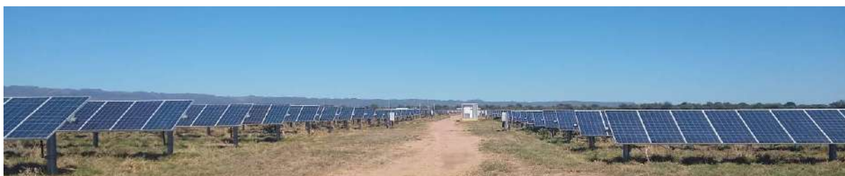
Figura 2.18 Ejemplo de PS en zona no desértica, con cobertura vegetal del suelo y minimización de resuspension de polvo (y de limpieza de paneles). Fuente: CCyA Ingeniería.
