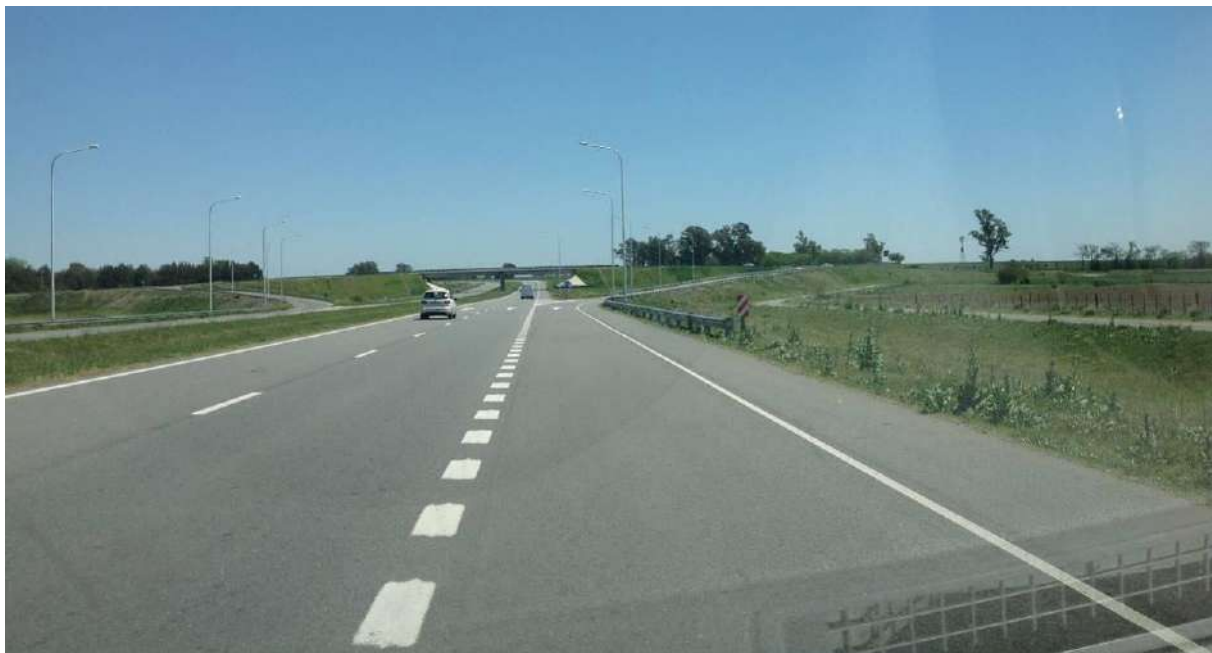
Figura 3.24 Acceso a la zona del proyecto por autopista RN 8 desde el este, en el nudo con el camino vecinal a Todd. El entorno es rural.
