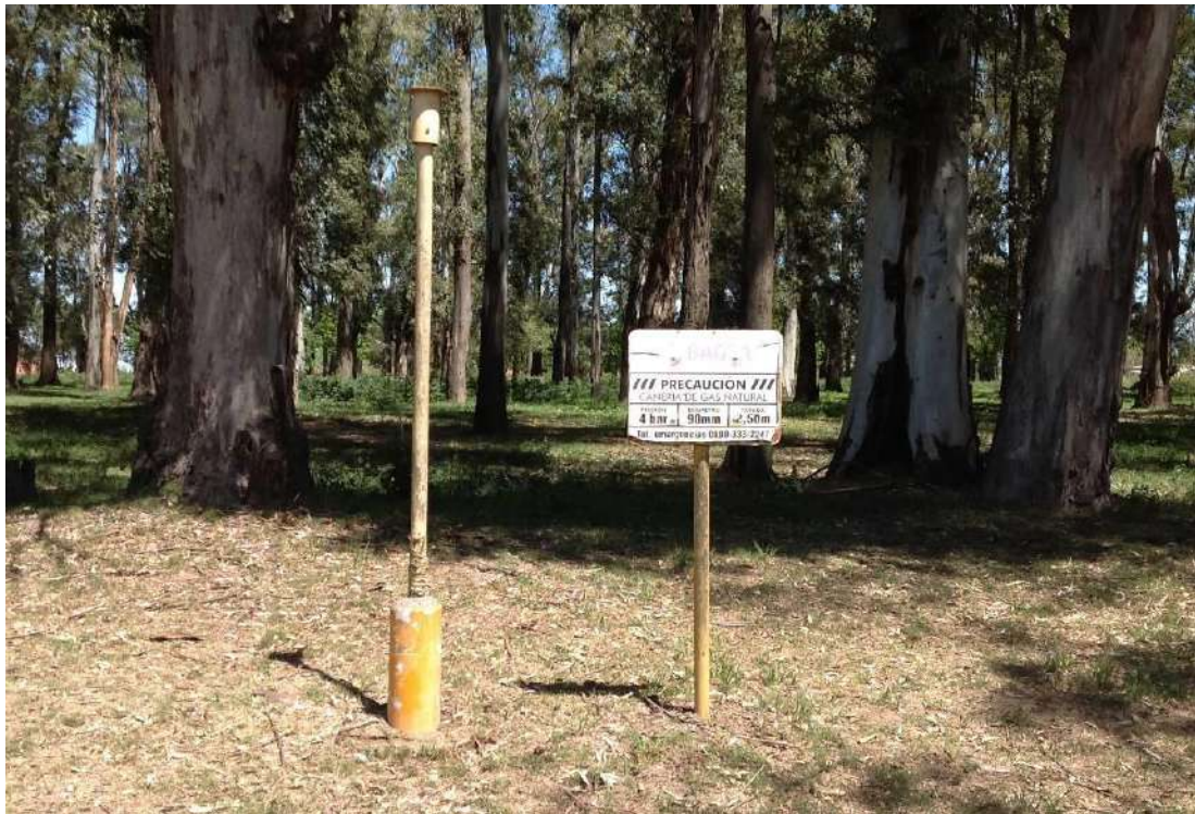
Figura 3.47 Gas natural de red sobre RN 8 en Todd.
