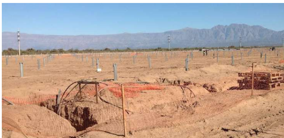
Figura 2.10 Ejemplo de canalizaciones para tendido subterráneo en un parque solar en construcción de 360 Energy. Fuente: CCyA Ingeniería.
