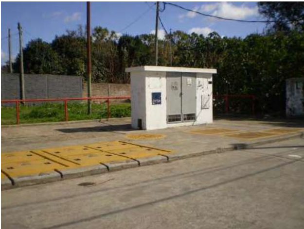
Foto 03: EBC existente. Gral. Frías a metros de Garibaldi
