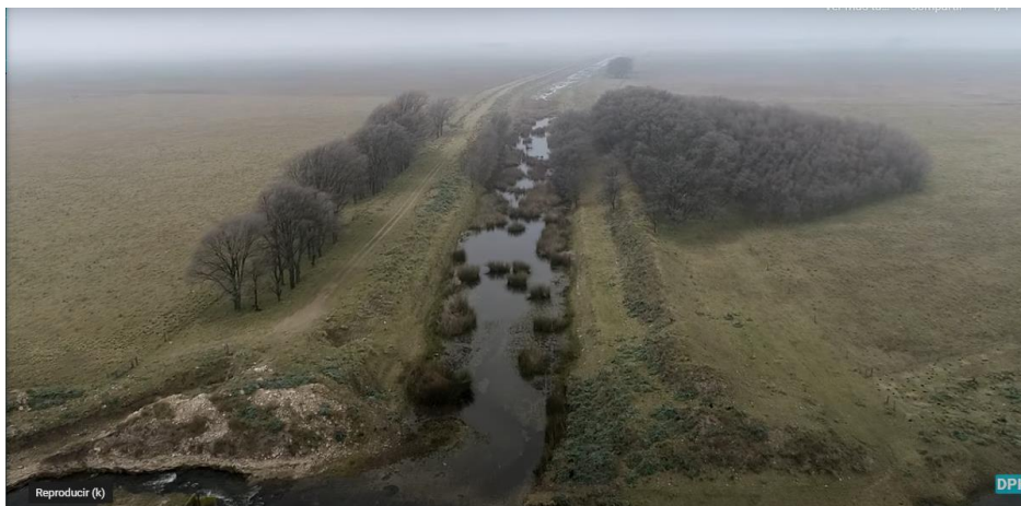
Figura 20. Vista del canal Ameghino y camino de sirga desde el puente sobre A° Huáscar hacia la RP 60. Vegetación de pastizal modificado, parches de vegetación arbórea y uso agropecuario. Fuente: Departamento de Estudios Ambientales-Dirección Técnica- DPH.2023
