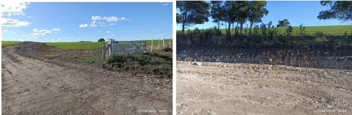
Fotografía 39. Punto de control PCAA17.
