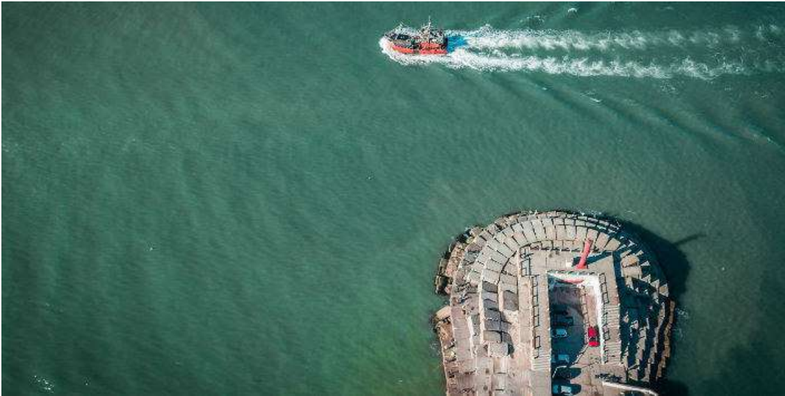
El puerto se ubica en la costa de Mar del Plata y está encerrado por dos importantes escolleras, la Norte y la Sur. Foto: C. Heit
