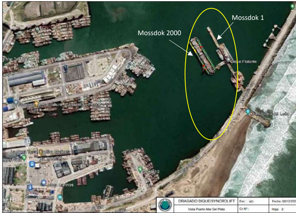
Fig. 1.2: Ubicación de la obra: Sector de operación de diques
