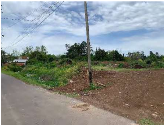
Foto 27: Tucumán 500, terreno con movimiento de suelos.
