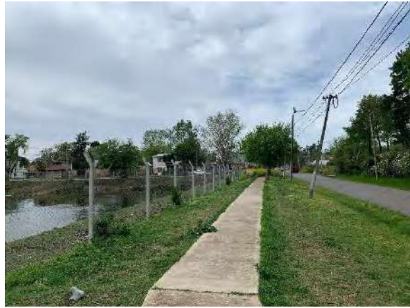
Foto 26: Tucumán 500, terreno cubierto de agua.
