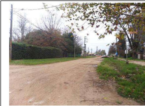
Calzada de tierra en Balaguer y Puerto Rico.
