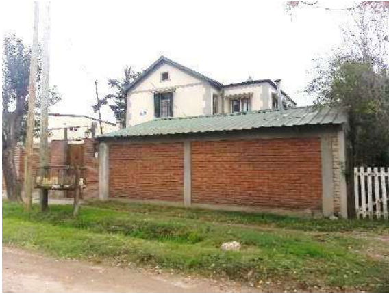
Vivienda sobre calle Ábramo
