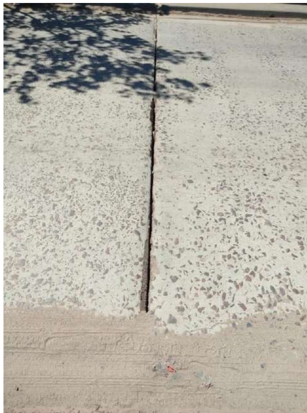
Imagen 11: Juntas inadecuadas
