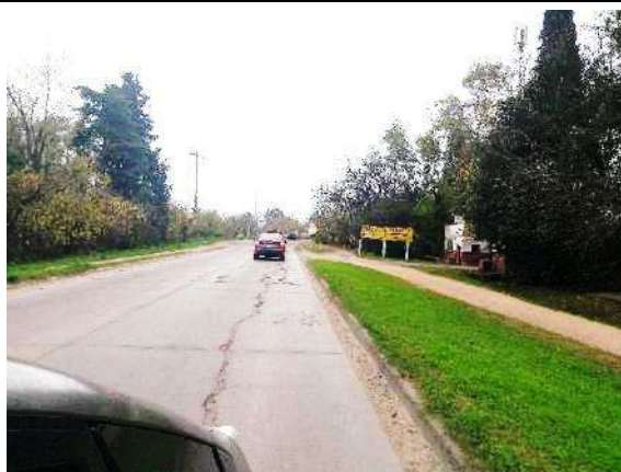
Vista general de la calzada de la calle Tiziano.
