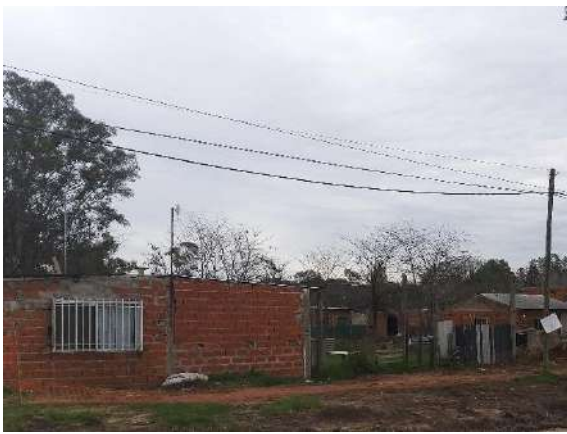
Viviendas en construcción en Av. Balaguer y B. Juárez.
