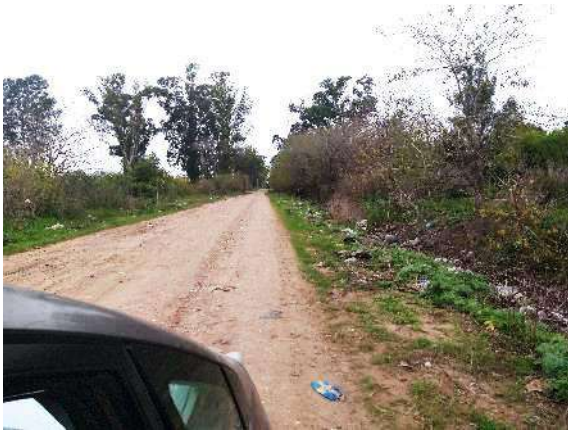
Vista general de la calzada de la calle F. de Viedma. Zona suburbana.
