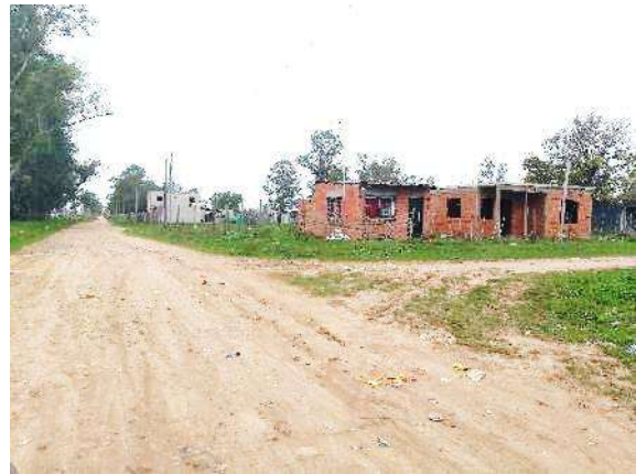
Viviendas en construcción en proximidades calle Viedma.
