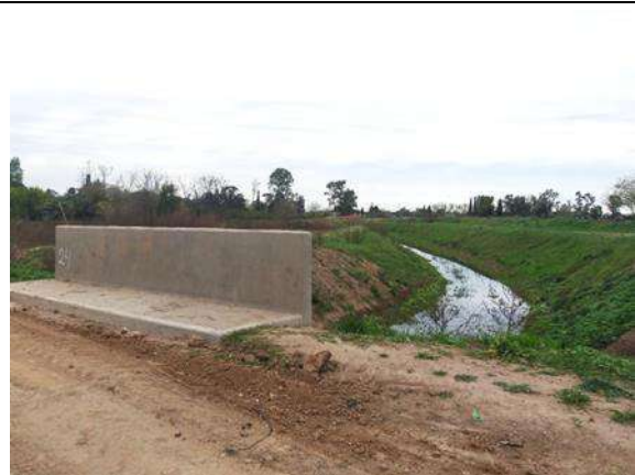
Alcantarilla existente y curso de agua.
