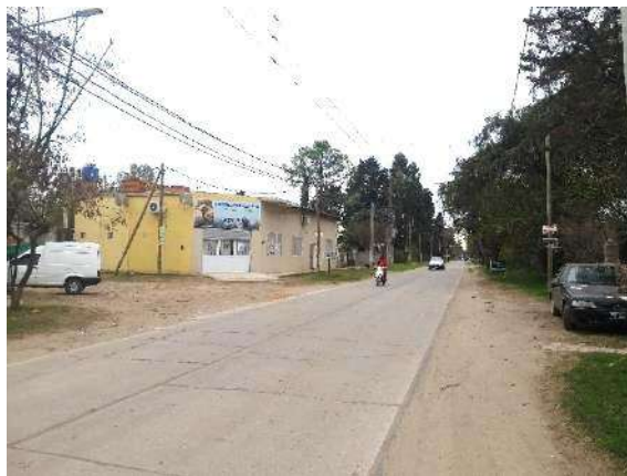
Vista general de la calzada actual de la Av. Rubén Darío.
