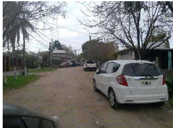
Vista general de la calzada actual de la calle Posadas.
