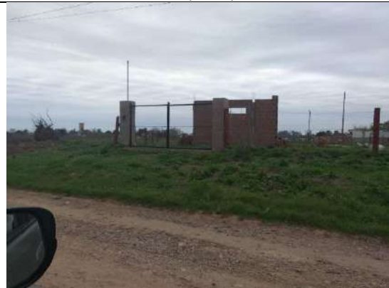
Loteo en terreno sobre calle F. de Viedma.
