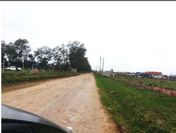
Vista general de la calzada de la calle F. de Viedma. Zona suburbana.
