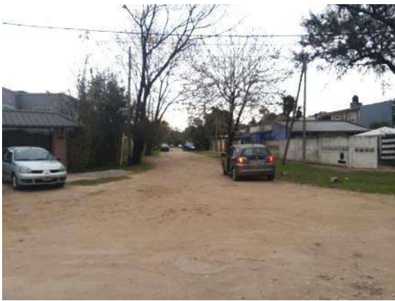
Intersección Av. Piovano y calle Ábramo. Vista del perfil de tierra consolidado.
