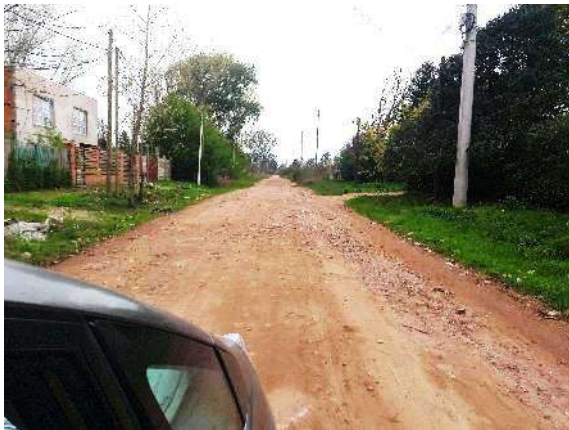
Vista general de la calzada de la calle F. de Viedma.
