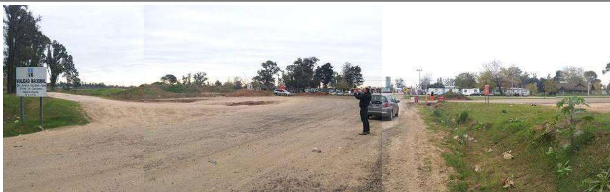
Intersección calle de acceso a Autopista Pte. Perón y Autopista en etapa de finalización.
