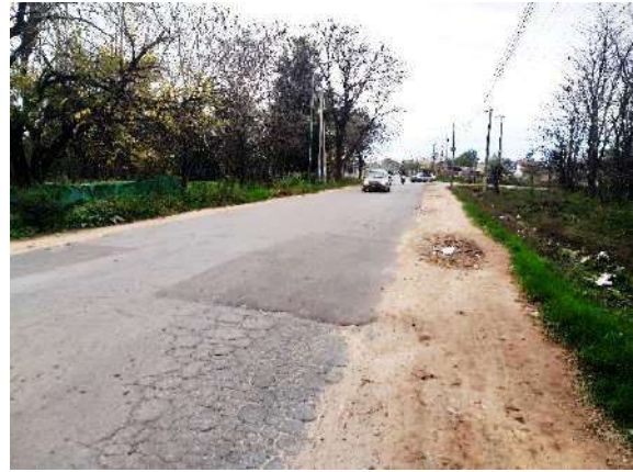
Vista general de la calzada de la calle Zapaleri.
