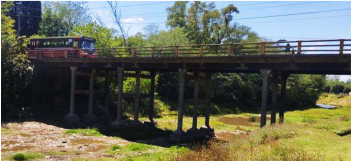
Viste general del puente. Fuente: ConinoJ.
