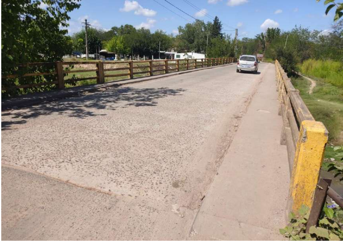
Imagen 2: Vista superior – Calzada y veredas
