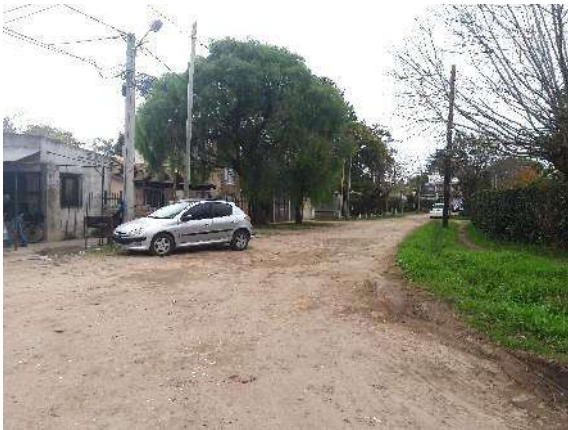
Intersección calles Ábramo y Posadas. Vista del perfil de tierra consolidado.
