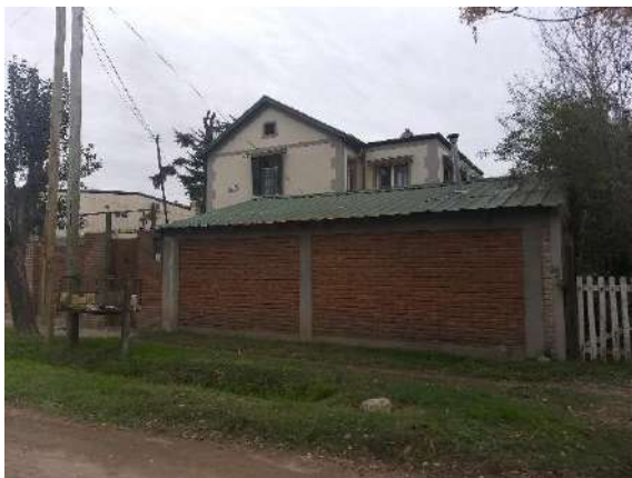
Vivienda 2 plantas sobre calle Ábramo.
