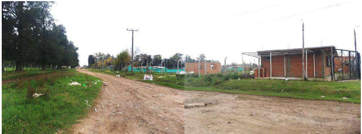
Viviendas en construcción en el AID y estado actual (calzada de tierra de Av. Balaguer altura cruce calle Manuel de Falla.
