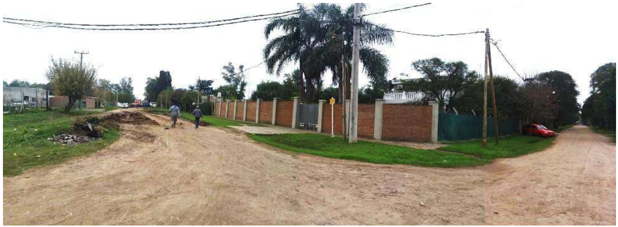
Estado actual Av. Balaguer altura cruce calle Neuquén
