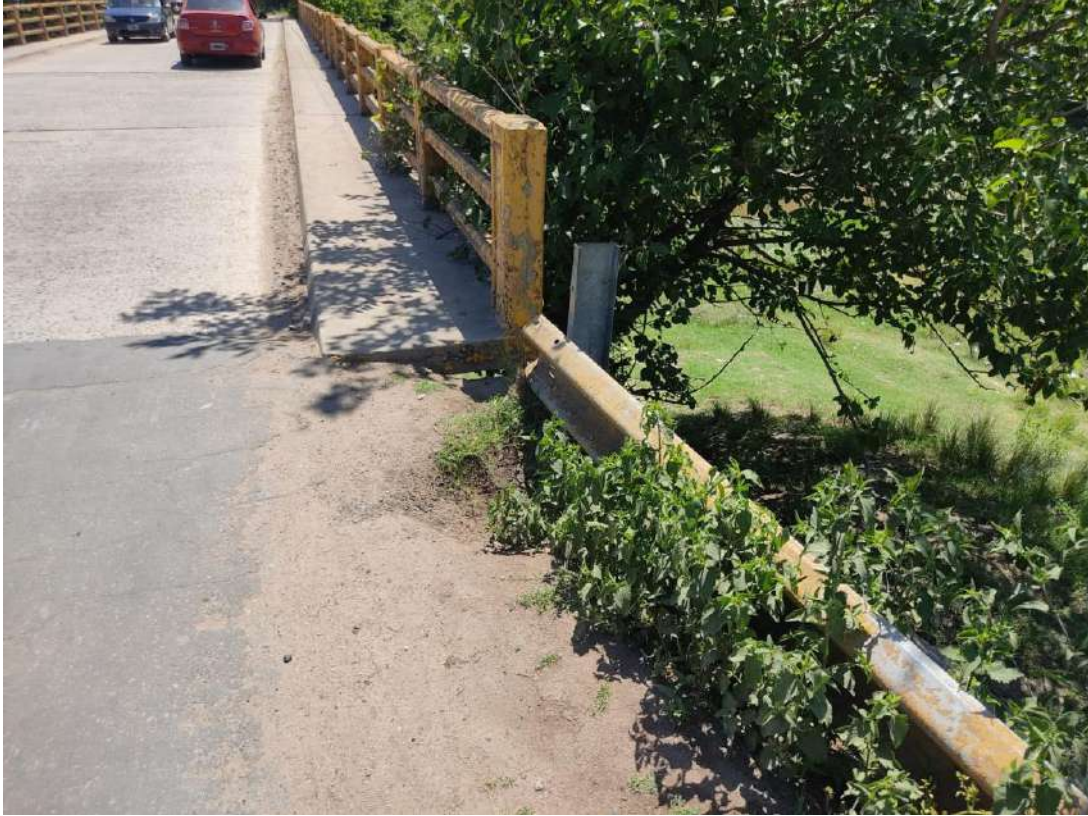
Imagen 14: Transición de defensa vehicular inexistente (margen Merlo)
