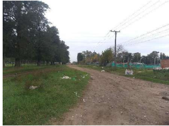
Vista general de la Av. Balaguer entre Falla y Linneo.
