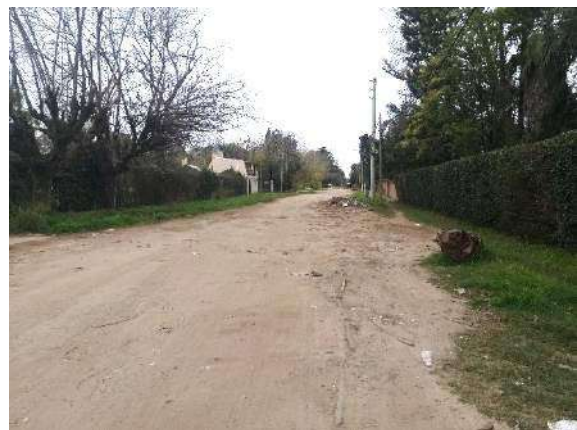
Vista general de la calzada actual de la Av. Miero.
