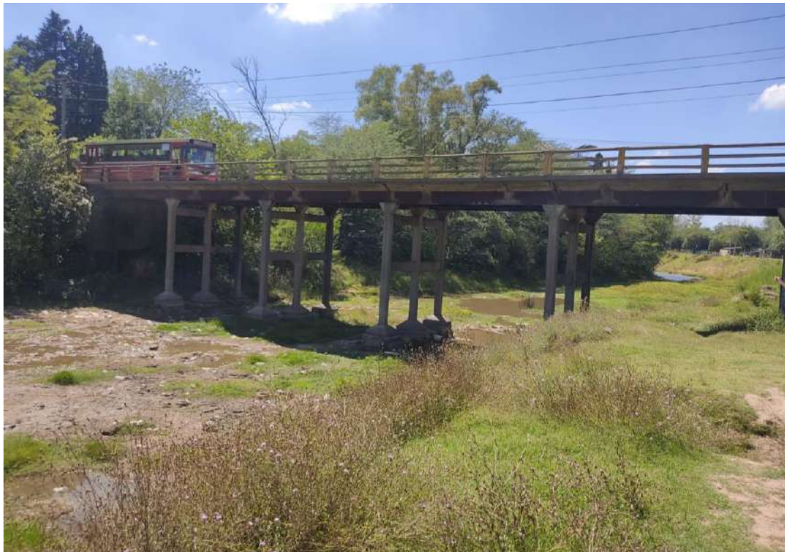
Imagen 1: Vista general del puente
