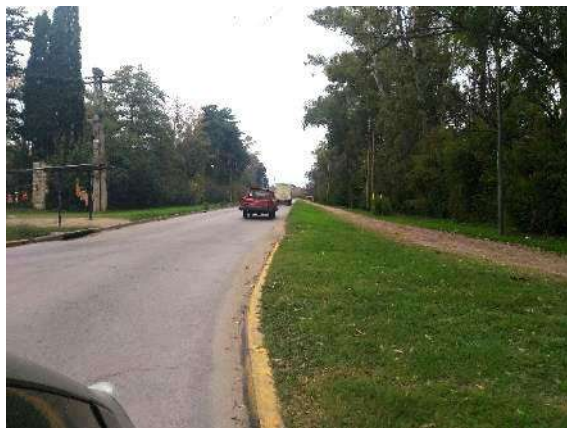
Vista de la calle Tiziano pavimentada, pero en estado irregular, hacia el puente sobre el río Reconquista que conduce hacia Merlo.
