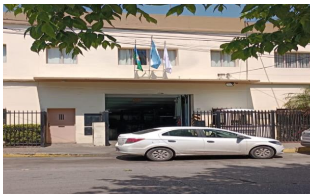
Figura 63. Referencia 10. Fábrica de Autopartes Romet. Libertad y Santa Cruz
