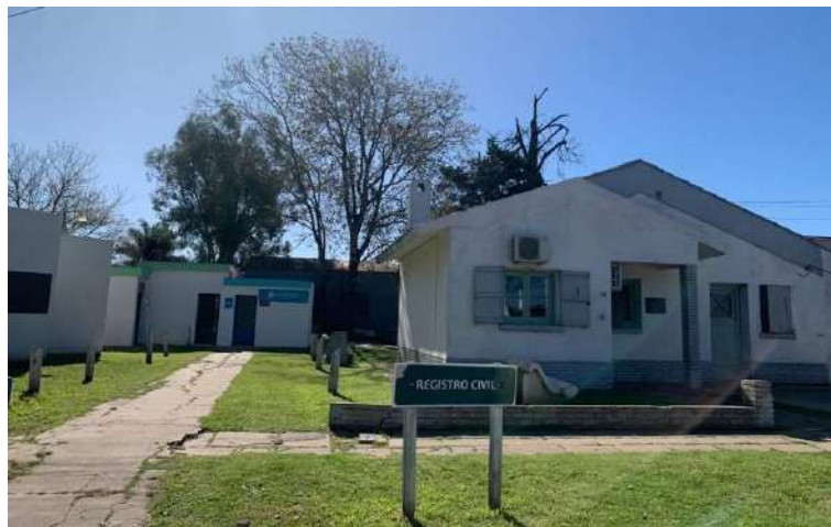
Foto 3.5-13. Vista Unidad Sanitaria Arroyo Dulce (der.) y Registro Civil (izq).
