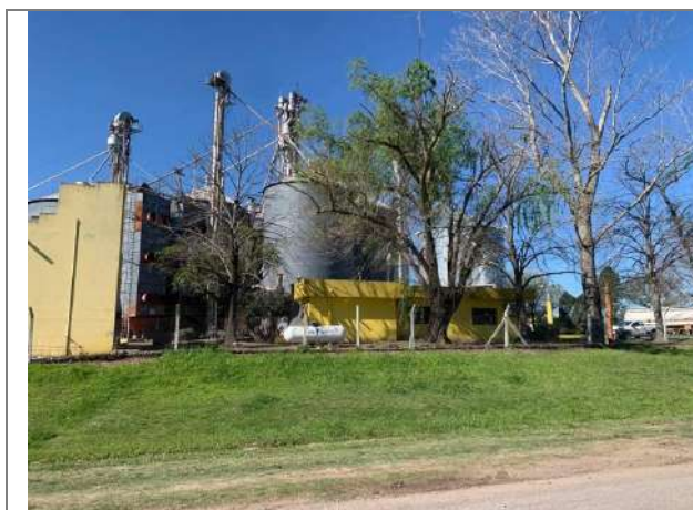
Foto 3.5-1. Silos y espacios de acumulación de granos y cereales en la localidad de Arroyo Dulce.
