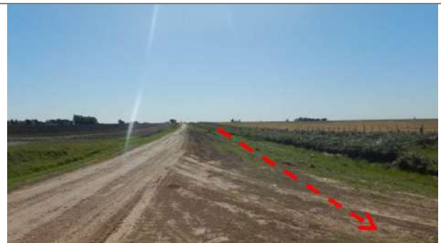
Foto 3.6-110. Vista al O, camino municipal. S34 ° 4'31.86"; W60 ° 26'11.66"
