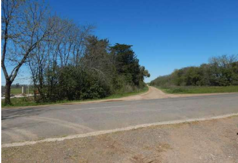
Foto 3.5-8. De izquierda a derecha se visualiza la Vía de ingreso a Rancagua. A la izq. el sitio de implantación de ERP Rancagua. También se visualiza camino de tierra por donde continuaría el ducto. Vista hacia el este.
