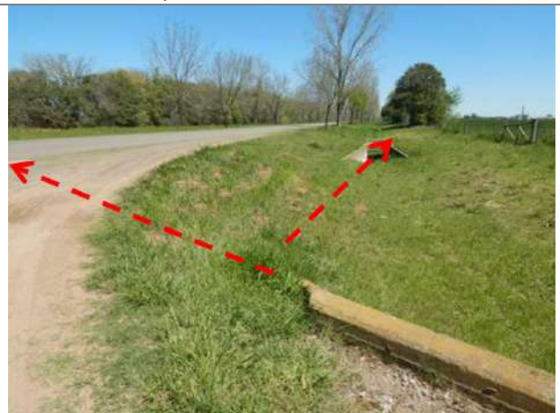
Foto 3.6-54. Vista al SO, intercepción con la calle Dr. Raúl Santoro e ingreso principal a Rancagua. La traza se bifurca y el gasoducto que se dirige hacia Rancagua, continúa por Santoro manteniendo el lado derecho. Existe presencia de cunetas a los costados de la misma. Al fondo, se observa ingreso a campo con sus respectivas canalizaciones y puentes. S34°0'47.82"; W60°29'29.88"
