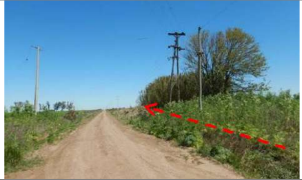
Foto 3.6-40. Vista al SO, en la ante esquina del camino municipal que intercepta la traza se observa un parche vegetativo, además de hierbas altas. S33° 59'56.60"; W60° 30'2.23"
