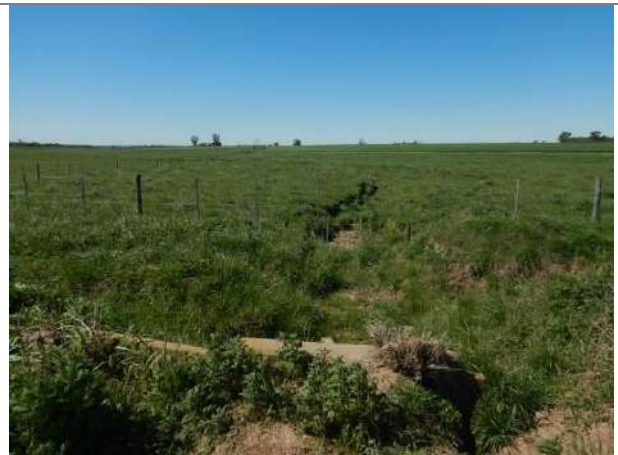
Foto 3.6-87. Vista al SE, lecho de un arroyo seco y canalización debajo del camino rural. S34 ° 2'46.02"; W60 ° 27'48.35"
