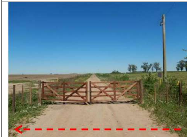
Foto 3.6-5. Vista al SO, tranquera que impide el acceso al camino vecinal. Se observa el cruce de líneas de baja tensión, donde una sigue en paralelo a la RP N°32 y la otra al camino vecinal. S33° 57'22.19"; W60° 32'32.94"
