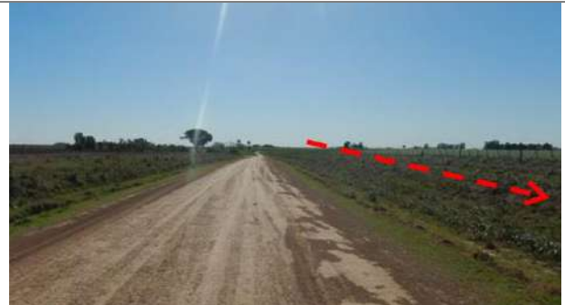
Foto 3.6-108. Vista al oeste, camino municipal. S34 ° 4'20.65"; W60 ° 26'35.41"
