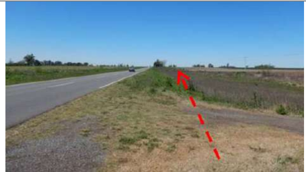
Foto 3.6-18. Vista al SE, la traza iría del lado del lado derecho de la RP N°32. Se observa entrada a un campo. S33° 58' 7.42"; W60° 31' 41.03"
