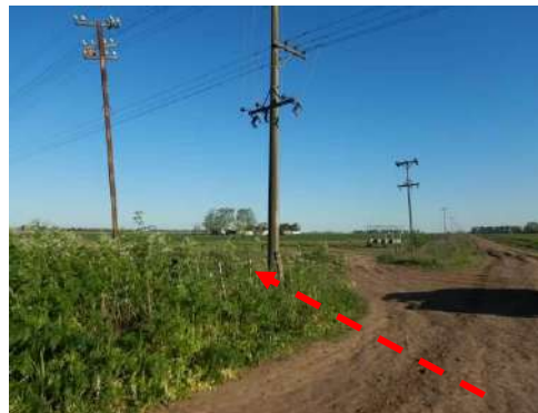
Foto 3.6-26. Vista al SE, la traza continuaría girando hacia la izquierda en la intersección de caminos vecinales. Se observa, también, el cruce de dos tendidos eléctricos y el ingreso alternativo a una estancia.
