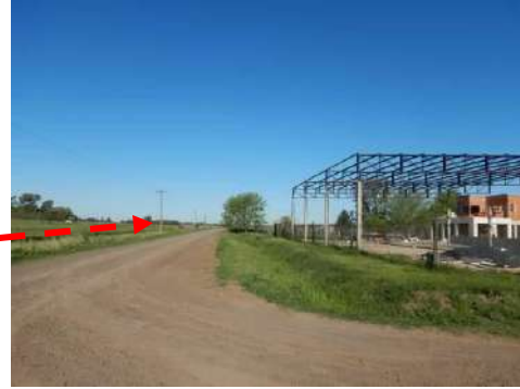
Foto 3.6-5. Vista al E, intersección de calles internas de Fontezuela, la traza iría del lado izquierdo del camino rural. S33° 54' 29.92"; W60° 27' 33.11"
