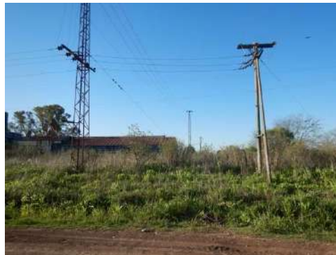
Foto 5.2-45. Vista al N, Cruce tendidos eléctrico. S33° 55' 32.96"; W60° 23' 37.69"
