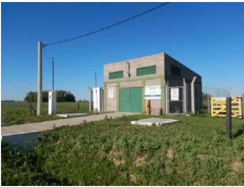
Foto 3.6-1. Vista NE, frente de la ERP 15/1,5 bar de Fontezuela. S33°54'28.15"; W60°27'40.27
