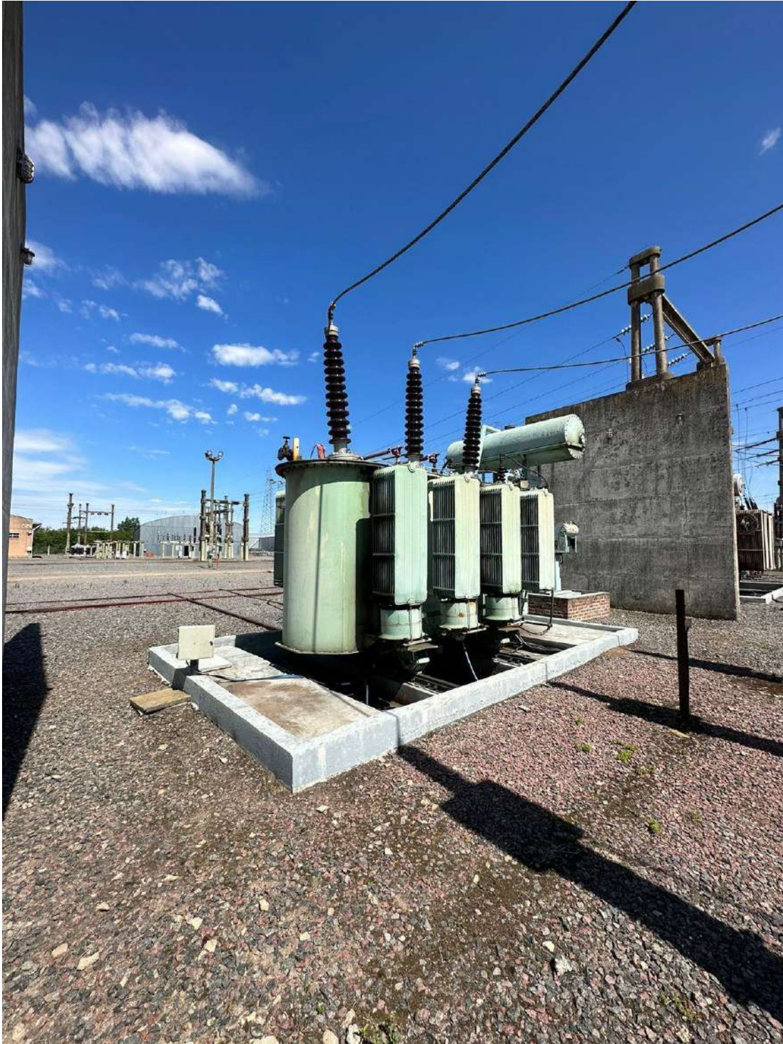
Fotografía 10 – Area obra de implantación exterior lado 132 kV
