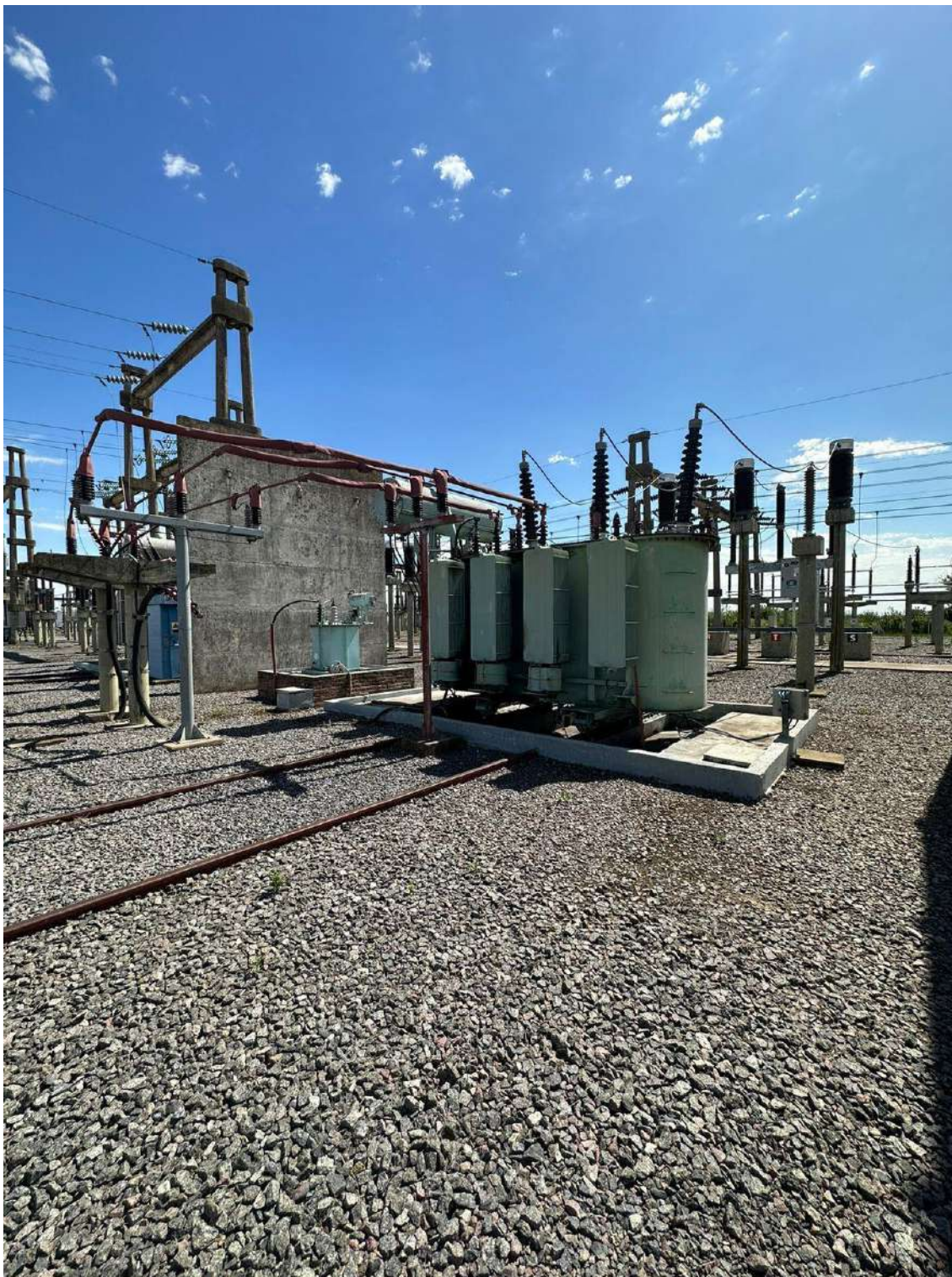
Fotografía 9 – Area obra de implantación exterior lado 33 kV
