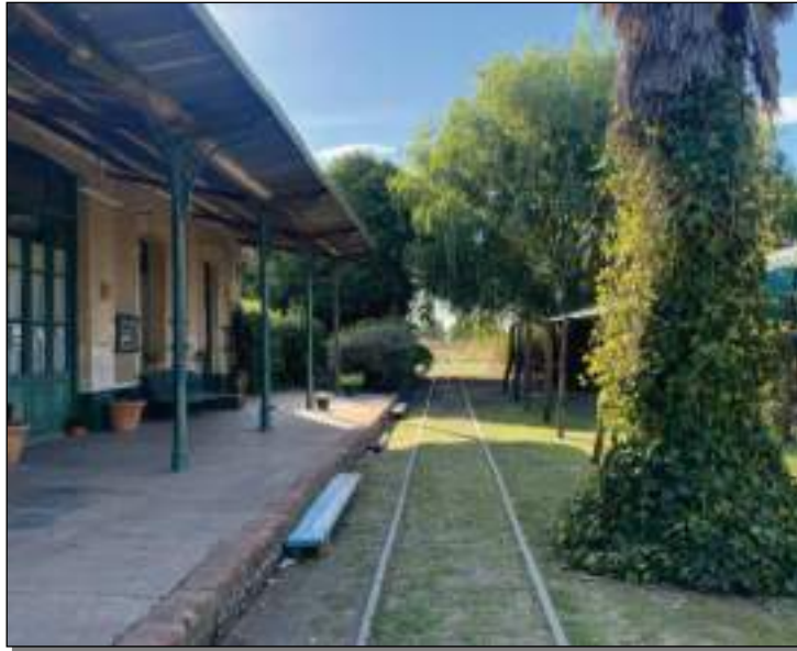
Figura 49: Estación de Gouin.
