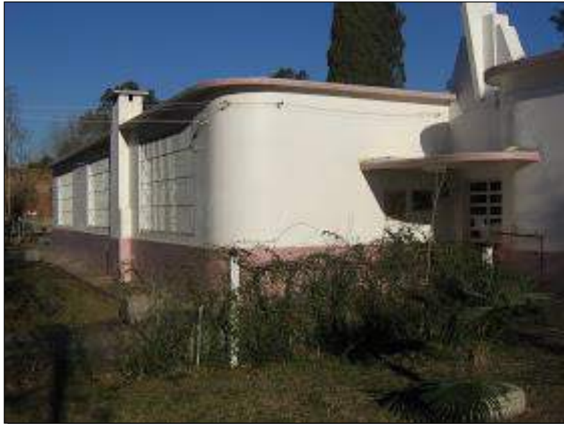
Figura 40: Escuela N°12 Faustino Sarmiento. Gouin.
