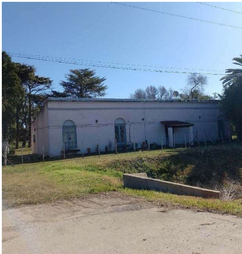
Figura 2-60. Vivienda contigua a parcelas 12 y 13 en parcela no afectada.
