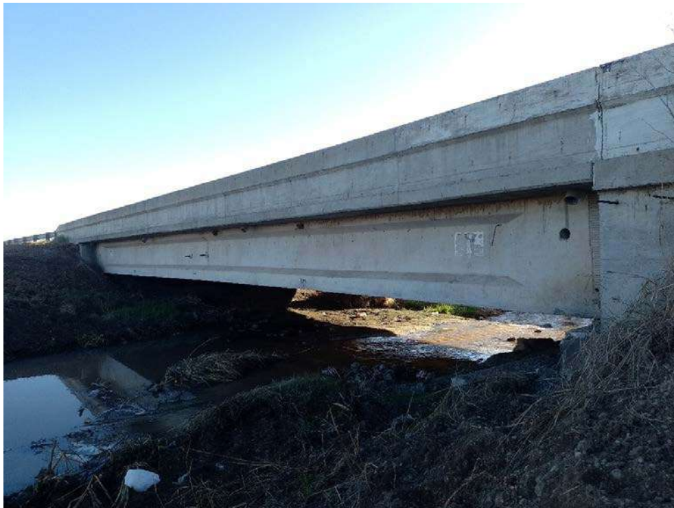
Figura 2-15. Puente de RP6 sobre Arroyo de Cebey.
