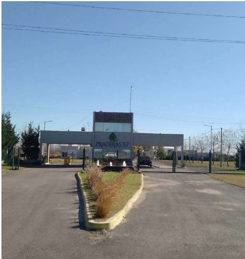
Figura 2-26. Ingreso a Barrio Cerrado Pradera 57, sobre RN3.
