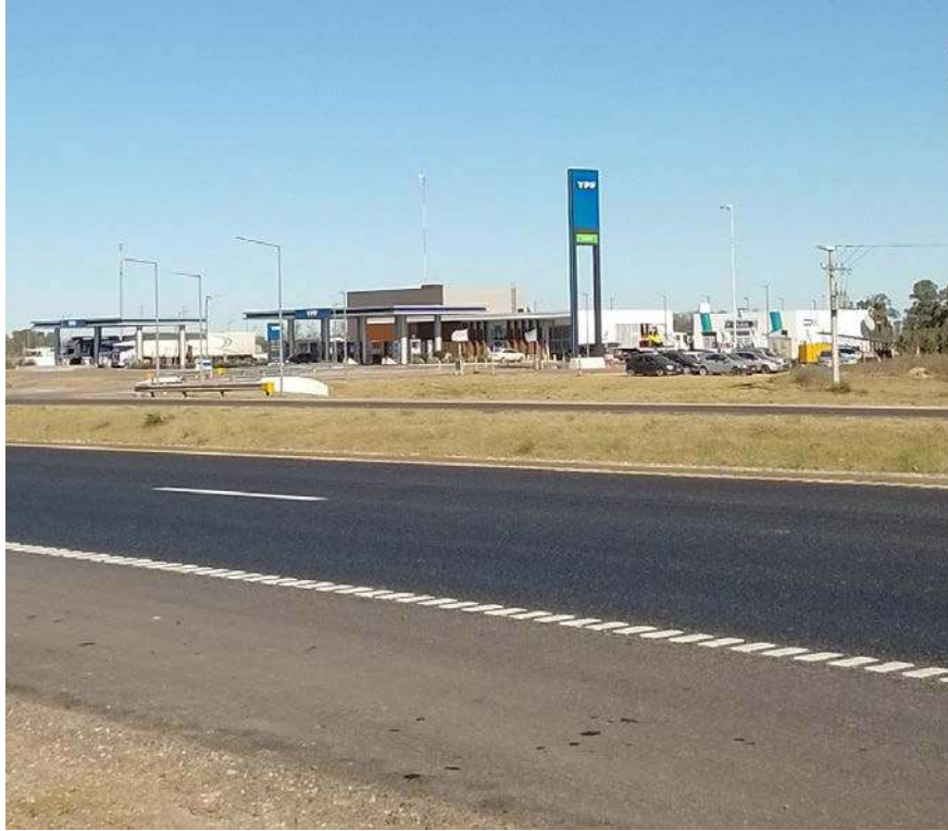
Figura 2-8. Estación de Servicio YPF sobre RP6, mano General Las Heras-Cañuelas.
