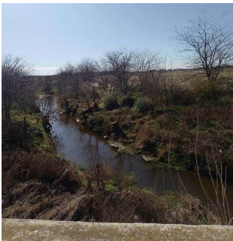
Figura 2-7. Vista del Arroyo Rodríguez desde el puente en RP6.
