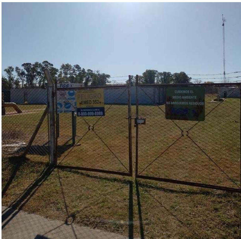
Figura 2-12. Instalaciones del gasoducto Anillo GBA en el extremo NE del R6.1
