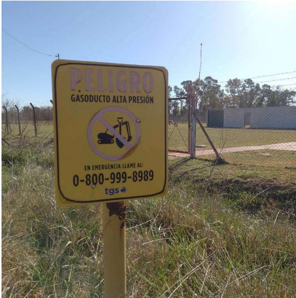
Figura 2-57. Instalaciones del gasoducto Anillo Gran Buenos Aires en el extremo NE del R6.1.
