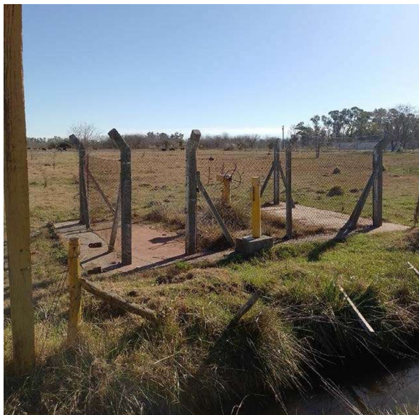
Figura 2-13. Infraestructura asociada al gasoducto Anillo GBA dentro de parcela ID 7. Observada desde camino rural al sur del reservorio.
