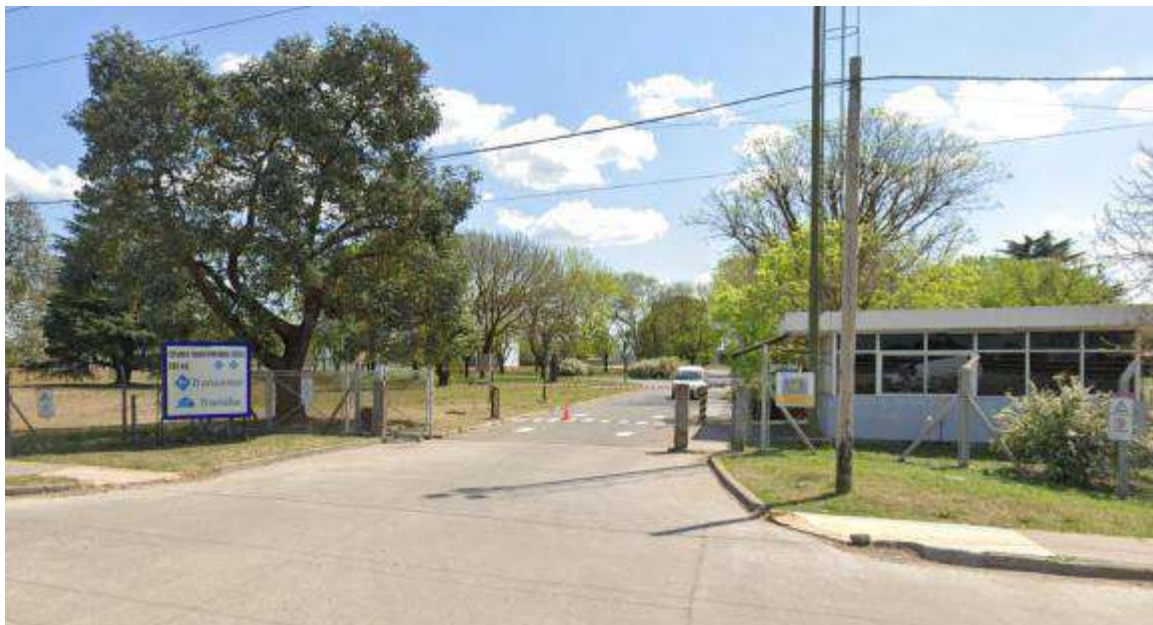
Foto 3.11. Vista del portón de acceso a la Estación Transformadora Ezeiza 500/220/132 kV. Se verifica cartelería de identificación del predio y barrera de acceso restringido.
