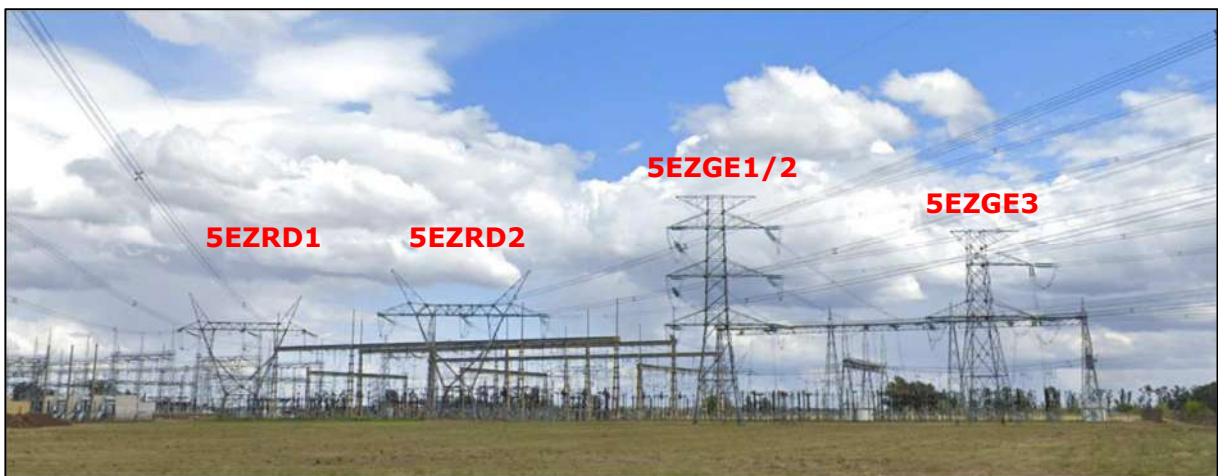
Gráfico 18. Torres terminales para LEAT en 500 kV
