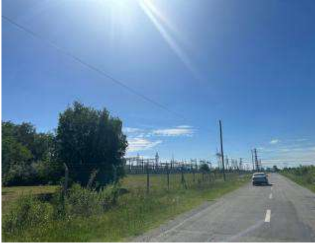
Foto 3.12. Vista del camino asfaltado de acceso a Genelba, por el que se accede al área operativa del proyecto.
