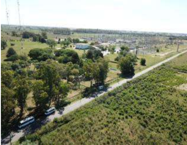
Foto 3.1. Vista aérea donde se observa el camino de acceso a ET, área descampada y otra arbolada. Y se verifica la infraestructura de la ET.
