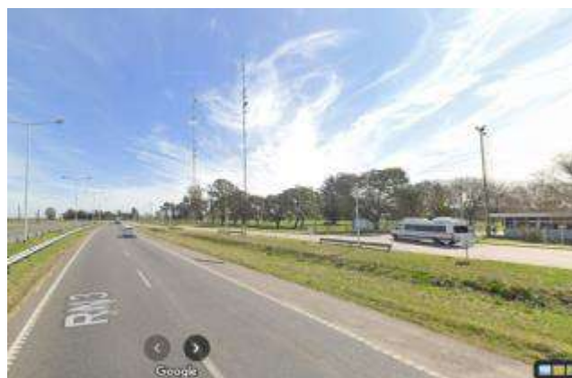
Foto 3.10. Vista desde la RNN° 3 donde se observa la garita de acceso a la Estación Transformadora Ezeiza.
