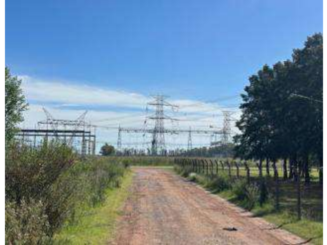
Foto 3.2. Vista del camino ubicado frente al sector del área operativa de la obra (enripiado), de las torres y tendido eléctrico de alta tensión.
