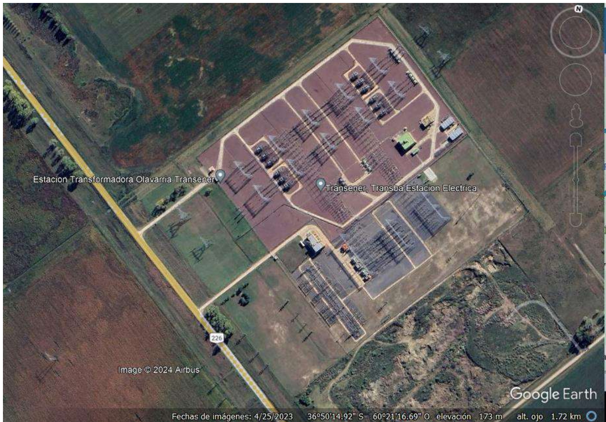
Figura 3.12. Imagen satelital donde se observa la infraestructura de la Estación Transformadora Olavarría, ubicada a la vera de la RN N° 226.
