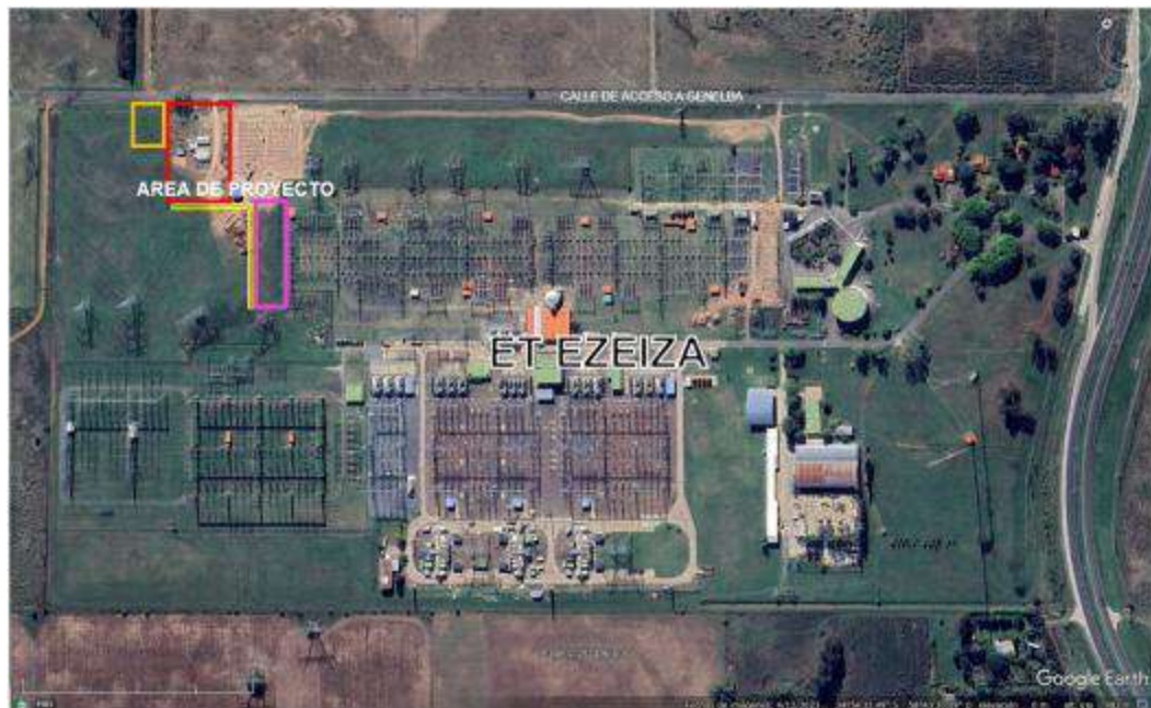
Figura 3.35. Vista de la ET Ezeiza y de los sectores donde se realizará el nuevo proyecto.
