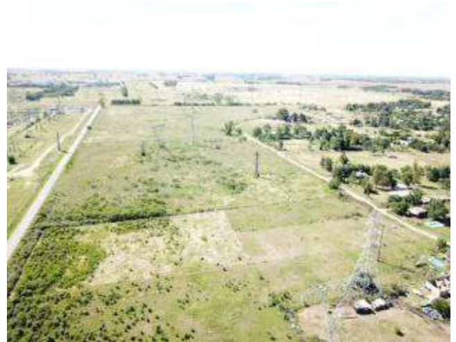
Foto 3.4. Vista aérea sobre el noreste de la ET Ezeiza, donde se observa las torres de alta tensión.
