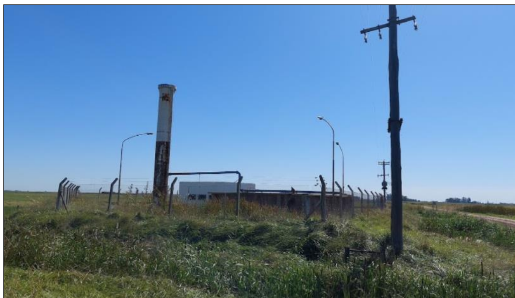
Figura 2: Estación de Rebombero French (Partido 9 de Julio).
