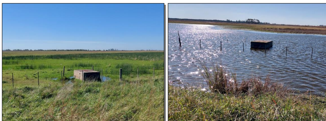
Figura 5: Ubicación de cámaras de registro del acueducto French-Carlos Casares.
