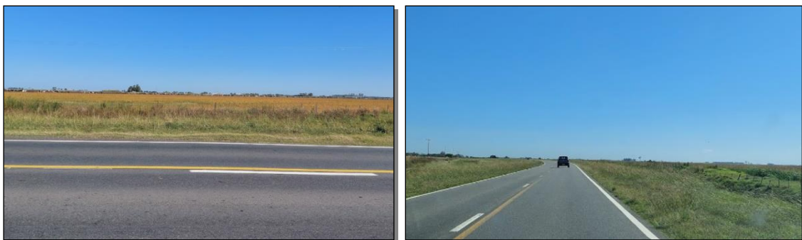
Figura 3: Tramo del Acueducto French–Carlos Casares.
