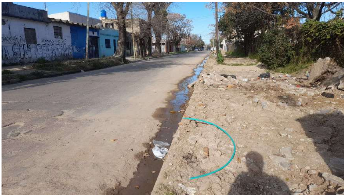
Anexo 3. Imagen correspondiente a la calle Bueras y Posadas de acceso a zona de obra . Fecha 5/8/23.
