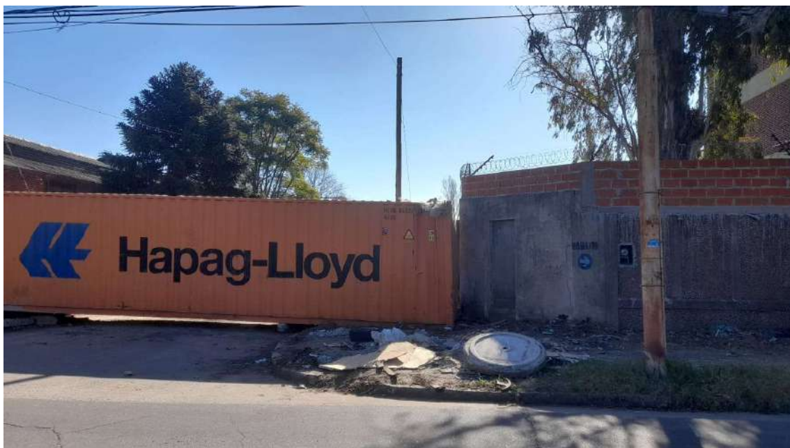
Anexo 10. Imagen correspondiente al container ubicado sobre la calle Bolaños salida a calle Posadas (sobre la calle Bolaños), imposibilitando el acceso al parque industrial CEPILE. Fecha 5/8/23.
