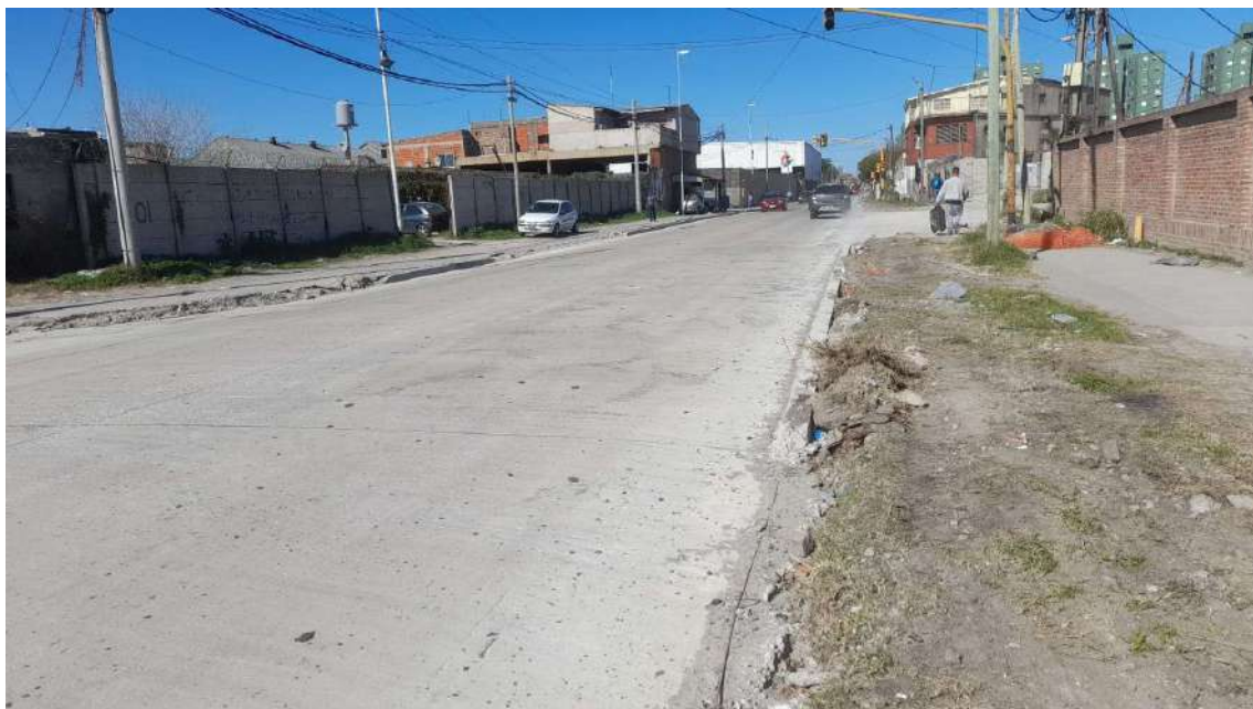
Anexo 24. Imagen correspondiente a la calle Camino General Belgrano (lindero a viviendas residenciales y la empresa de sanitarios "ROCA"). Fecha 5/8/23.
