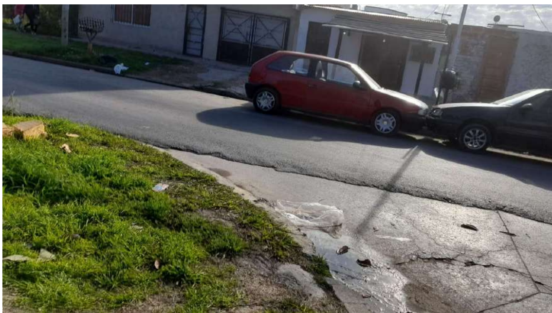
Anexo .6 Imagen correspondiente a la calle Posadas, en la que se puede visualizar la fachada de las casas que impiden el acceso al parque industrial CEPILE. Fecha 5/8/23. ZONA DE INFLUENCIA.
