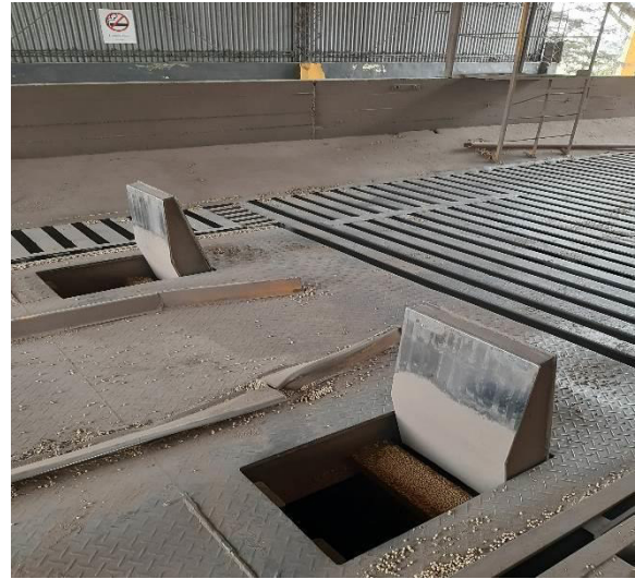
Figura. Vista sector de descarga de los silos de 5000 tn y 1500 tn (izquierda); pasarela de descarga de camiones (derecha)
