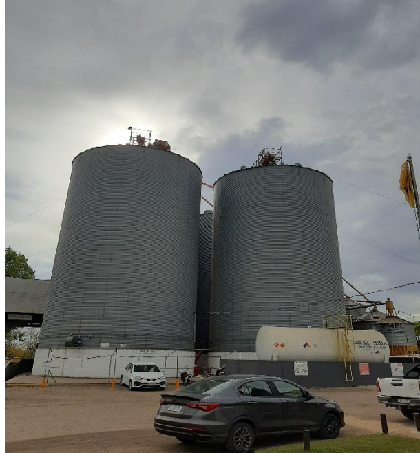
Figura: Vista de silos n° 5 y 6
