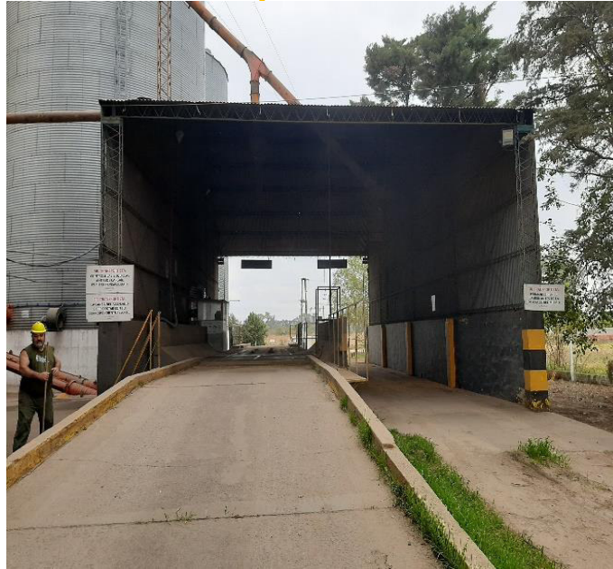
Figura. Vista de sector de descarga de silos.
