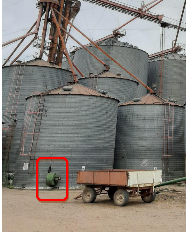
Figura: Vista de ventilador presente en uno de los silos de planta.
