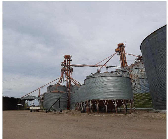
Figura: Vista sector de descarga de los silos de 5000 tn y 1500 tn (izquierda); Vista sector de descarga de los silos de 190 tn y 400 tn (derecha)
