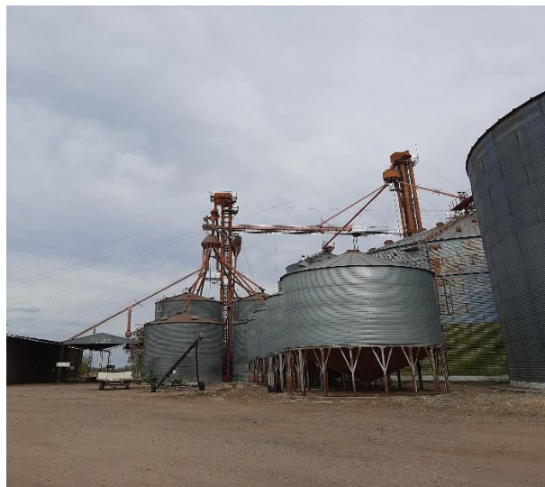
Figura. Vista sector de descarga de los silos de 190 tn y 400 tn
