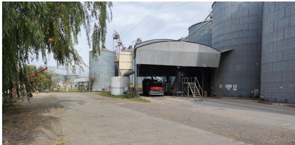
Figura: Vista sector de descarga de los silos
