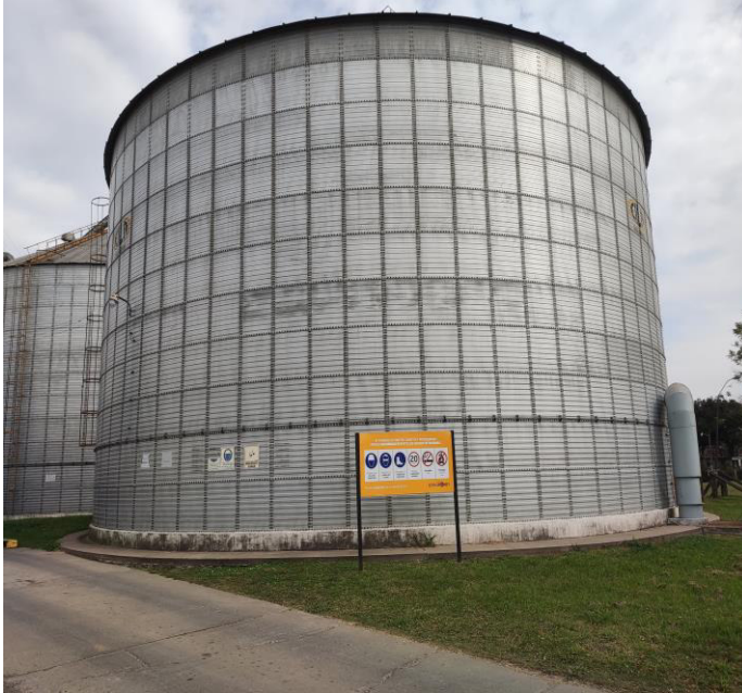
Figura: Vista de uno de los silos de 8000 tn (izquierda); y vista de silo de 3500 tn con su respectivo silo de descarte (derecha)
