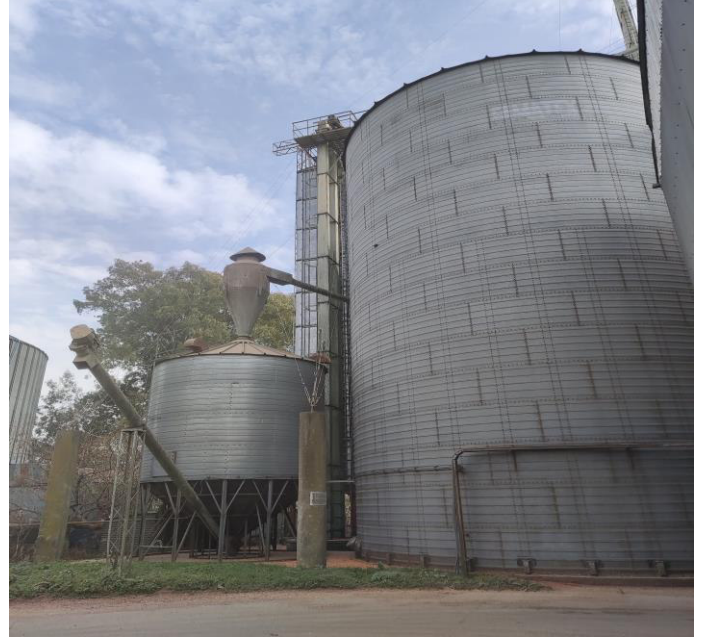
Figura: Vista de uno de los silos de 8000 tn (izquierda); y vista de silo de 3500 tn con su respectivo silo de descarte (derecha)
