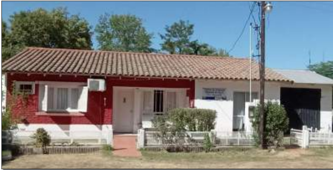
Figura 43: C.A.P.S Tres Sargentos sobre la calle principal San Martín.
