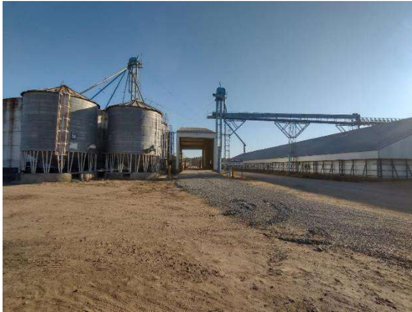
Imagen 21. Silos y celdas de almacenaje Planta La Fábrica.
