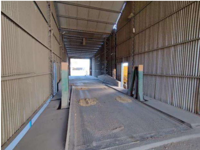
Imagen 15. Sector carga/descarga de camiones Planta 3.
