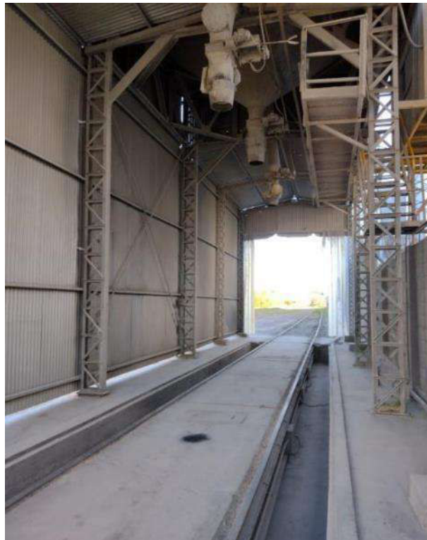
Imagen 25. Sector de carga de vagones en Planta 2.
