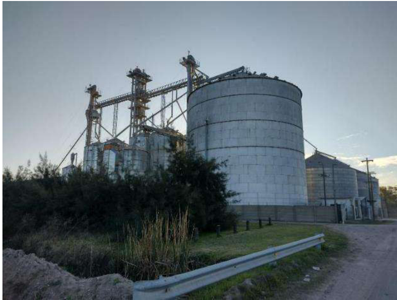
Imagen 19. Silos de almacenaje y norias en Planta 2.
