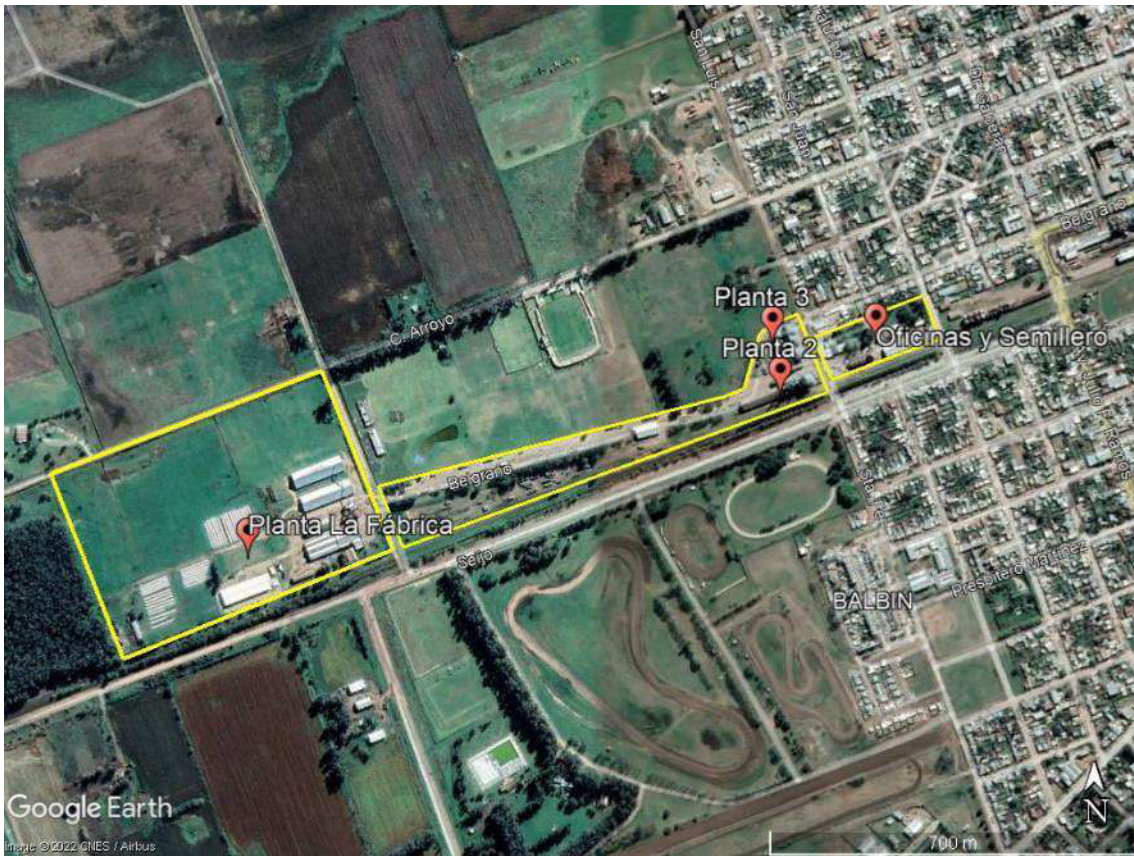
Imagen 01. Vista ubicación sectores Planta Carlos Casares.
