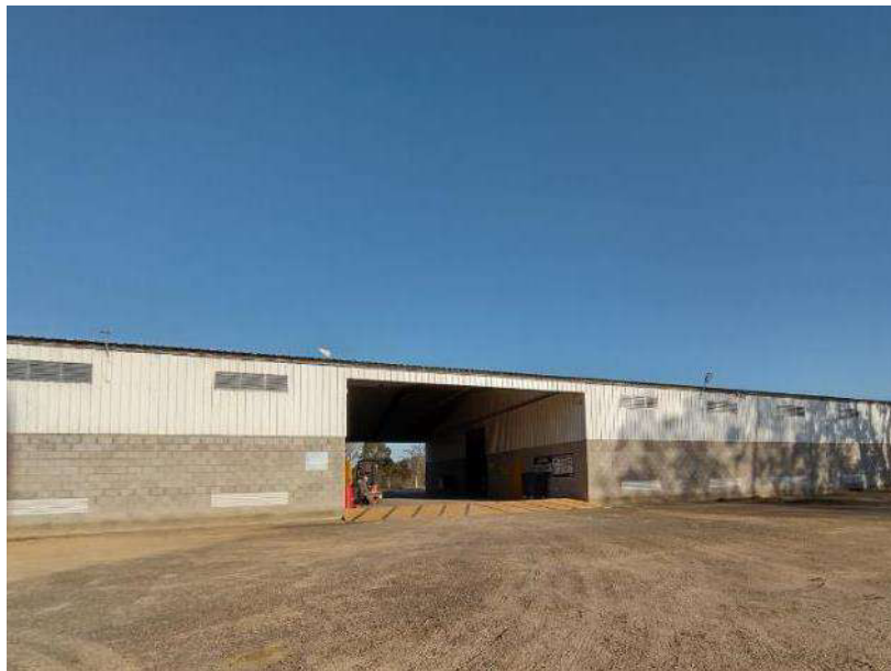
Imagen 28. Depósito de fitosanitarios en Planta La Fábrica.
