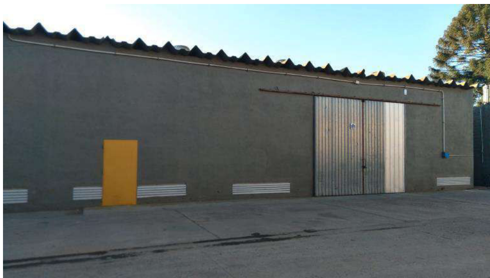
Imagen 32. Área de almacenamiento de lubricantes.
