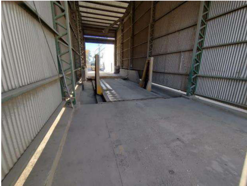
Imagen 14. Sector de carga/descarga de camiones Planta 2.
