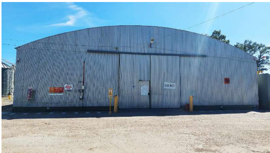
Imagen 17. Depósito de agroquímicos.
