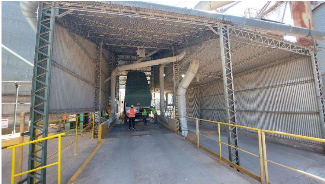
Imagen 8. Sector 2 de carga y descarga de camiones.
