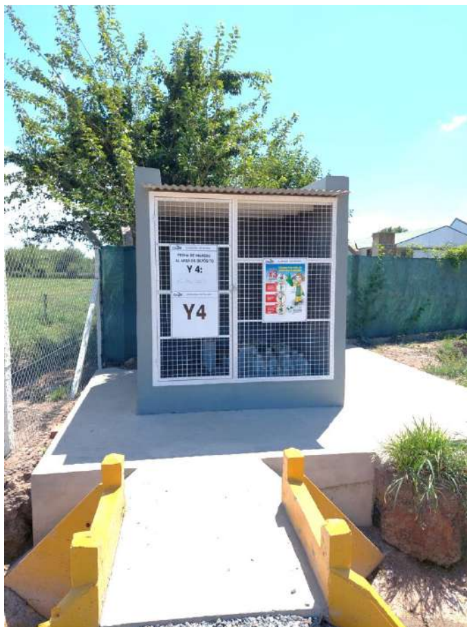
Imagen 20. Vista depósito transitorio de residuos especiales (nuevo).
