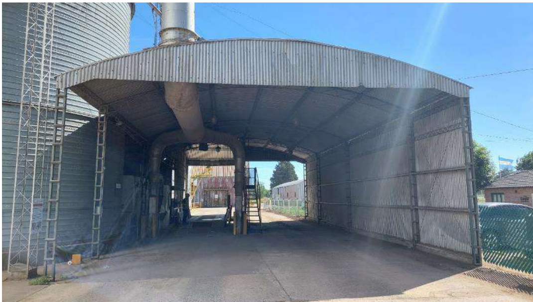
Imagen 7. Sector 1 de carga y descarga de camiones.
