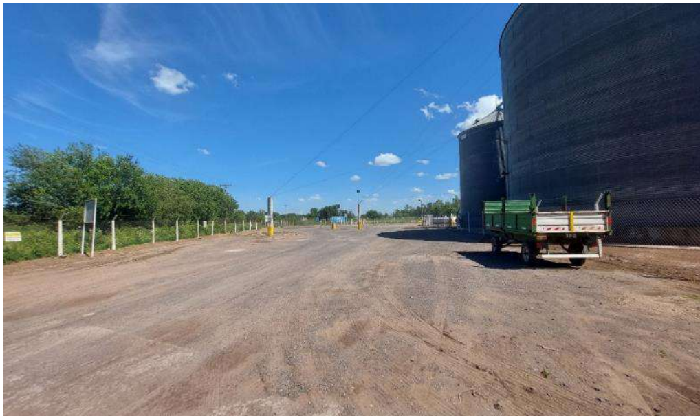
Imagen 5. Playa de Estacionamiento de camiones.
