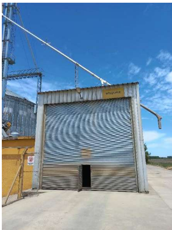
Figura: Vista de la salida de camiones del sector de Carga/Descarga, el cual posee portones corridizos para su cierre.
