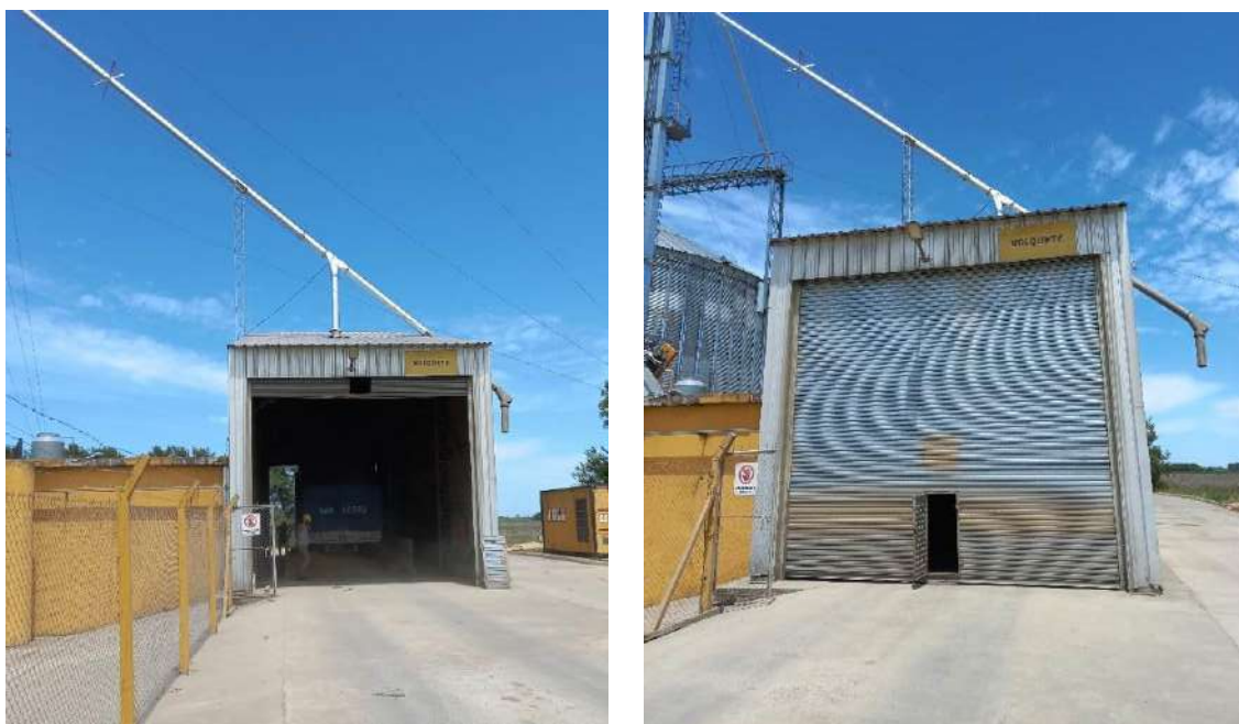
Figura: Vista del sector de carga/descarga de granos con cortina abierta y cerrada que garantiza un cierre completo del recinto a la hora de descarga del grano.
