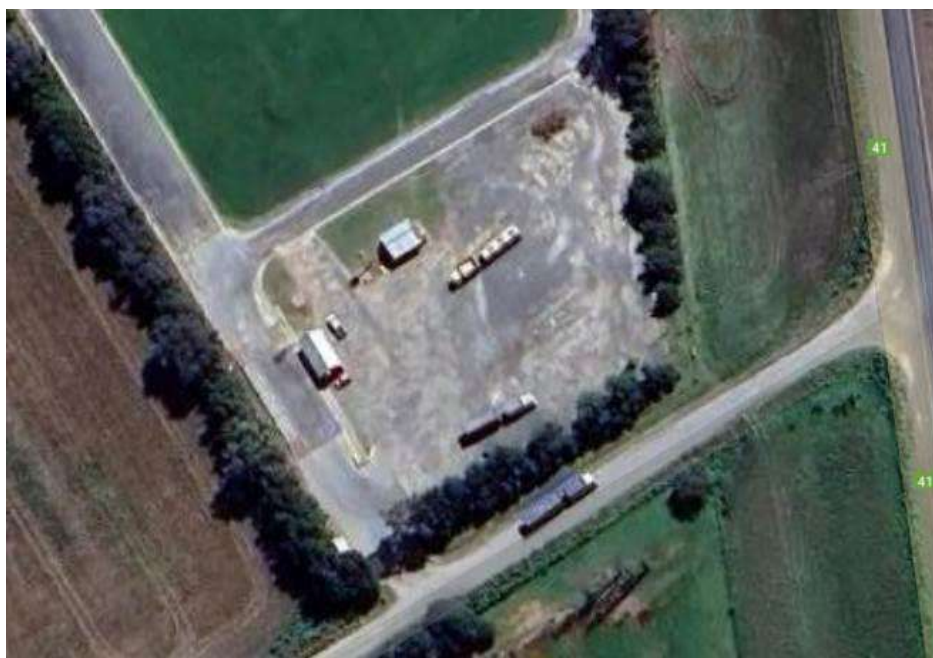
Figura: Vistas en detalle y Vista aérea de la Playa de Camiones.
