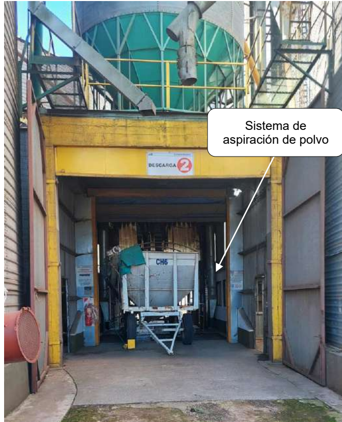
Imagen 15. Sector de descarga de camiones Planta 2.
