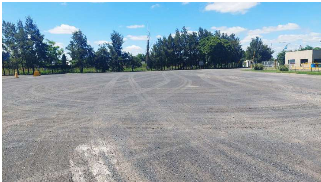
Imagen 7. Playa de Estacionamiento de camiones Planta 1.
