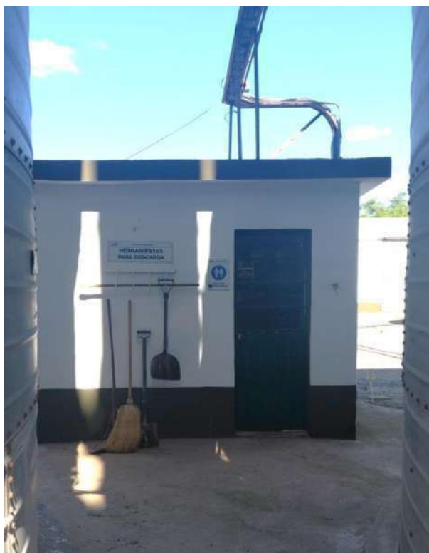
Imagen 16. Cabina de control Planta 2.
