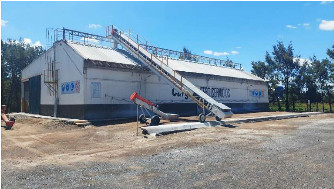
Imagen 22. Depósito de agroquímicos.
