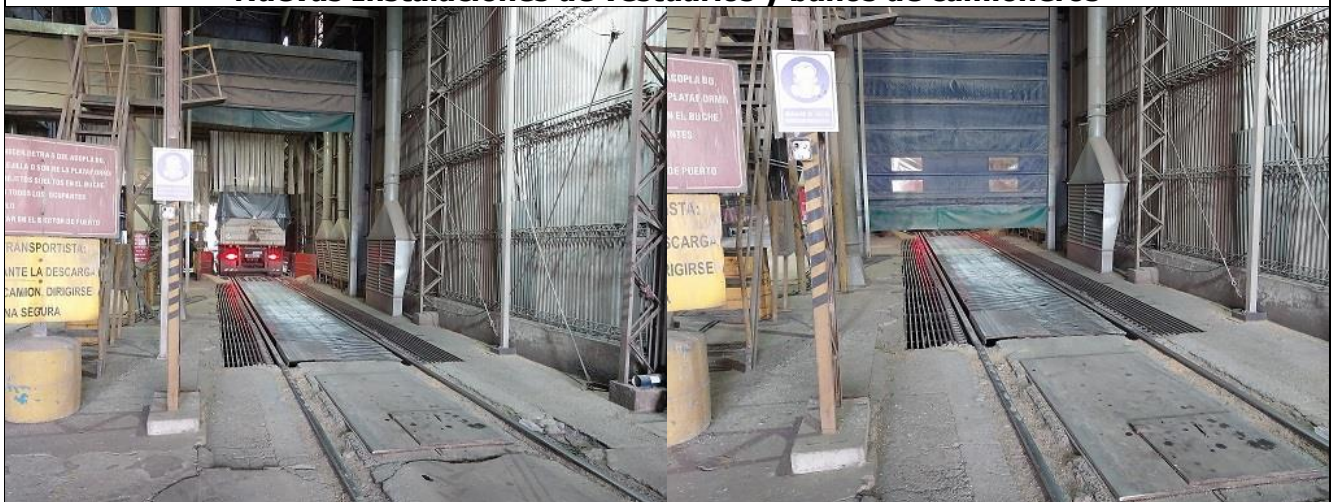
Descarga de Camiones
