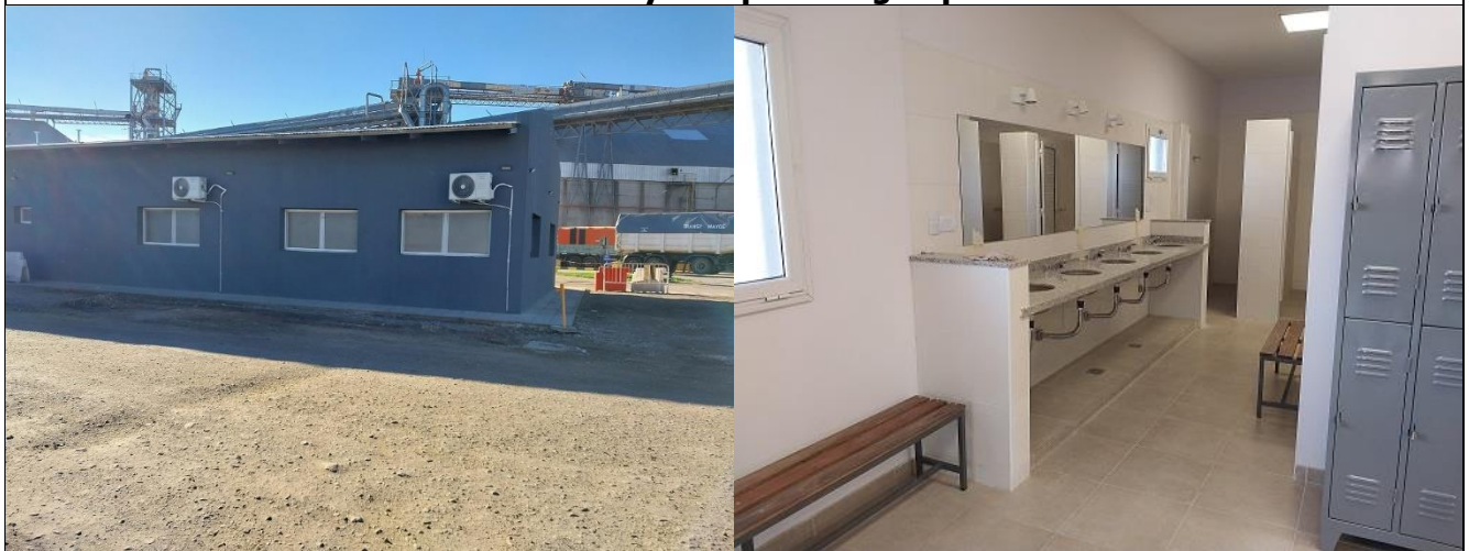
Nuevas Instalaciones de vestuarios y baños de camioneros
