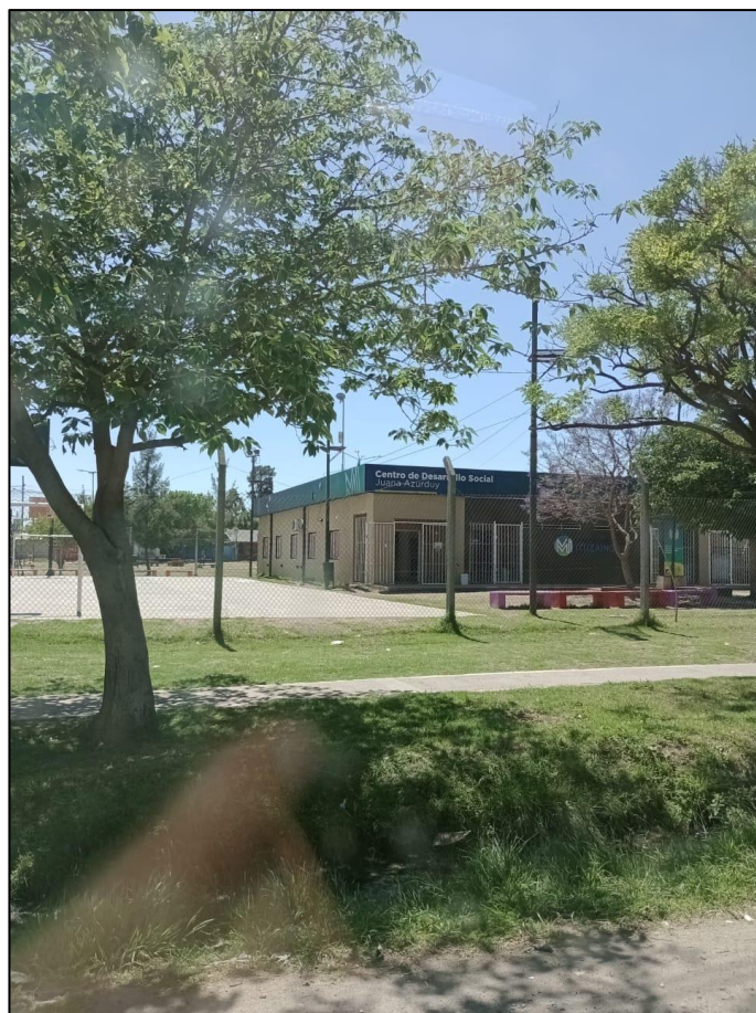
Figura 70. 13- Centro Municipal de Desarrollo Social Juana Azurduy, ubicado en Plaza Juana Azurduy - Haití 3475
