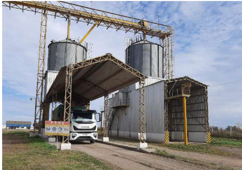
Imagen: Vista de los sectores de carga de granos en camiones y vagones.
