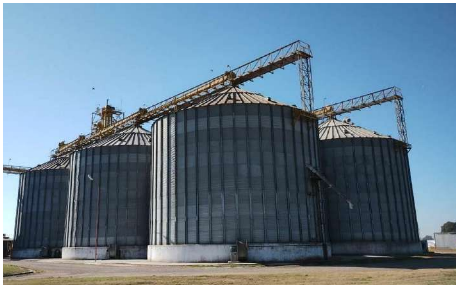
Imagen: Vista de la batería de silos del predio.
