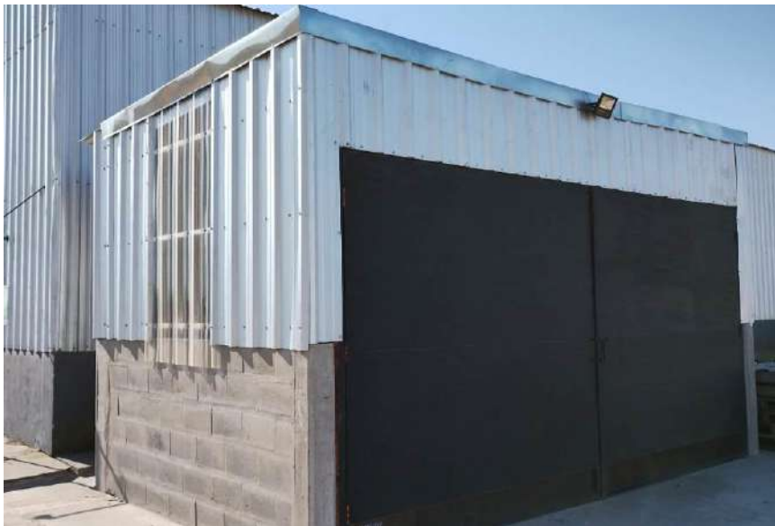
Figura: Vista del Depósito Transitorio de Residuos Especiales.
