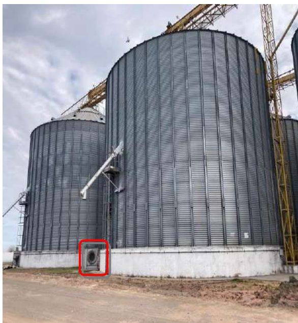
Imagen: Vista de ventilador presente en uno de los silos de planta (izquierda) y vista del ventilador en detalle presente en la planta (derecha)
