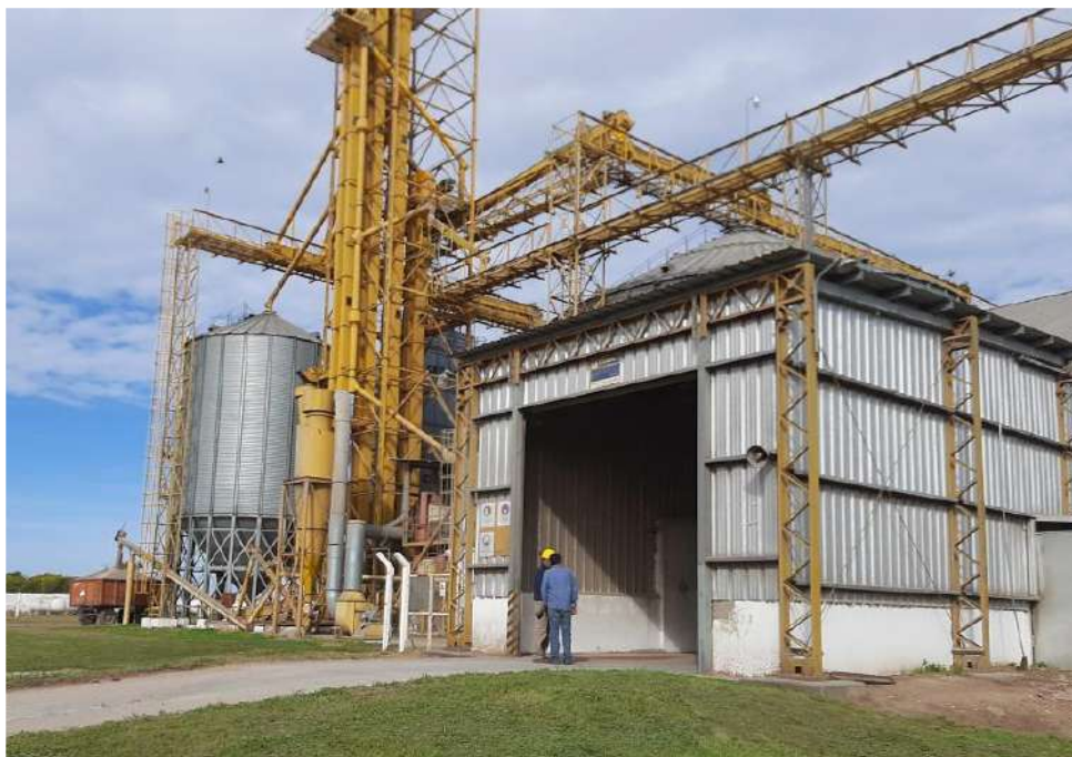
Imagen: Vista de la Zona de Descarga de Granos.
