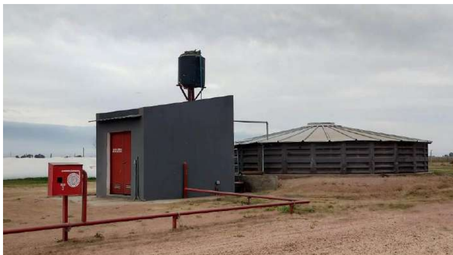
Figura: Vista exterior de la Sala de Bombas y Tanque de Agua de Reserva de la Red Fija de Lucha contra Incendio.
