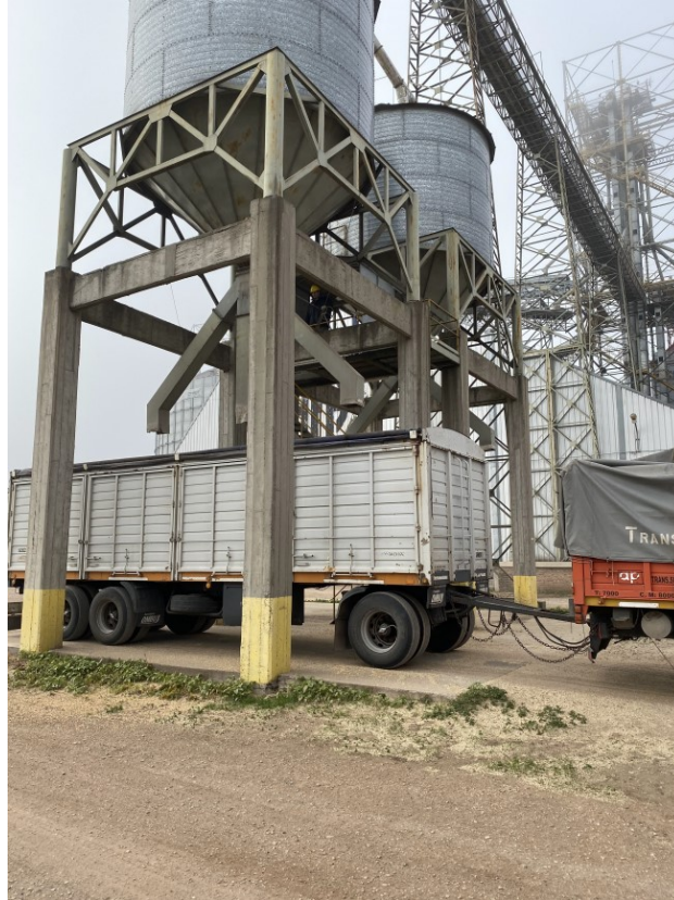
Imagen N°24: Vista del cargadero de camiones ubicado en forma exterior
