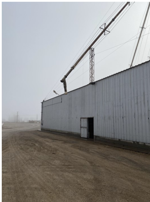
Imagen N°12: Conducto de carga de fertilizantes a camiones
