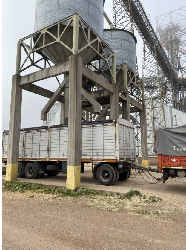
Imagen N°3: Tolvas de carga de camiones (posicionados debajo de las mismas)
