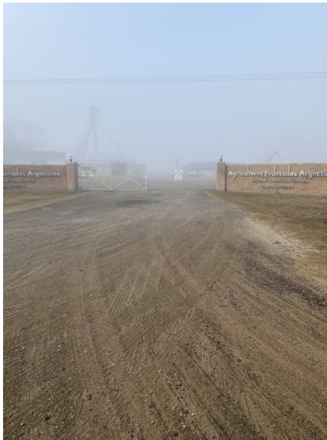
Imagen N°19: Vista del acceso a planta
