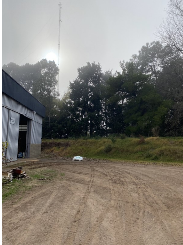
Imagen N°21: Vista posterior depósito de agroquímicos
