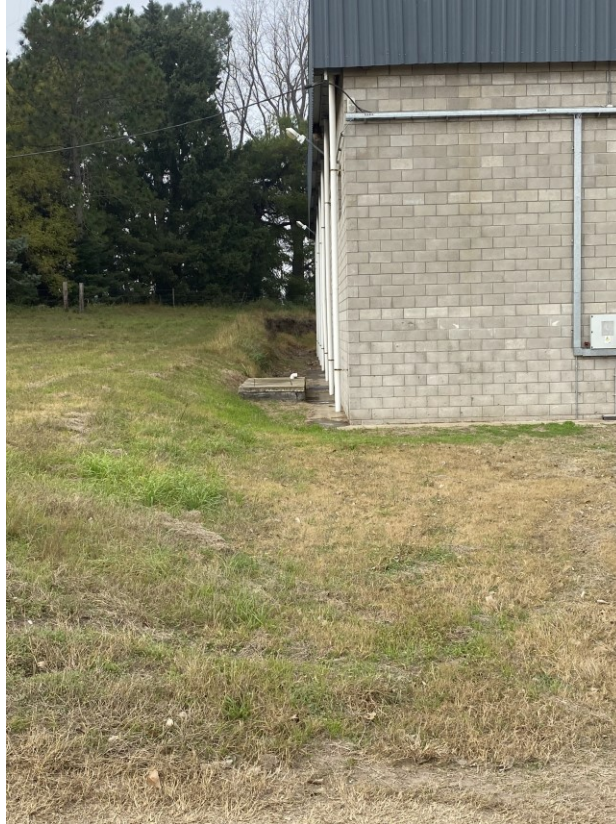
Imagen N°15: Vista de la ubicación de la cámara de contención de derrames exterior
