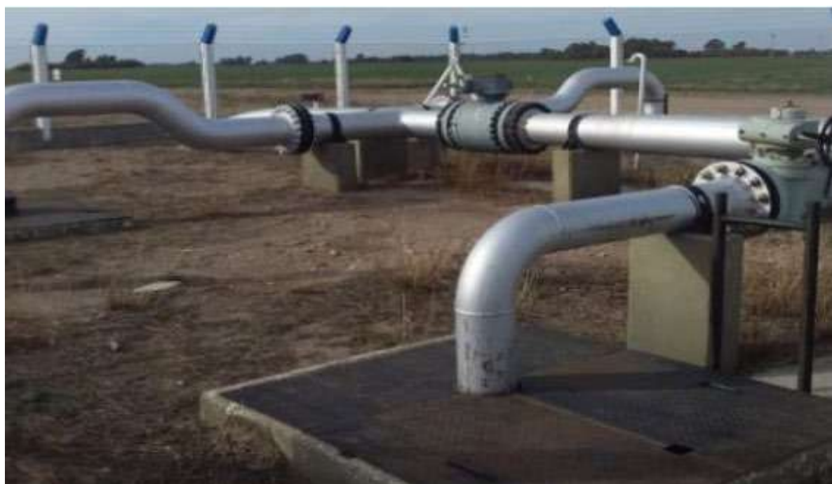
Figura 3.15 Vista Interconexión K20 PK 539+700 L1 y PK428+500 L2.
