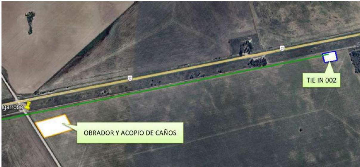
Figura 3.4 Tramo 1 – L1. Vista de sector de obrador y acopio de caños y TIE IN 002
