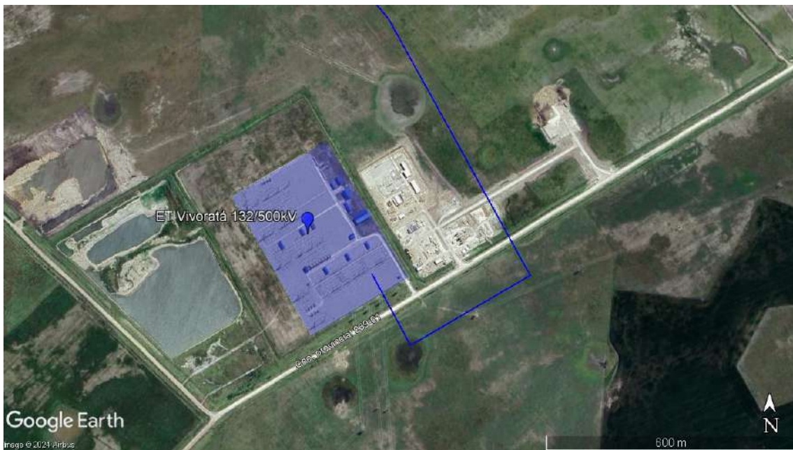
Imagen 8. Ingreso LAT 132 kV a ET Vivoratá 132/500 kV. Fuente. Google Earth/GENNEIA SA.
